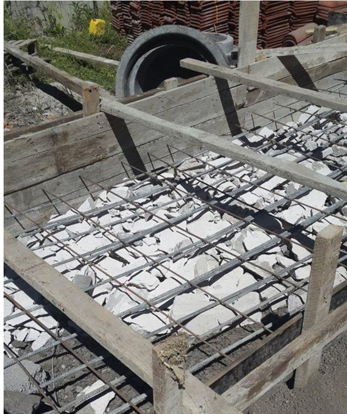
Şekil 4. 14 Beton Yapısal Atıkların Blokaj Olarak İkincil Kullanımı
