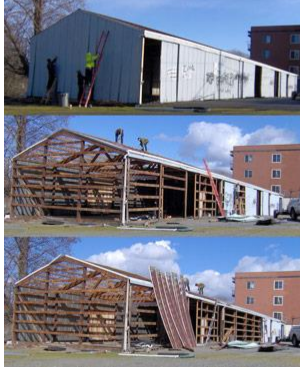
Şekil 4. 2 Yapı Sökümü [53]
