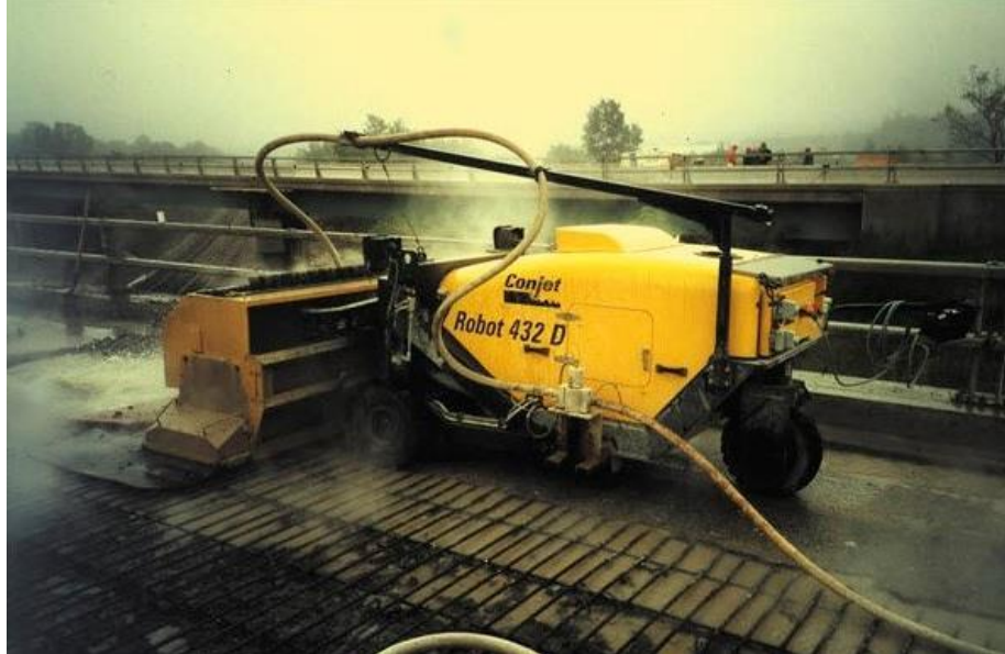
Şekil 4. 10 Su Jeti ile Betonarme Yapı Yıkımı[62]
