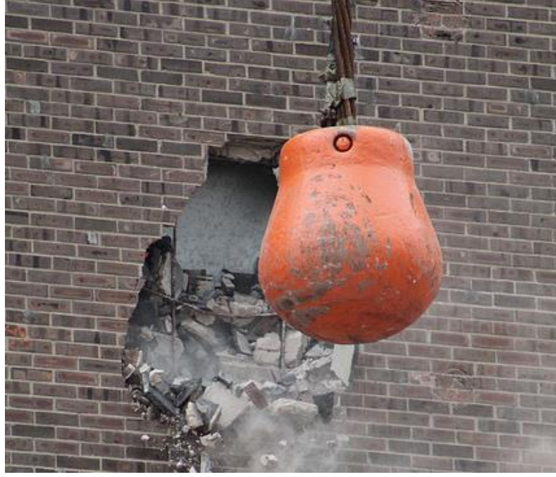
 ekil 4. 6 G lle ile Yıkım[58]
