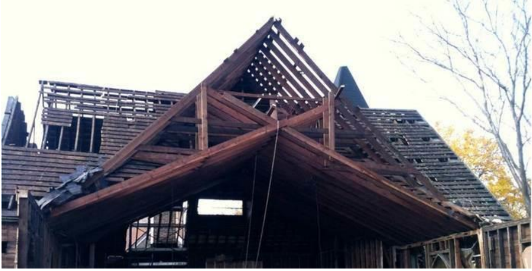
Şekil 4. 4 Çatı Sökümü[55]
