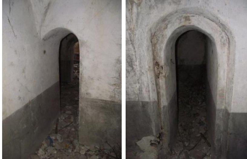
Şekil 7.19. Yeşil Ada Hamamı'nın M3 nolu halvet mekanına ait kapının halvetten ve sıcaklıktan görünümü
