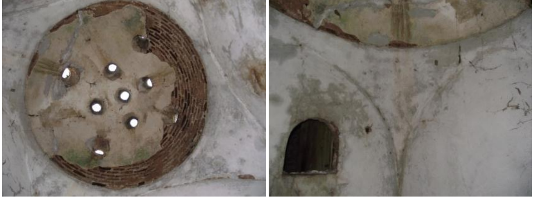
Şekil 7.45. Yeşil Ada Hamamı'nın M4 nolu halvete ait kubbe ve kubbeyi taşıyan pandantif
