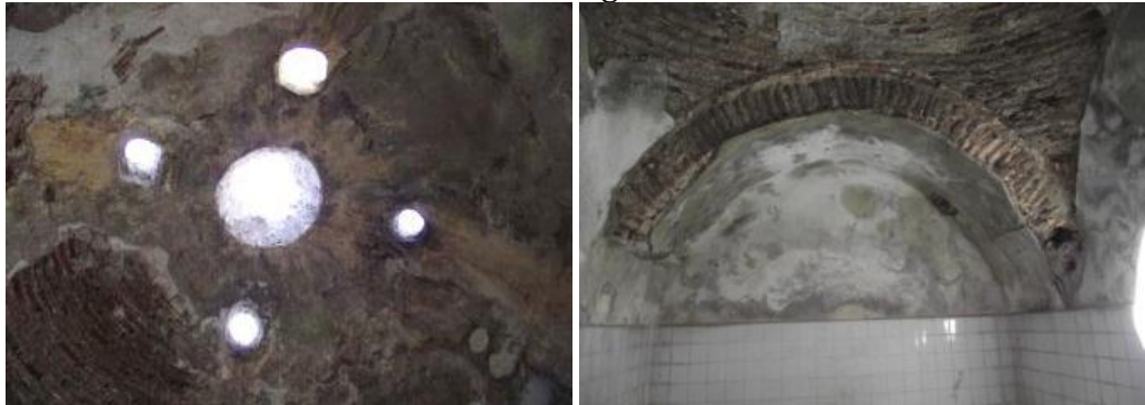
Sıcaklık bölümü kubbesi ve kubbeye geçiş elemanı
