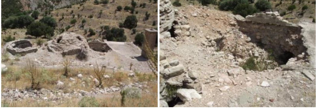
Hamamın günümüzdeki durumu
