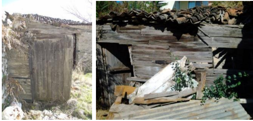
Şekil 7.26. Yeşil Ada Hamamı'nın M7 nolu deposu
