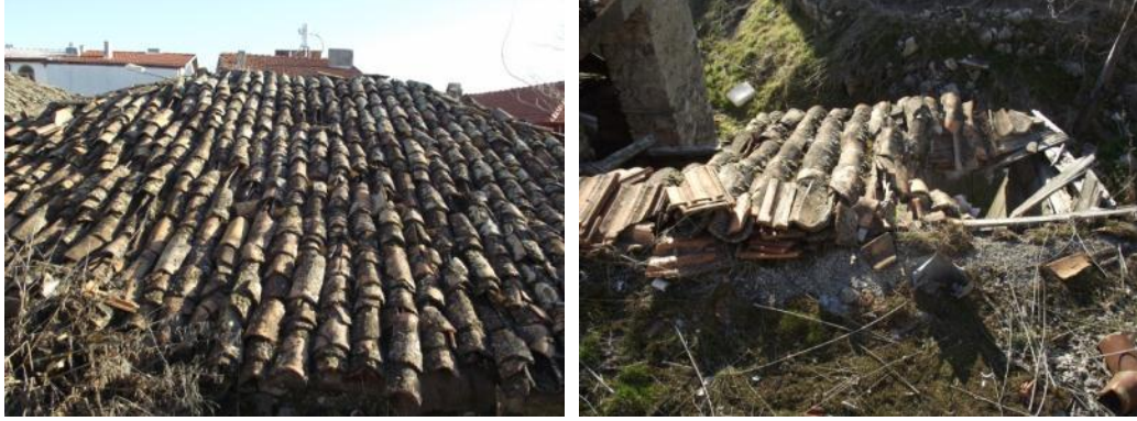
Şekil 7.39. Yeşil Ada Hamamı'nın soyunmalık ve M7 nolu depo bölümlerine ait üst örtü
