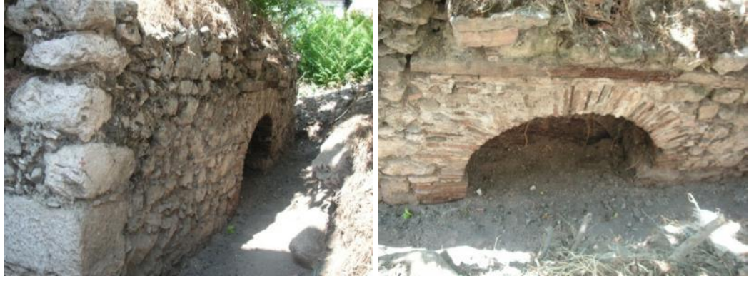
Şekil 7.36. Yeşil Ada Hamamı'nın ocak kemeri (kazi çalışmalardan sonra)
