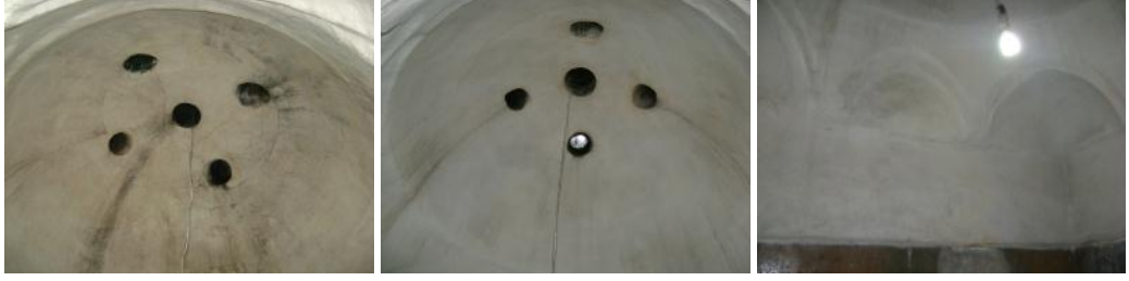
Hamamın halvet kubbeleri ve kubbeye geçiş elemanları
