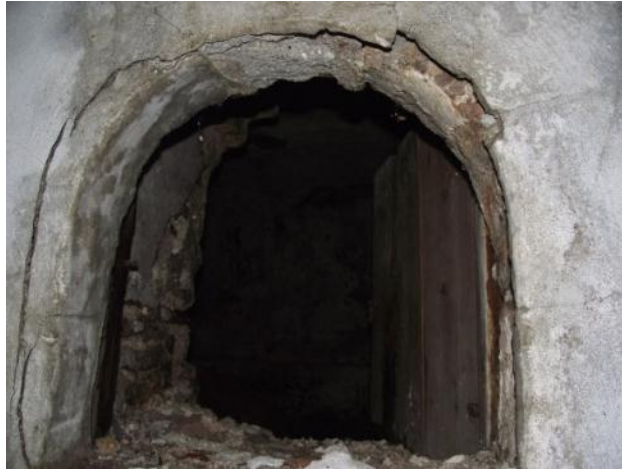
Şekil 7.22. Yeşil Ada Hamamı'nın M4 nolu halvetindeki buhar penceresi
