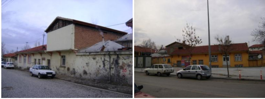
Karaağaç Hamamı' nın kuzeybatı ve güneydoğu cepheleri
