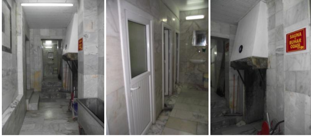
Hamamın kadınlar bölümü aralığı, tuvaletler ve ılıklığa giriş kapısı (buhar yaşmağı ile birlikte)
