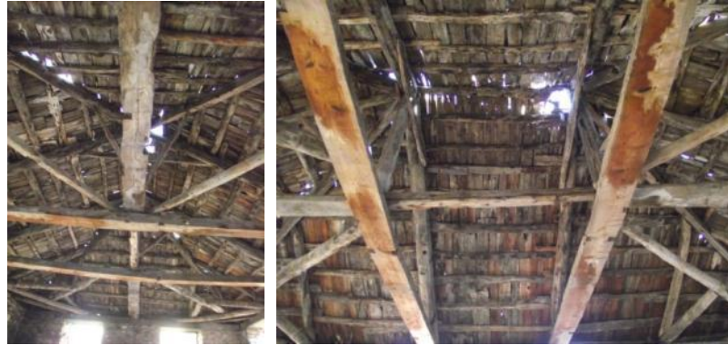
Şekil 7.40. Yeşil Ada Hamamı'nın soyunmalık bölümüne ait çatı örtüsünün iç mekandan görünümü
