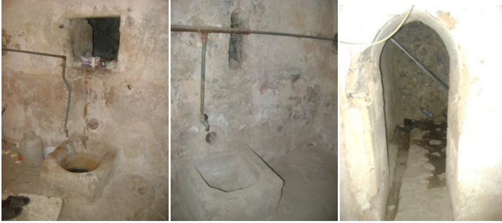
Sıcaklık ve halvetteki kurnalar, bu kurnalara ait temiz ve pis su tesisatı
