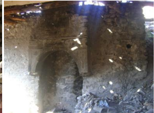
Hamamın klhan kısmının yer aldığı gney cephesi ve ocak kemeri
