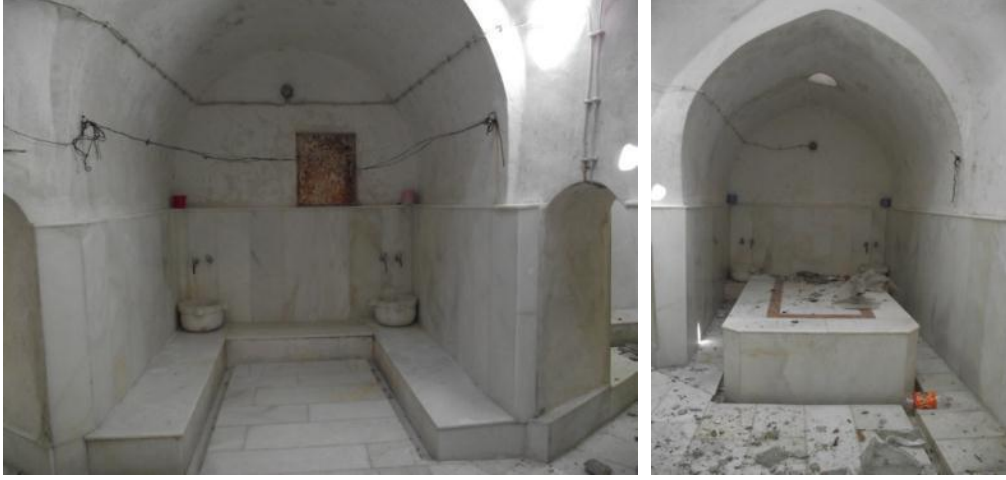
Sıcaklık bölümüne ait eyvanlar
