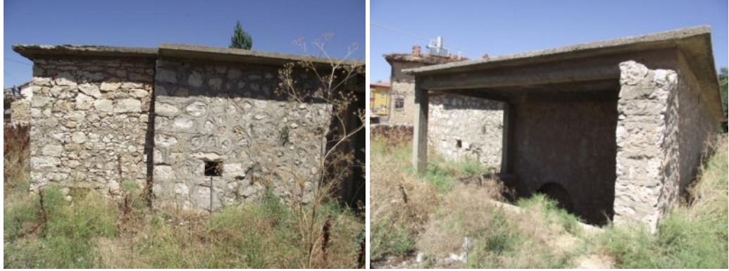
Hamamın güney cephesi ve bu cephede bulunan ocak kemeri
