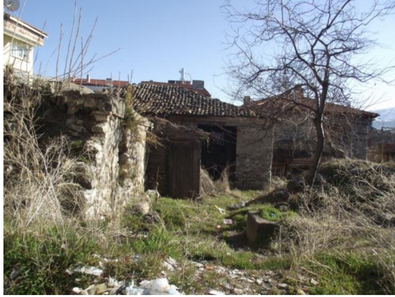
Şekil 7.33. Yeşil Ada Hamamı'nın soyunmalık ve depo kısımlarına ait kuzey cephesi
