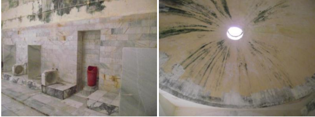
Hamamın sıcaklık bölümündeki özgün bölüme geçiş kapısı (duvar örülü) ve sıcaklık bölümü kubbesi
