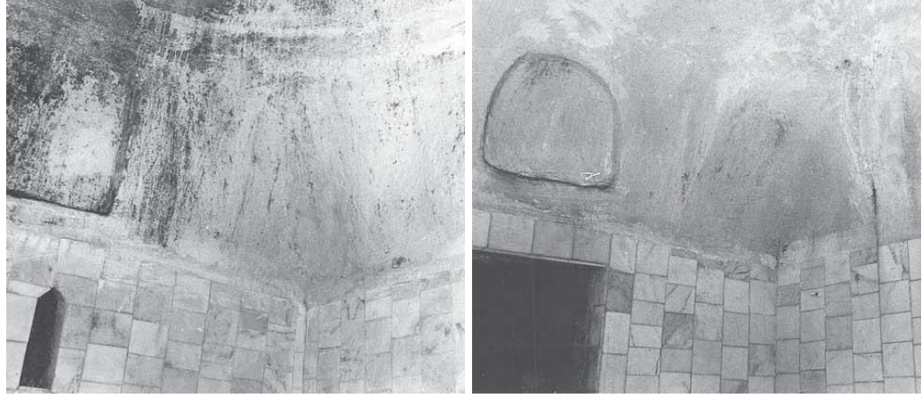
Hamamın özgün sıcaklık ve halvet mekanlarındaki kubbeye geçiş elemanları (Doğan, 2008, s.139)
