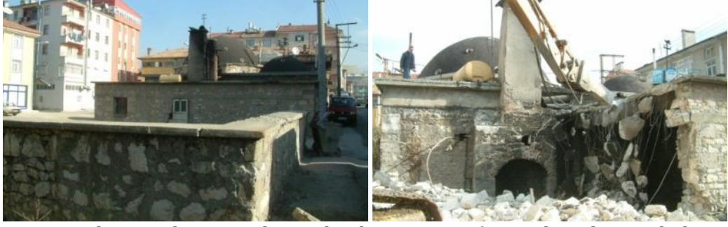
Hamamın batı cephesi ve yıkımından bir görüntü (Kaynak: Yalvaç Belediyesi arşivi)
