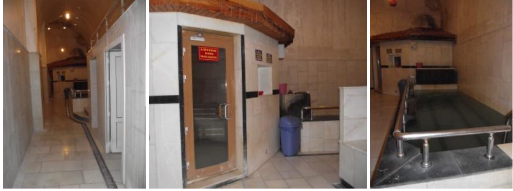
Hamamın batısındaki muhdes bölümler (duşlar, sauna ve havuz)
