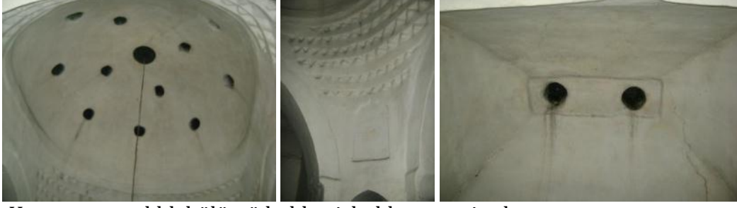
Hamamın sıcaklık bölümü kubbesi, kubbeye geçiş elemanı ve eyvan tonozu
