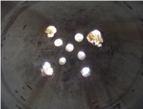
Kubbelerde yer alan aydınlatma gözleri
