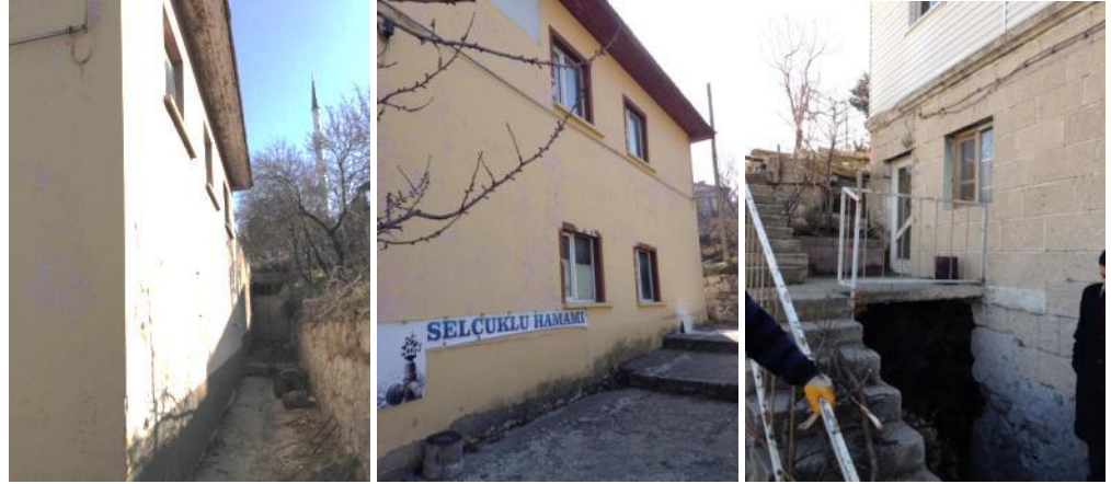
Hamamın güney ve batı cepheleri ile külhan bölümü
