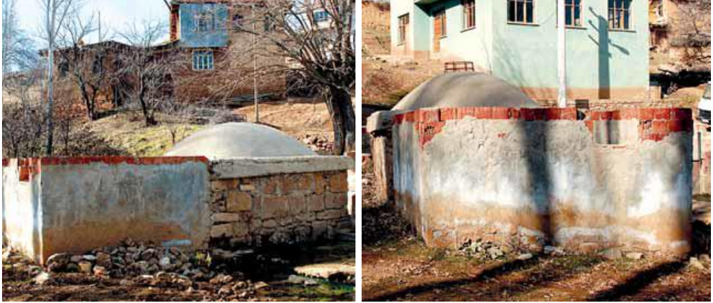
Kuzey ve doğu cephesi (Doğan, 2008, s.176).
