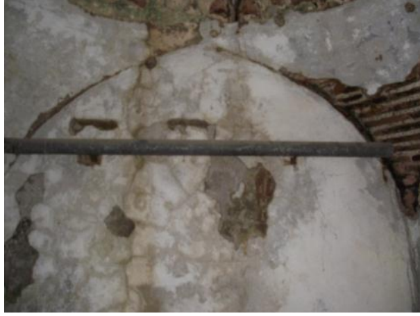
Şekil 7.20. Yeşil Ada Hamamı'nın M3 nolu halvet mekanının kuzey duvarında yer alan su borusu
