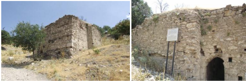
Hamamın kuzey ve batı cepheleri ve üst örtüsü
