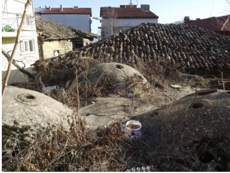
Şekil 7.41. Yeşil Ada Hamamı'nın sıcaklık ve halvet bölümlerine ait kubbelerin üstten görünümü
