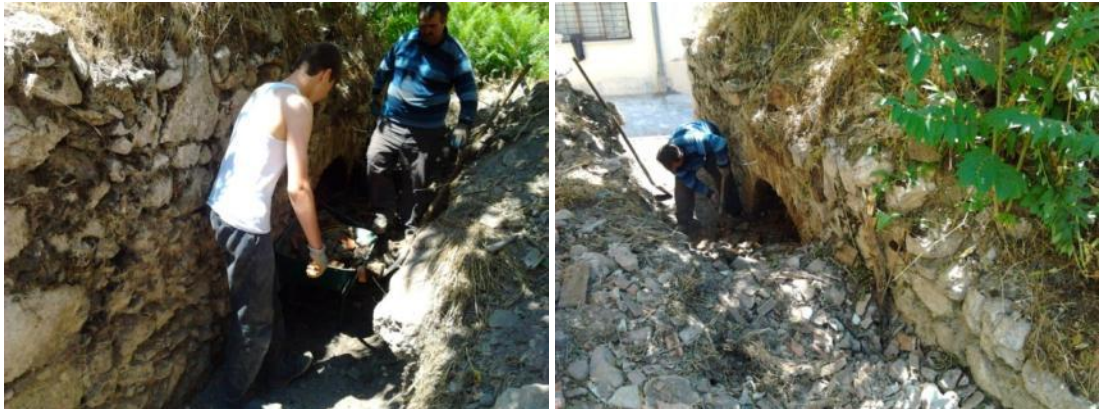
Şekil 7.35. Yeşil Ada Hamamı'nın ocak kısmındaki molozların kaldırılması
