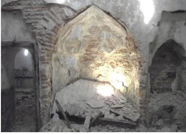
Ilıklık içerisindeki nişler (biri havlu kurutma ocağı)
