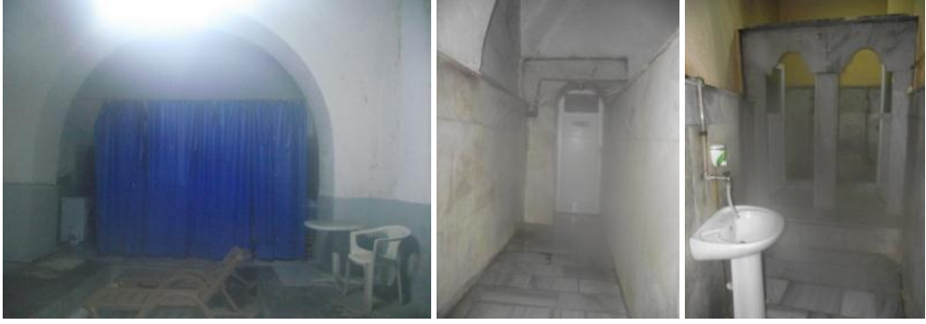
Hamamın ılıklik bölümü ve tuvaletler (erkekler bölümü)
