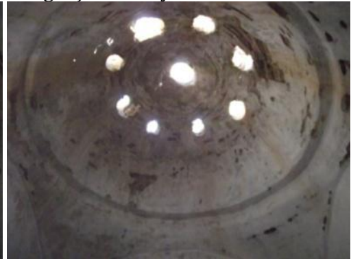
Kubbelerde yer alan aydınlatma gözleri
