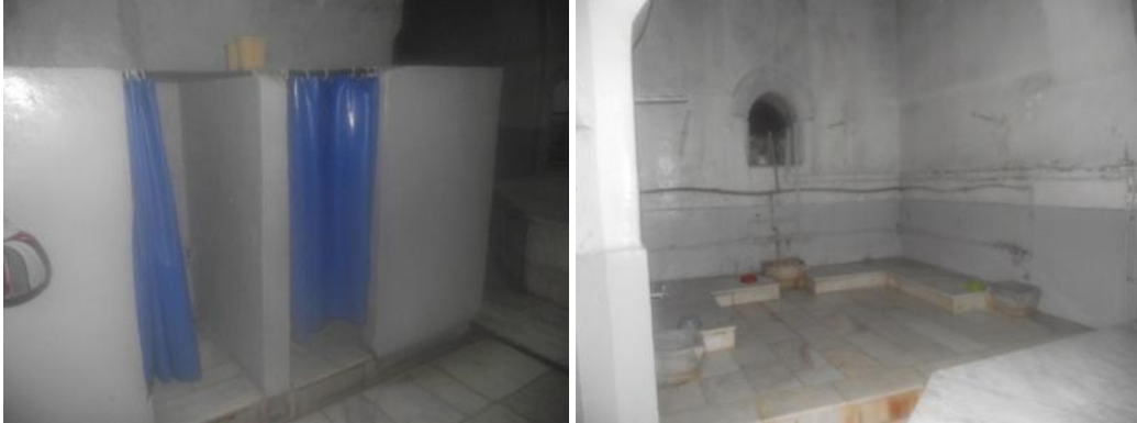
Hamamın sıcaklığındaki muhdes tıraşlıklar ve eyvan (erkekler bölümü)
