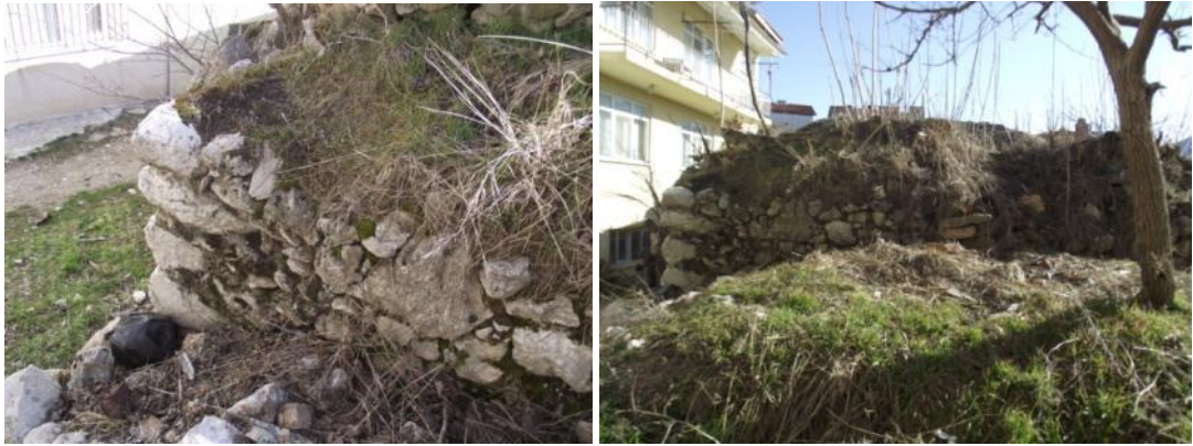
Şekil 7.34. Yeşil Ada Hamamı'nın küllhan kısmına ait kuzey cephesi (moloz yığını kaldırılmadan önce)
