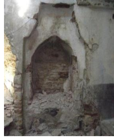
Ilıklık içerisindeki nişler (biri havlu kurutma ocağı)
