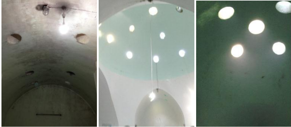
Hamamın üst örtü sistemi (ılıklik, sıcaklık ve halvet)
