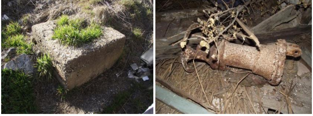
Şekil 7.53. Yeşil Ada Hamamı'nın bahçesinde yer alan su kuyusu ve su kuyusuna ait pompa
