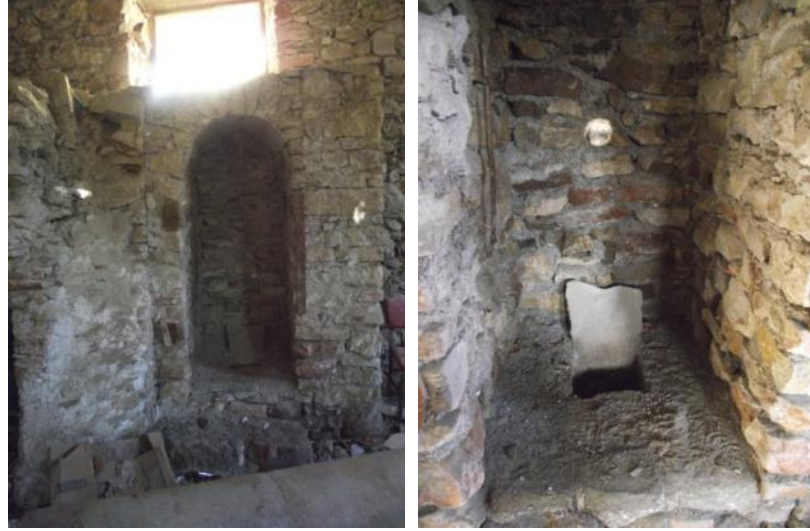
Şekil 7.14. Yeşil Ada Hamamı'nın tırashlık kısmı
