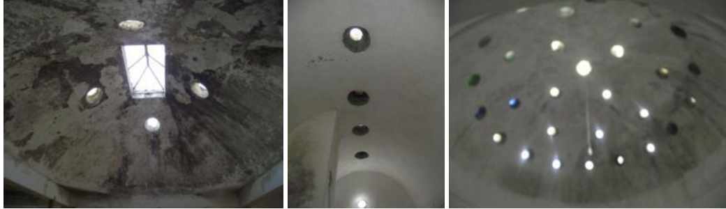
Hamamın örtü sistemi (soyunmalık, ılıklik ve sıcaklık)
