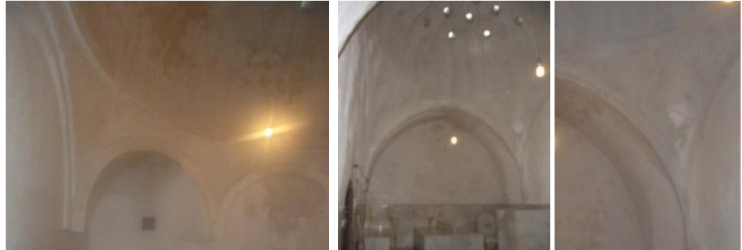
Hamamın erkekler bölümüne ait kubbeye geçiş öğeleri
