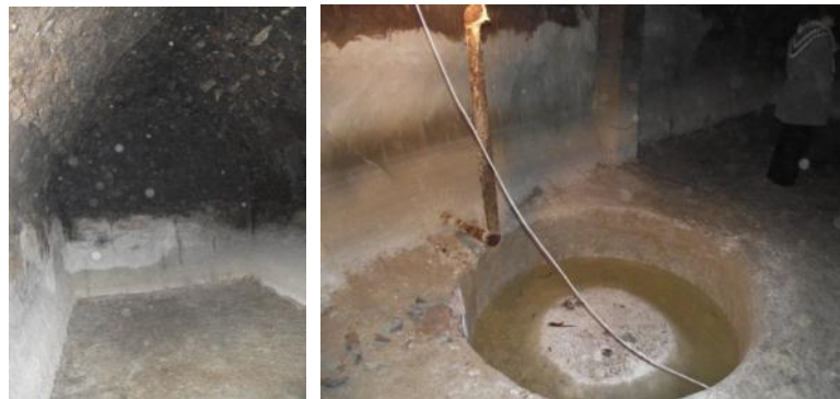
Şekil 5.17. Dünder Bey Hamamı'nın su deposu ve bakır kazanı
