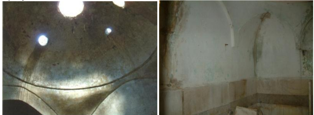
Hamamın kubbesi ve kubbeye geçiş elemanları (Kaynak: Kurucu, 2005, s. 85; Yalvaç Belediyesi arşivi)
