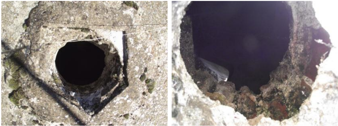
Şekil 7.43. Yeşil Ada Hamamı'nın fil gözleri kırılmış aydınlatma tepecikleri ve müdahaleye uğramış üst örtüye ait et kalınlığı
