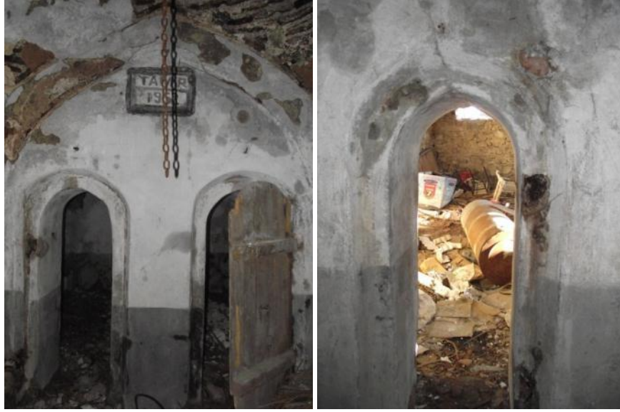
Şekil 7.15. Yeşil Ada Hamamı'nın sıcaklık bölümünden halvetlere ve soyunmalığa açılan kapılar
