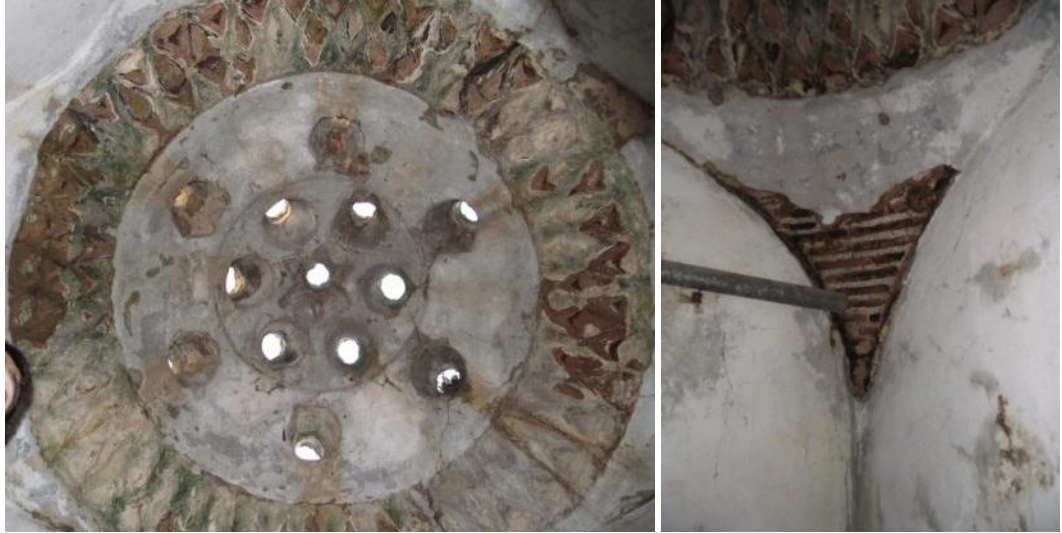
Şekil 7.46. Yeşil Ada Hamamı'nın M3 nolu halvete ait kubbe ve kubbeyi taşıyan pandantif
