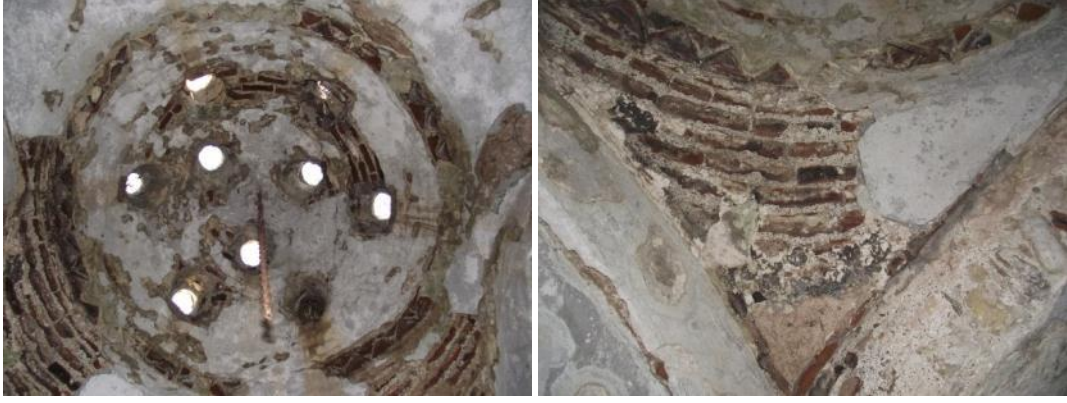
Şekil 7.47. Yeşil Ada Hamamı'nın sıcaklık bölümüne ait kubbe ve kubbeyi taşıyan pendentif
