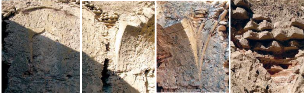
Hamamın sıcaklık bölümündeki kubbeye geçiş sisteminden görünüm (Doğan, 2008, s.117).
