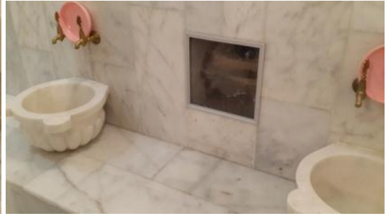
Hamamın restorasyon sonrası sıcaklık bölümü ve kurnalar (kare bölümde özgün tesisat sergilenmekte)
