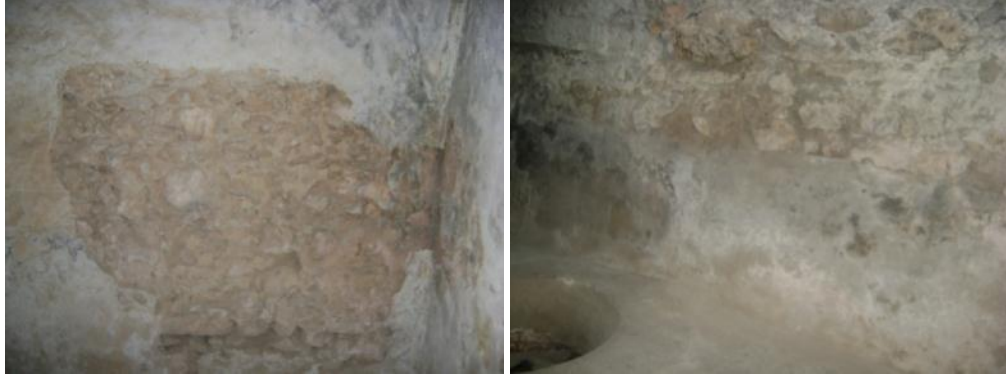
Hamamın duvarlarını oluşturan taşlar ve su deposu
