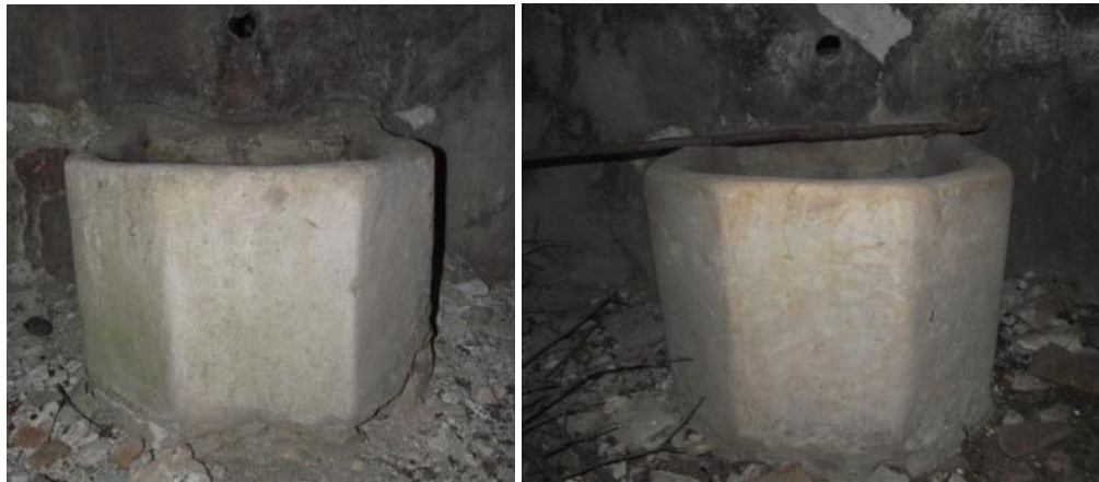
Şekil 7.50. Yeşil Ada Hamamı'nın M3 ve M4 halvetlerindeki özgün kurnaların karşıdan görünümü
