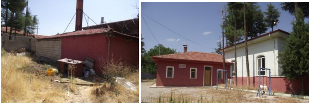
Hamamın kuzey ve doğu cephesi (sağda mescit)
