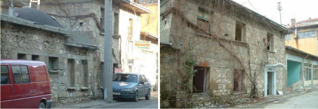
Hamamın güney cephesi (Kaynak: Yalvaç Belediyesi arşivi)
