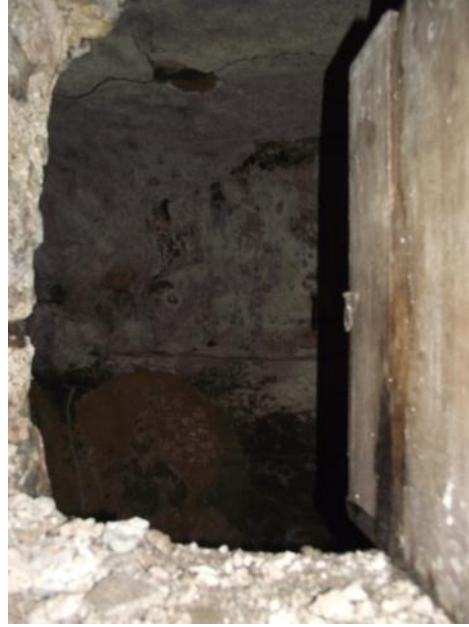
Şekil 7.25. Yeşil Ada Hamamı'nın M4 nolu halvetindeki buhar penceresinden M6 nolu sıcak su deposunun görünümü
