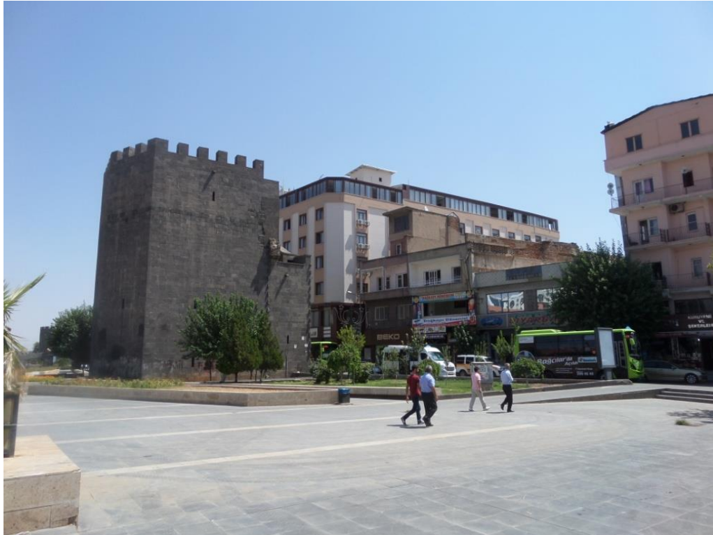
Şekil 4.26. Sur içinin tarihi dokusunu bozan yapılaşma örneği (Şahin DURAK arşivi 2014)
