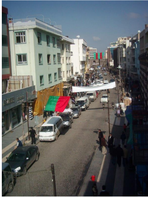
Şekil 4.73. Hasan Paşa Hanından Gazi Caddesine ve Dağ Kapiya doğru bir görünüm (Şahin DURAK arşivi)
