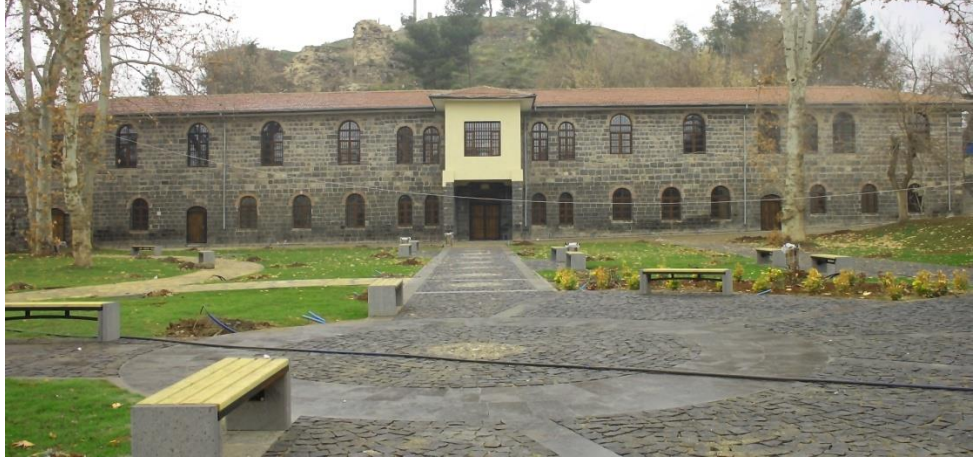
Şekil 4.11. Jandarma Binası (Diyarbakır Valiliği 2014d)
