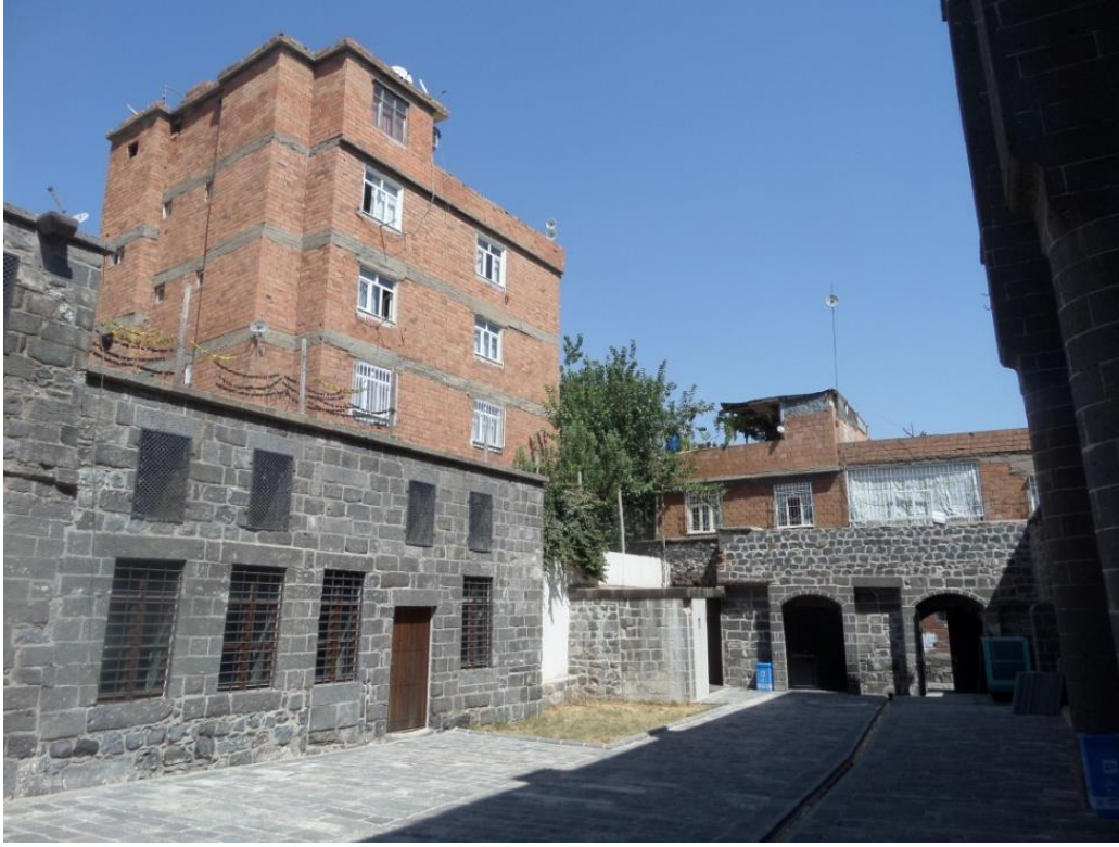
Şekil 4.25. Sur içinin tarihi dokusunu bozan yapılaşma örneği (Şahin DURAK arşivi 2014)
