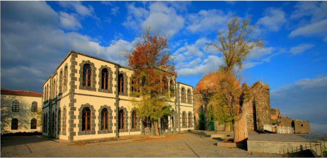
Şekil 4.10. Kolordu Komutanlık Binası (Diyarbakır Valiliği 2014c)
