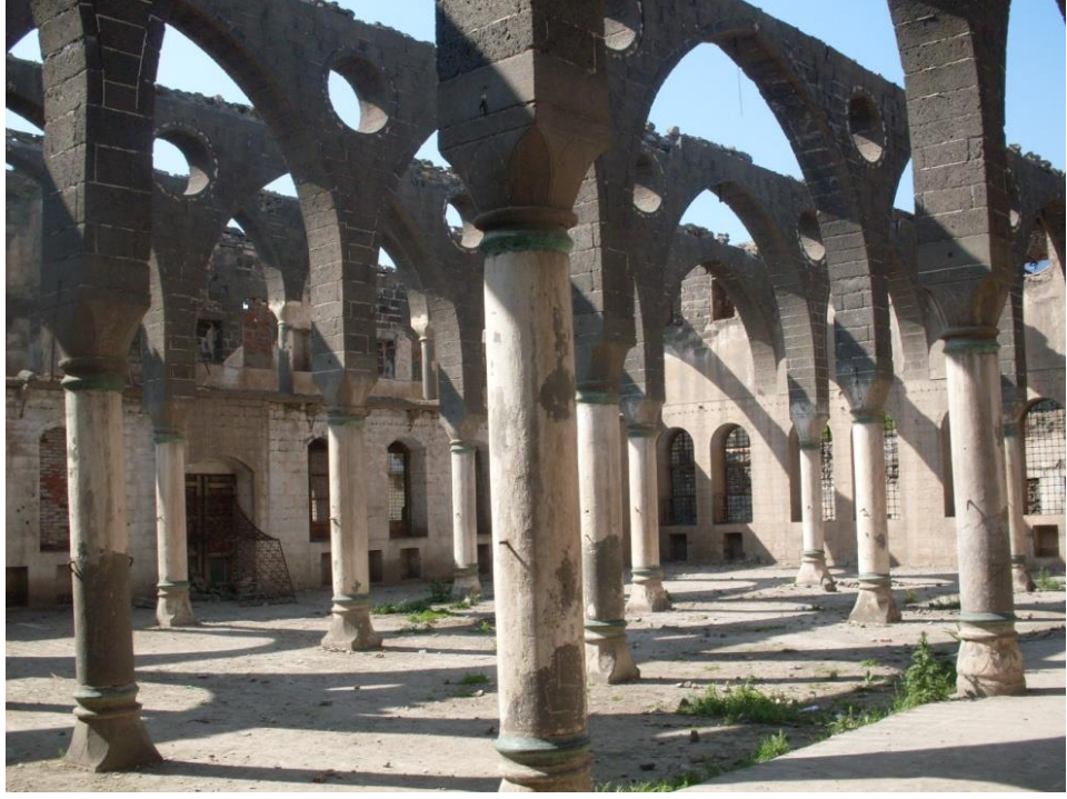
Şekil 4.66. Restore edilmeden önce Surp Giragos Ermeni Kilisesi (Şahin DURAK arşivi)
