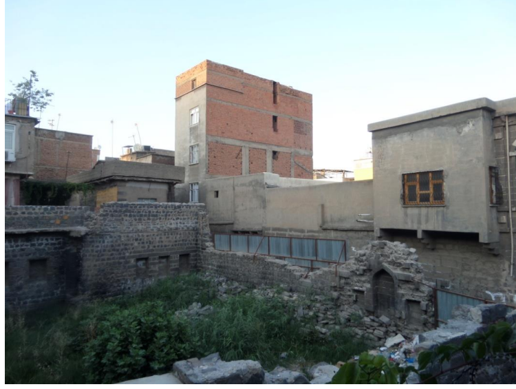
Şekil 4.27. Sur içinin tarihi dokusunu bozan yapılaşma örneği (Şahin DURAK arşivi 2014)
