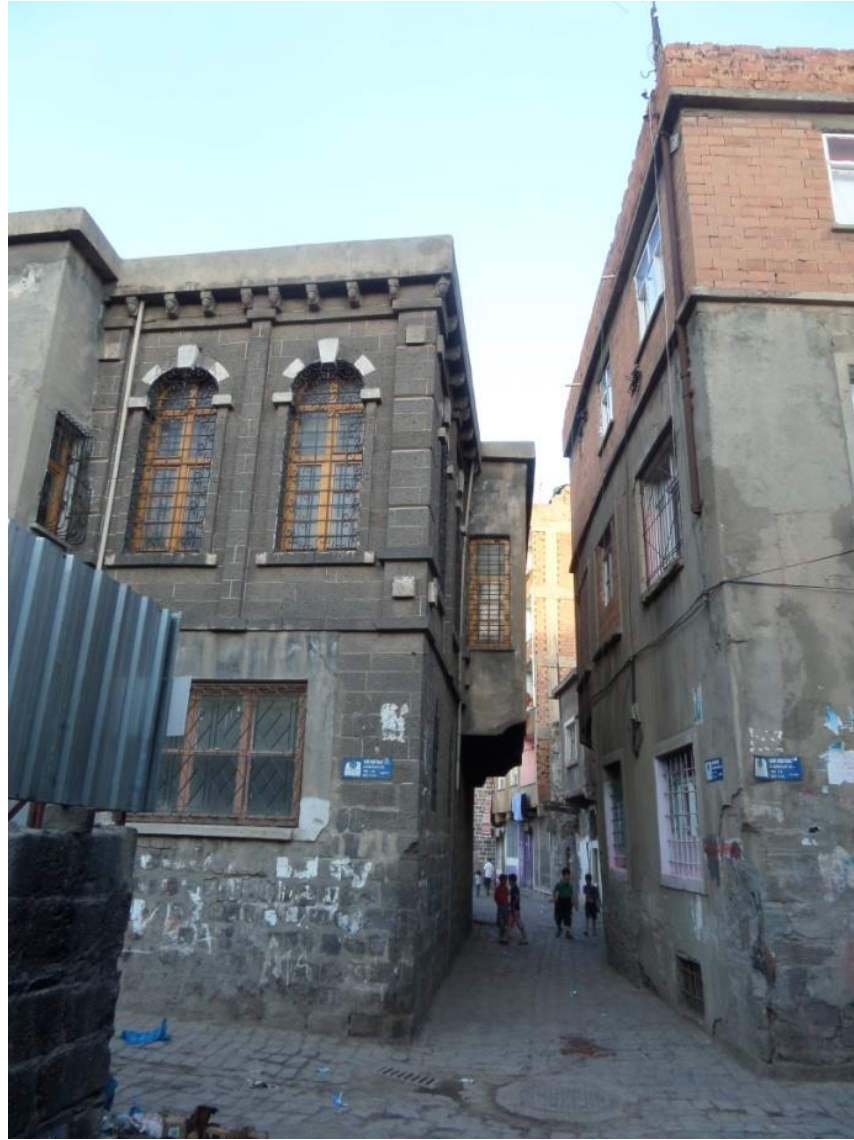
Şekil 4.24. Sur içinin tarihi dokusunu bozan yapılaşma örneği (Şahin DURAK arşivi 2014)
