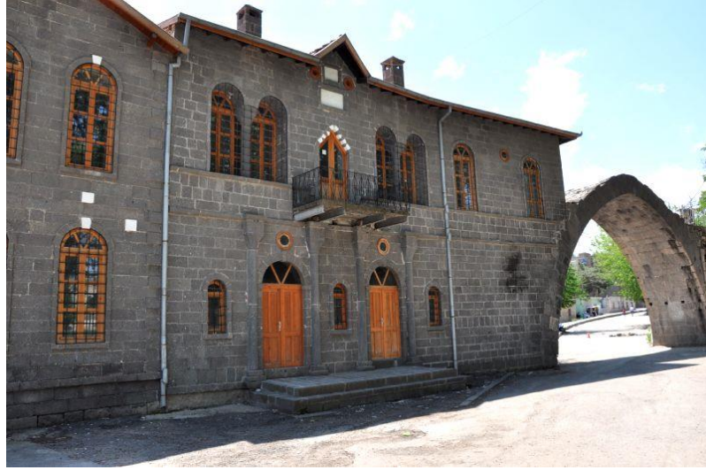
Şekil 4.12. Eski Vakıflar Müdürlüğü Binası (Diyarbakır Valiliği 2014e)
