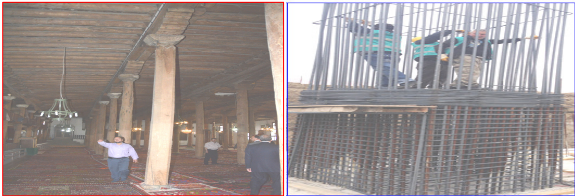
Şekil 3.6. Ahşap ve betonarme kolon kesitleri
