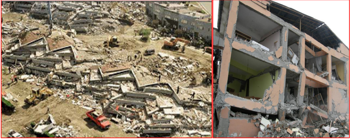
Şekil 1.1. Zayıf kolondan dolayı ani göçme hasar durumu
