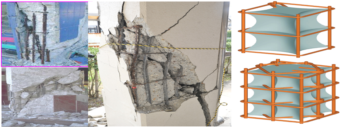
Şekil 5.20. Kolon etriye düzenlemesi
