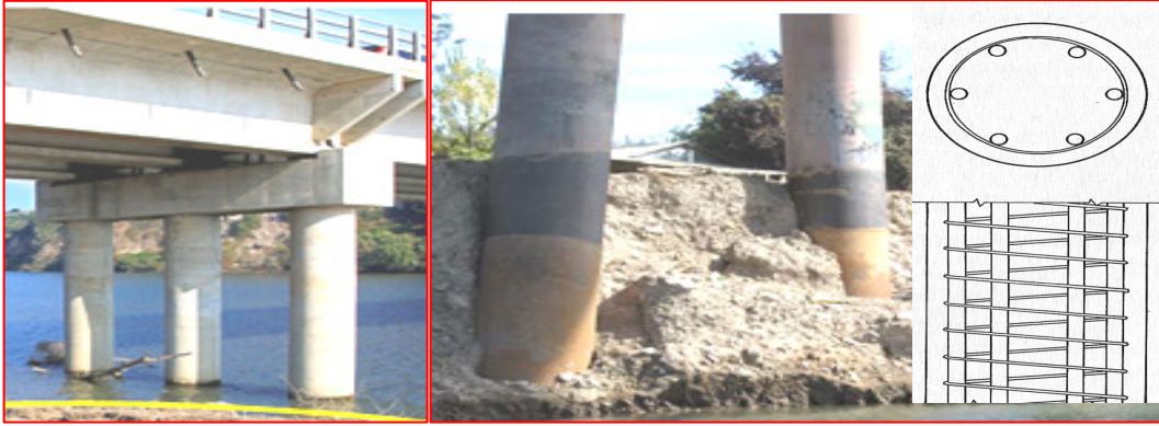
Şekil 3.13. Dairesel kolon kesit örnekleri
