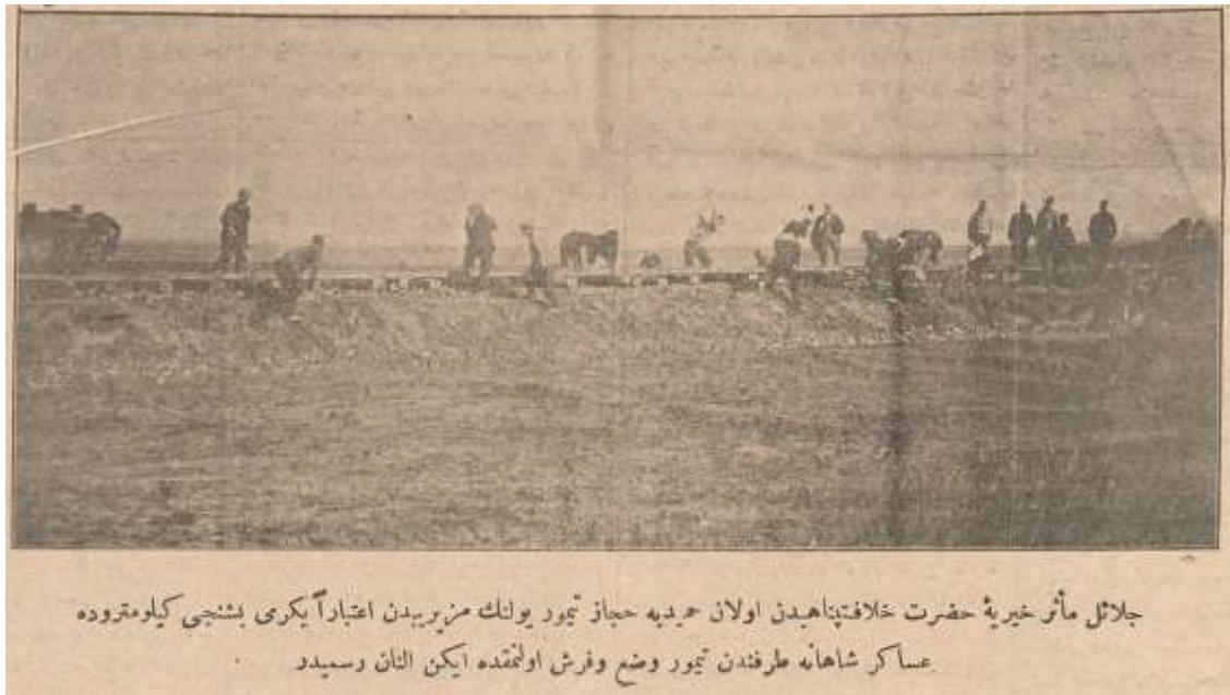
Ft. 6. Celâil-i Müessir-i Hayriye-i Hazret-i Hilafet-penâhîden Olan Hamidiyye-Hicaz Demiryolu'nun Müzeyrib'den İtibaren 25. Kilometrede Asâkir-i Şahane Tarafından Demir Vaz' ve Ferş Olunmaktayken Alınan Resimdir 14
