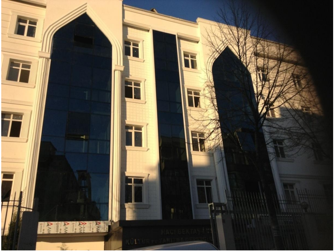
Şekil 2.10: Çubuk giydirme düz cephesi bitmiş görünüm, Bağıcılar Cem Evi.
