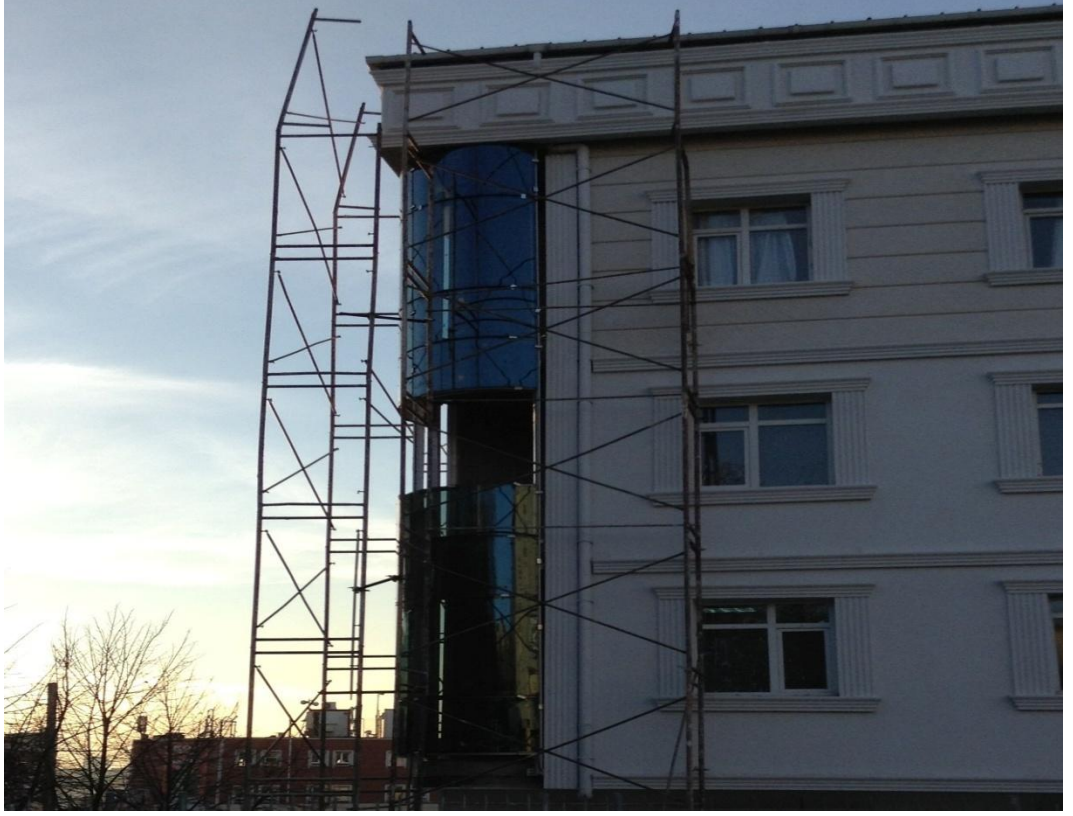
Şekil 2.9: Çubuk giydirme bombeli cephe dış görünüş, Bağıcılar Cem Evi.
