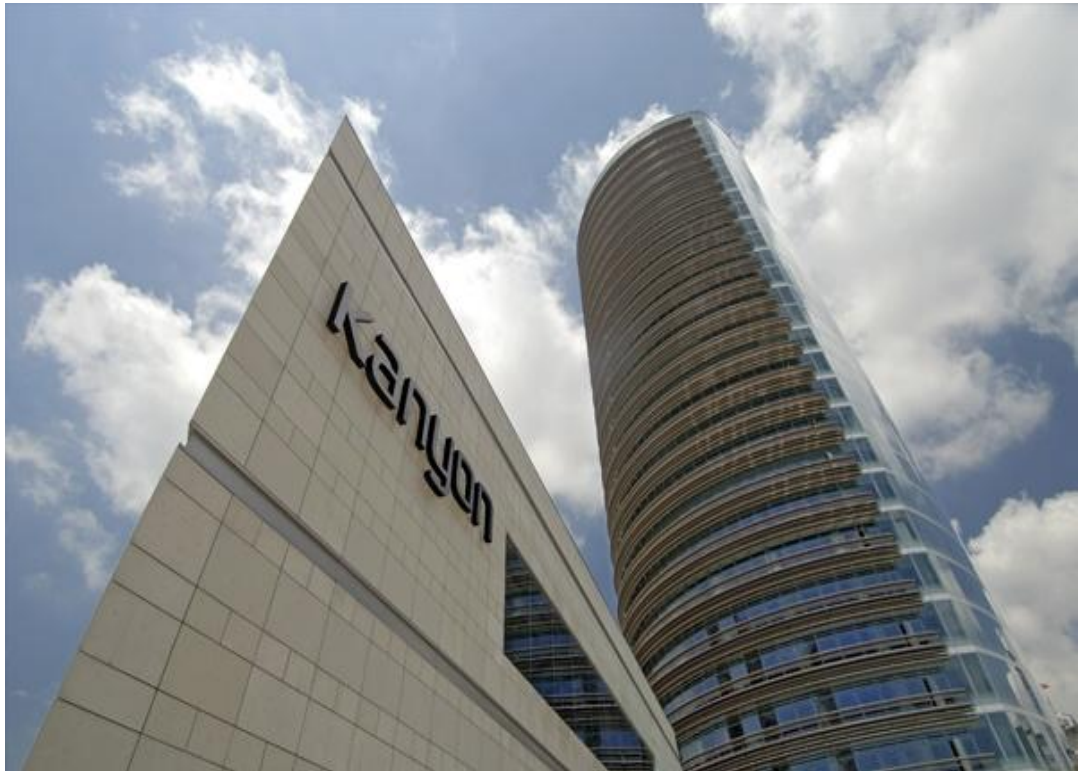
Şekil 2.13: Panel giydirme cephe sistemi bitmiş örneği – 1.
