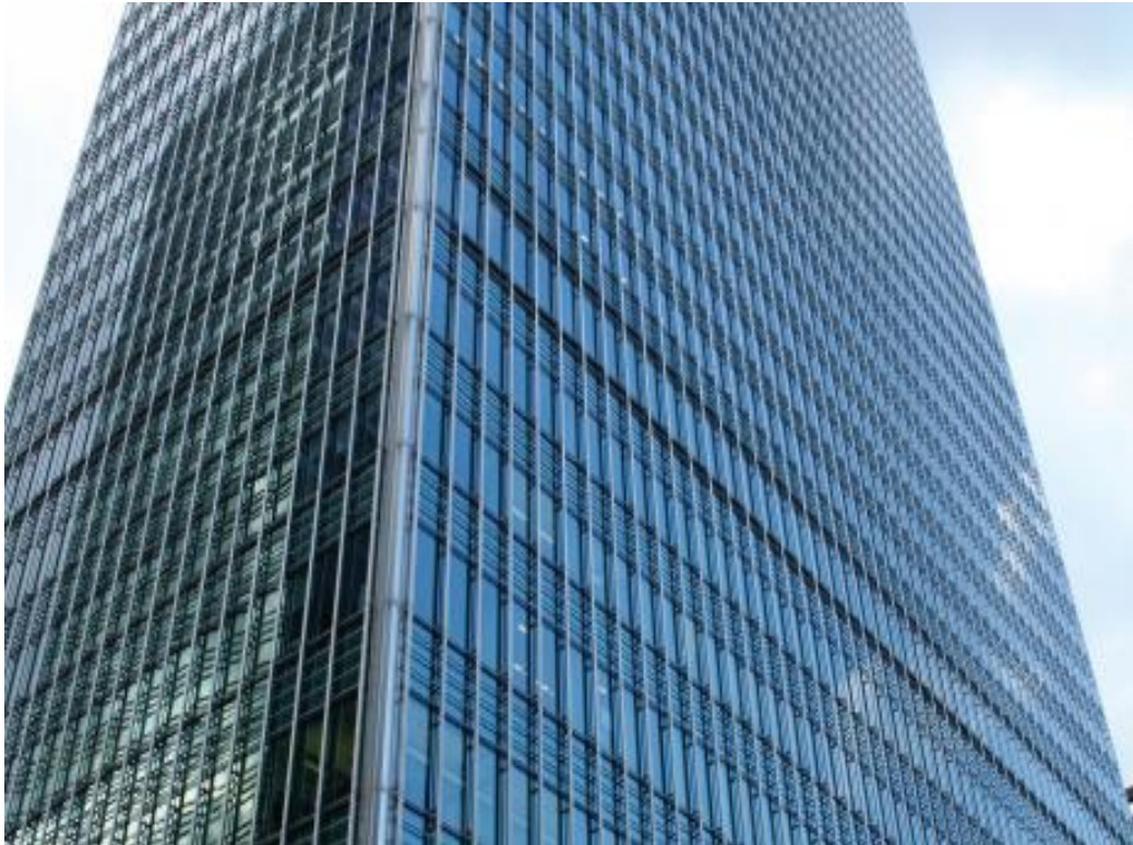
Şekil 2.15: Panel giydirme cephe sistemi bitmiş örneği – 3.
