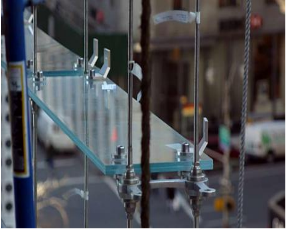
Şekil 2.17: Cam kirişli transparan cephe sistemi.
