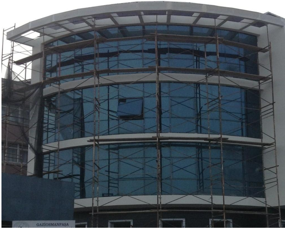
Şekil 2.6: Çubuk giydirmce cephesi bitmiş görünüm, Gazi Osman Paşa Semt Konağı.
