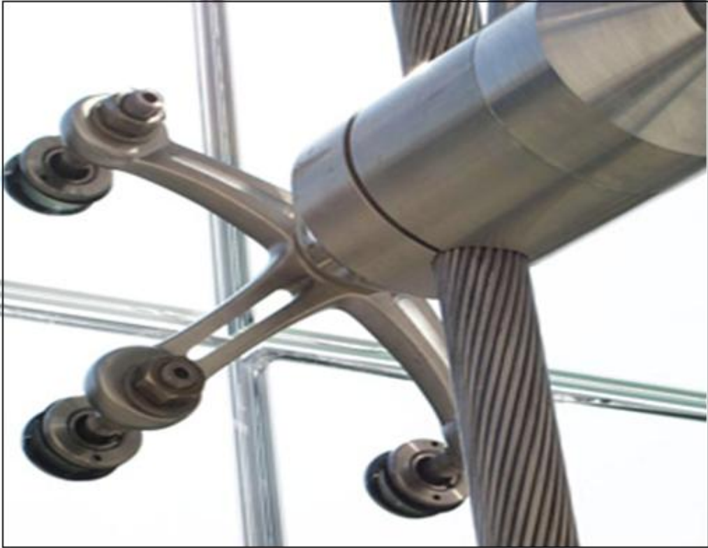
Şekil 2.16: Çelik gergi taşıyıcılı transparan cephe sistemi detayı.
