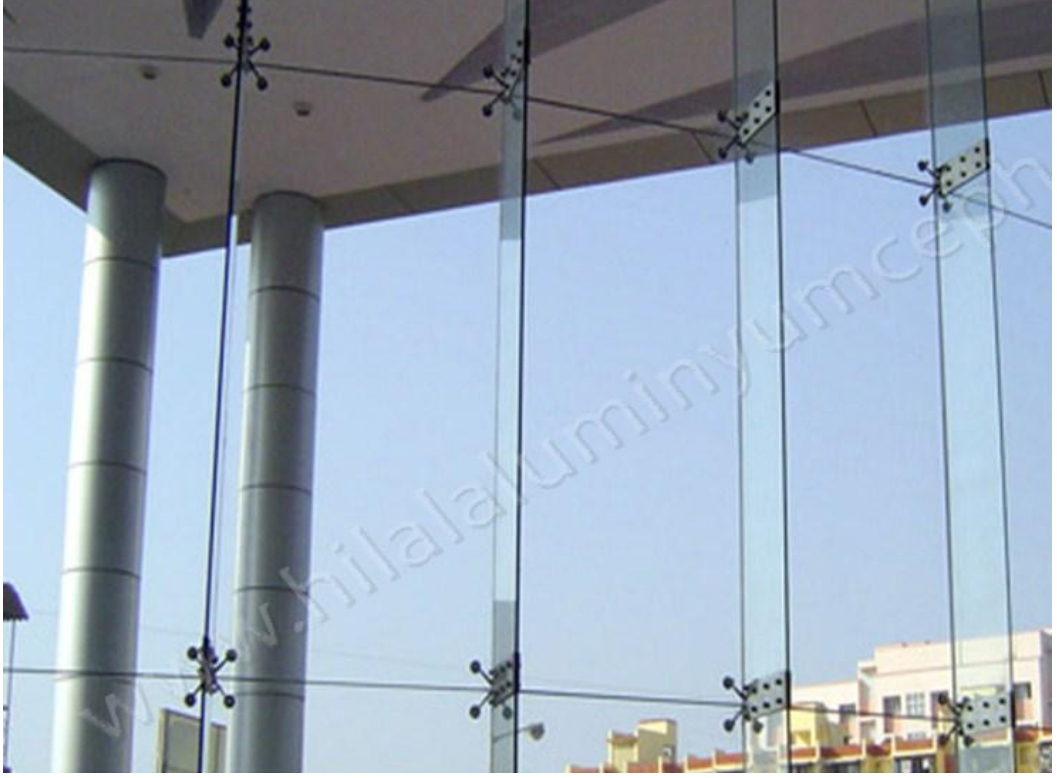
Şekil 2.19: Cam kolonlu transparan cephe sistemi.
