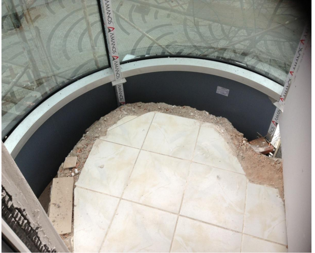
Şekil 2.8: Çubuk giydirme bombeli cephe iç görünüş, Bağcılar Cem Evi.
