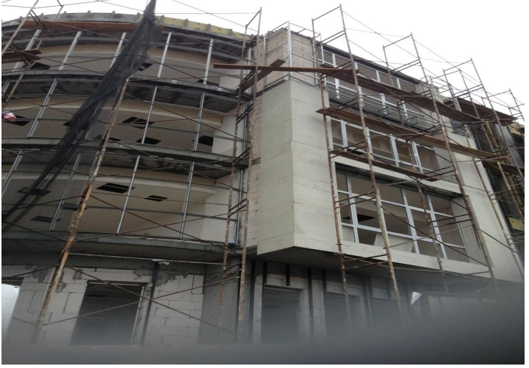
Şekil 2.3: Çubuk giydirmce cephe sistemi, Gazi Osman Paşa Semt Konağı.
