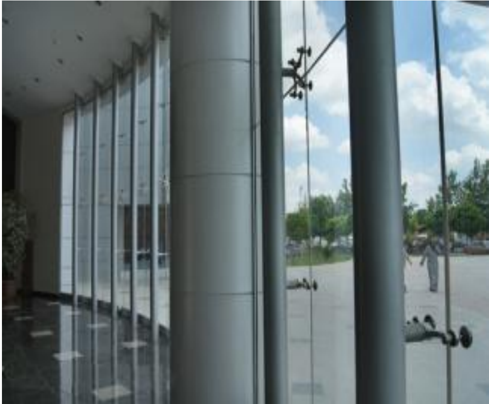
Şekil 2.18: Çelik taşıyıcılı transparan cephe sistemi.
