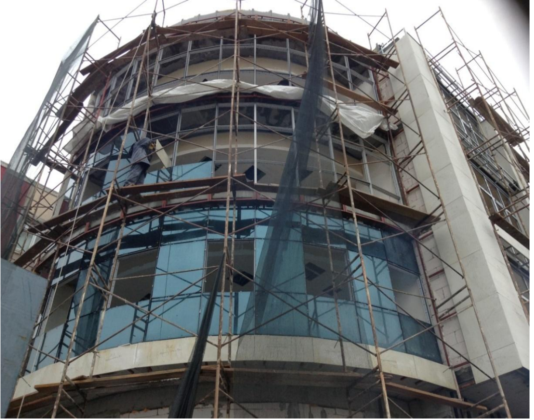
Şekil 2.4: Çubuk giydirmce cephesi cam montajı aşaması, Gazi Osman Paşa Semt Konağı.
