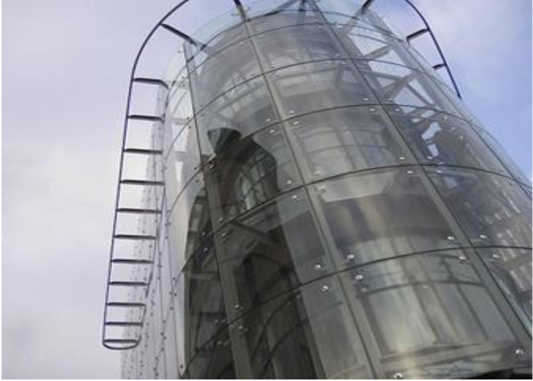
Şekil 2.21: Transparan cephe bitmiş örneği – 1.
