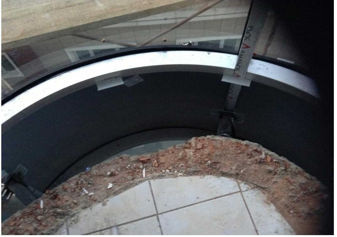
Şekil 2.7: Çubuk giydirme bombeli cephe ankraj detayı, Bağcılar Cem Evi.
