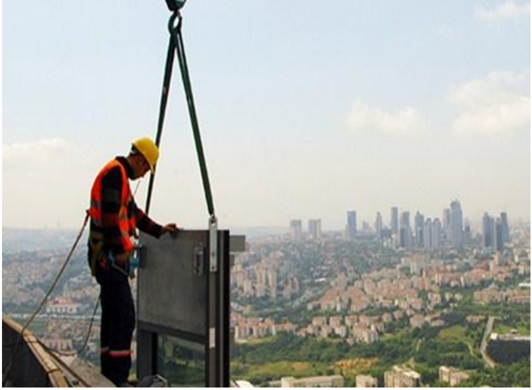
Şekil 2.12: Panel giydirme cephe sistemi vinç ile montaj aşaması.
