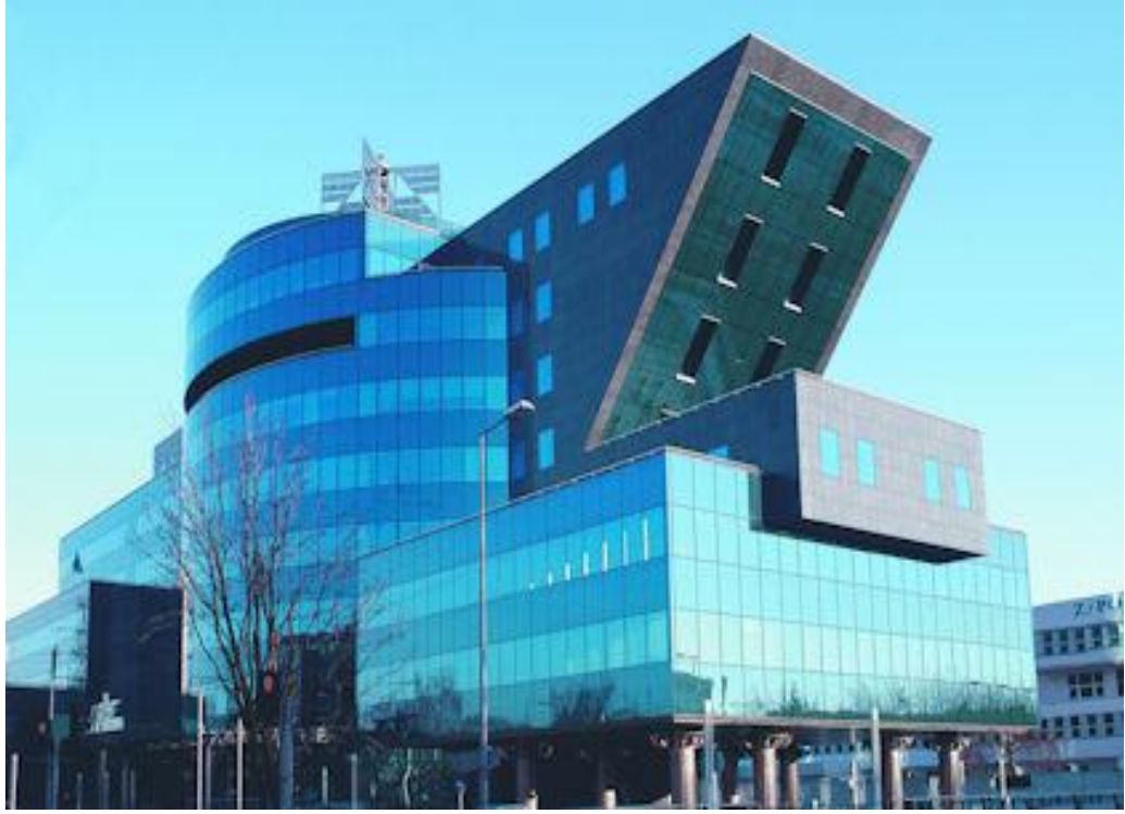
Şekil 2.14: Panel giydirme cephe sistemi bitmiş örneği – 2.
