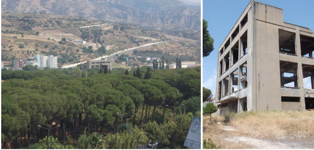
Şekil 5.9. Aydın tekstil yerleşkesinin denizli-aydın karayolundan görünümü ve yekil doku içerisindeki kazan dairesi ve Kazan dairesinin 2014 Ağustos Ayındaki durumunu gösteren fotoğraf (Yazarın kişisel arşivi)
