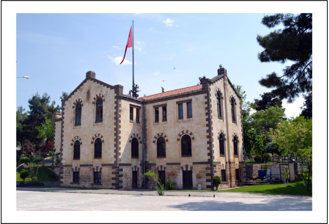
Fotoğraf 2.57. Amerikan Koleji'nden Geriye Kalan ve Okul Binası Olduğu Tahmin Edilen Üç Katlı Yapının Batı Cephesinden Görünümü (14.04.2013).
