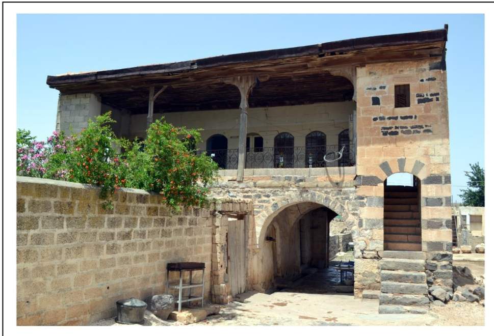
Fotoğraf 2.17. Bazalt ve Kesme Kireçtaşı Kullanılarak İnşa Edilmiş Geleneksel Bir İkizkuyu Evi (25.05.2013).
