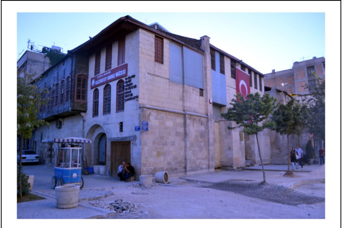
Fotoğraf 2.59. Gaziantep Savaş Müzesi Dış Cephesinden Bir Görünüm (07.09.2013).
