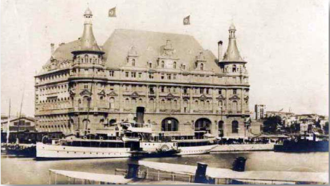
Fotoğraf 14: Edebi eserlerde ve anılarda İstanbul'a gelmiş olmanın ve İstanbul'dan ayrılmanın mekânı olarak anlatılan Haydarpaşa Garı
