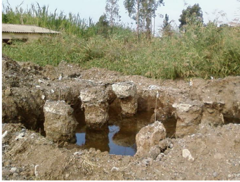
Şekil 2. 17. Fethiye’de kumlu silt bir formasyonda yapılmış jet grout deneme kolonları (Doğanışık, 2010)
