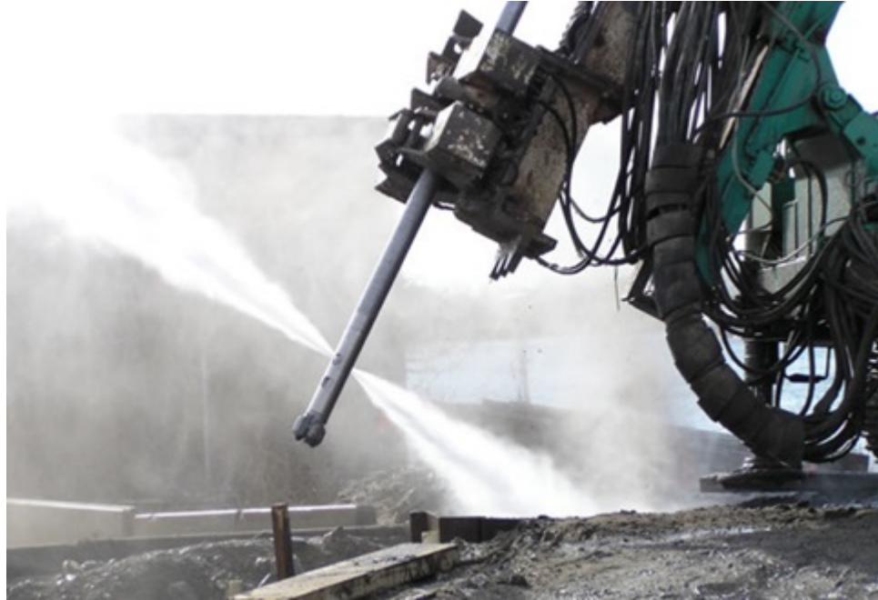
Şekil 2. 3. Monitör ve nozuldan basınçlı su çıkışı (Sarı, 2008)
