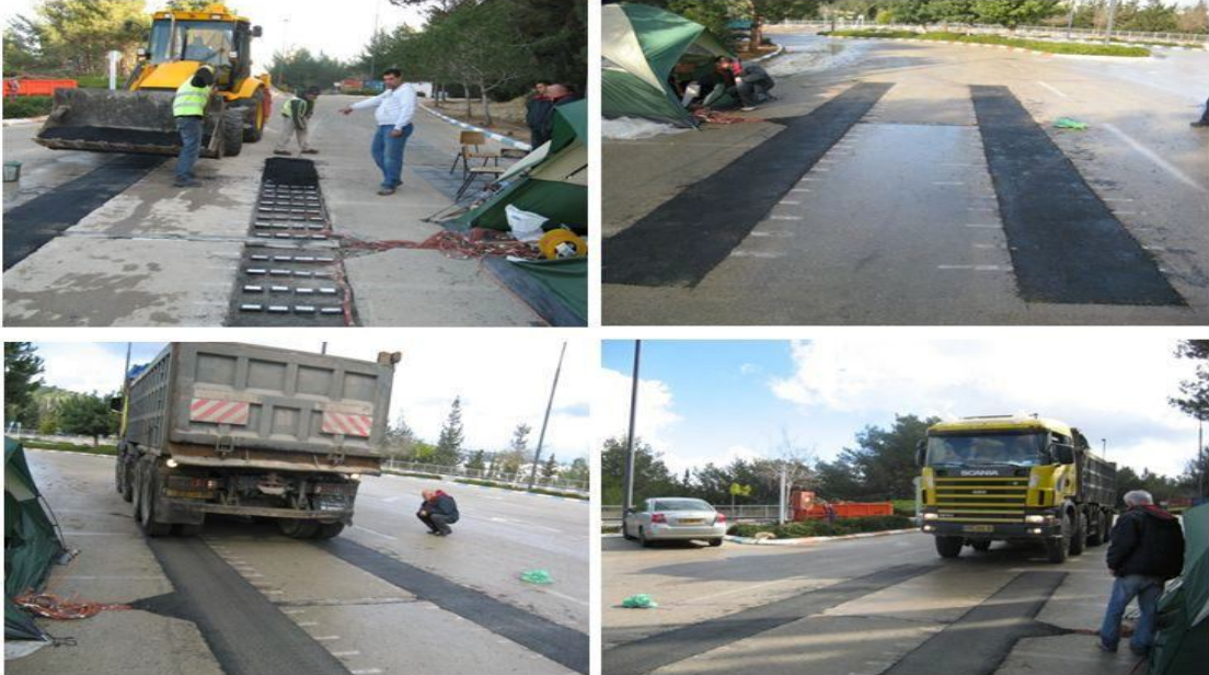
Şekil 1. 25. Piezo malzemenin yola döşenmesi [12]
