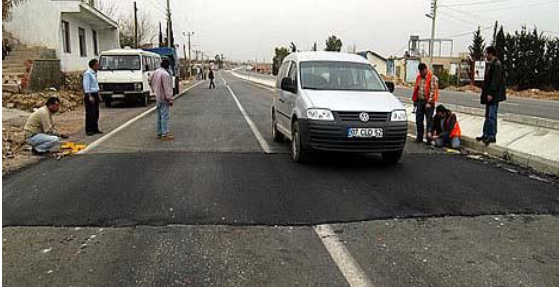
Şekil 1. 34. Uzun hız kesici [62]
