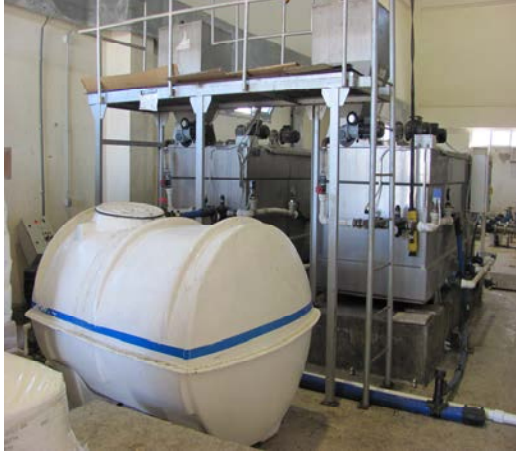
Resim 3.14. Polielektrolit ünitesi.
