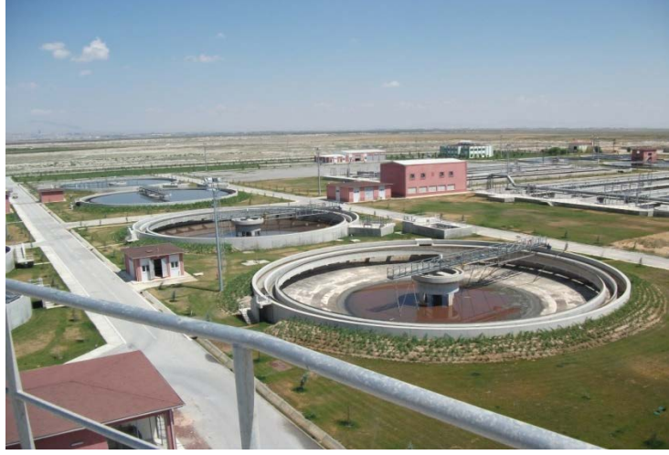
Resim 3.5.Ön çökeltme havuzları.
