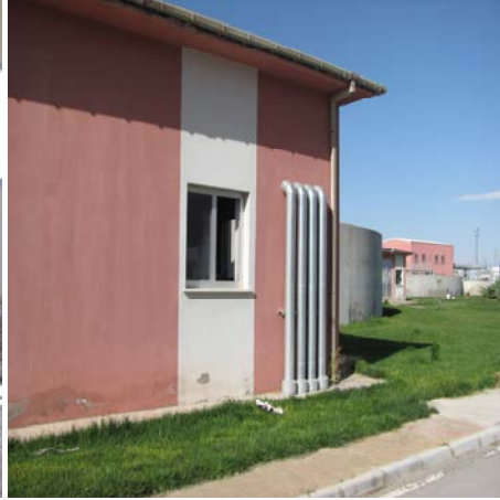
Resim.3.11. Yoğun çamur pompa çıkışları
