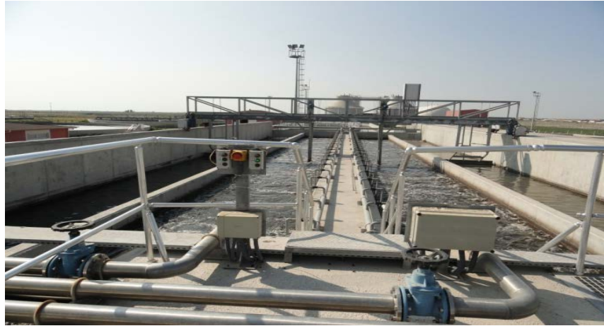
Resim 3.4. Kum-Yağ tutucular
