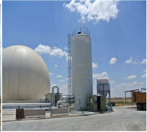
Resim 3.17. Desülfürizasyon ünitesi.
