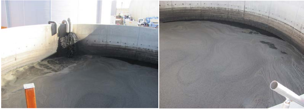
Resim 3.13. Çamur karışım tankı.
