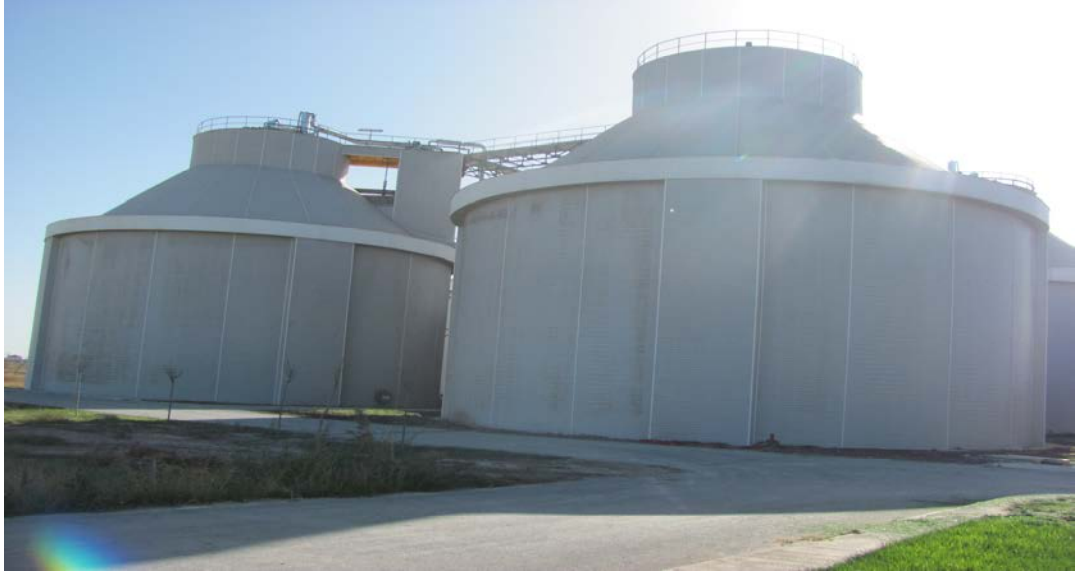
Resim 3.12. Anaerobik çamur çürütücüler.
