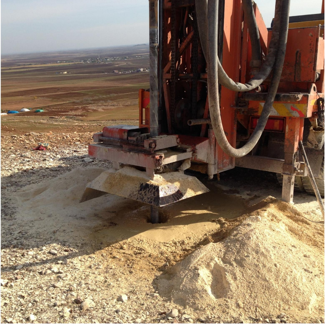
Şekil 4.5: Çalışma için kuyunun açılması.
