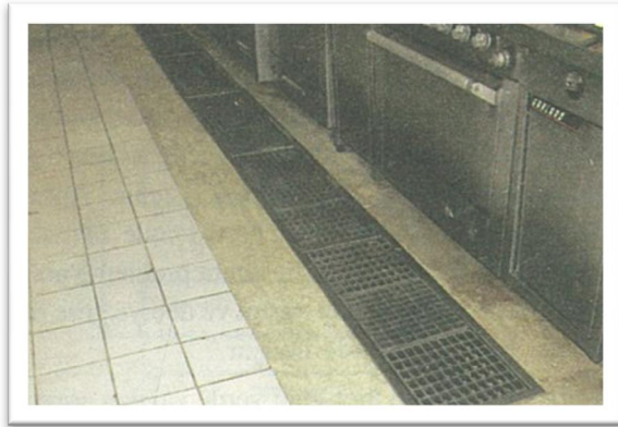
Resim 3.6. Pis Su Boruları
