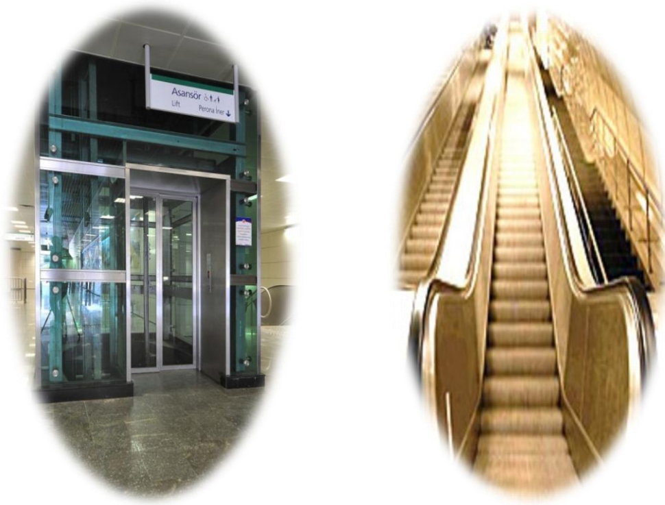
Şekil 3.8 : Metro istasyonu asansör ve yürüyen merdivenleri
