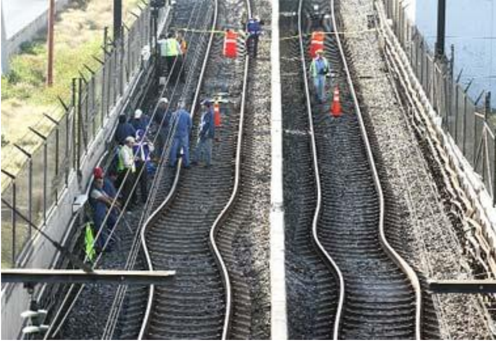
Şekil 1.5: New Mexico depreminden doğan yatay deformasyon.
