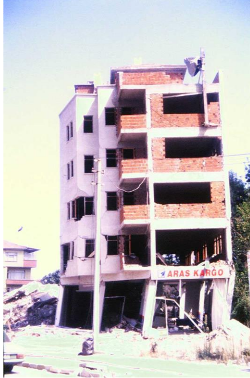
Şekil 2.4 : Zayıf kat düzensizliği sebebiyle hasar görmüş bir bina[14]
