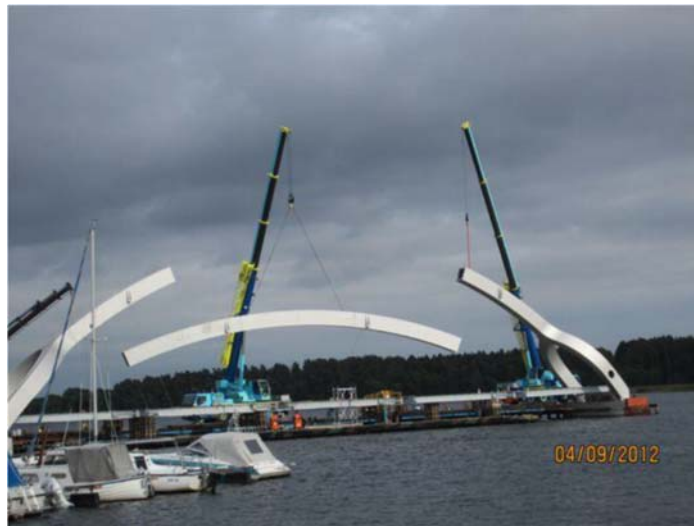
Figure 1.7 : The bridge ‘Stål- och Rörmontage AB, Sölvesborg’
