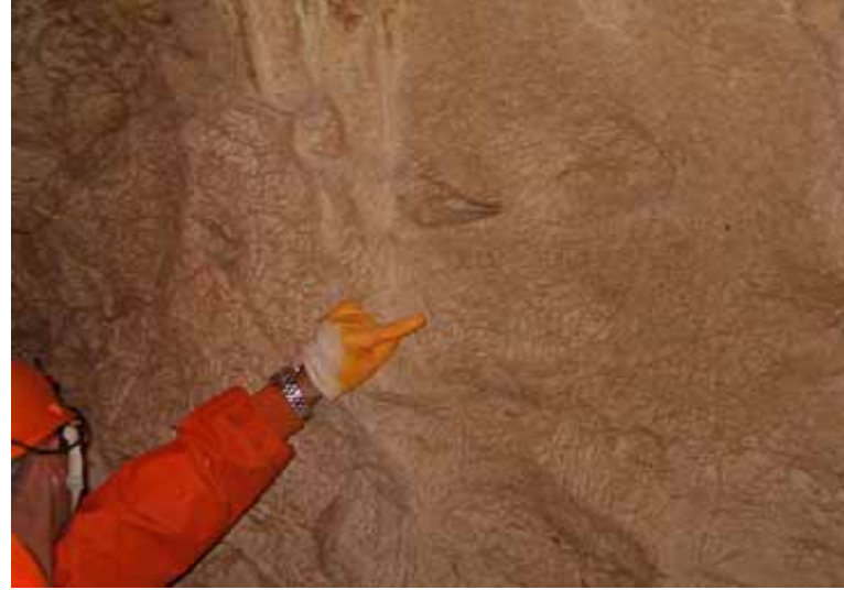
Aşınmış duvar akma taşları
