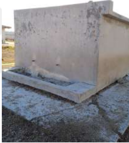
Fotoğraf 111: Kervan Köyü Çeşmesi/Doğu Cephe
