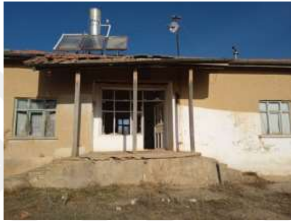
Fotoğraf 188: Tevfik Çamurcu'nun Evi/Giriş- Güney Cephe
