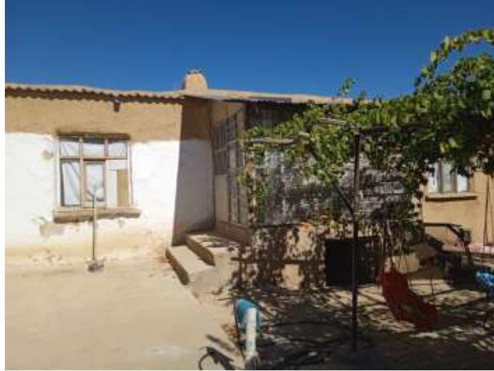
Fotoğraf 175: Süleyman Çetin'in Evi Giriş Cephesi
