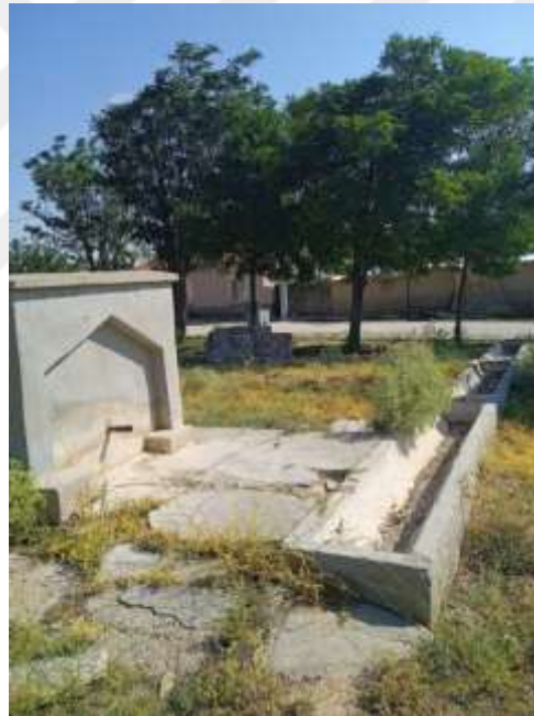
Fotoğraf 101: Çaltı Köyü Çeşmesi/Kuzey Cephe/Hatıllar
