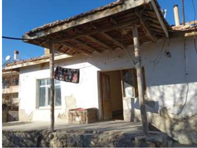
Fotoğraf 149: Muhammed Korkusuz'un Evi/ Giriş Güney Cephesi
