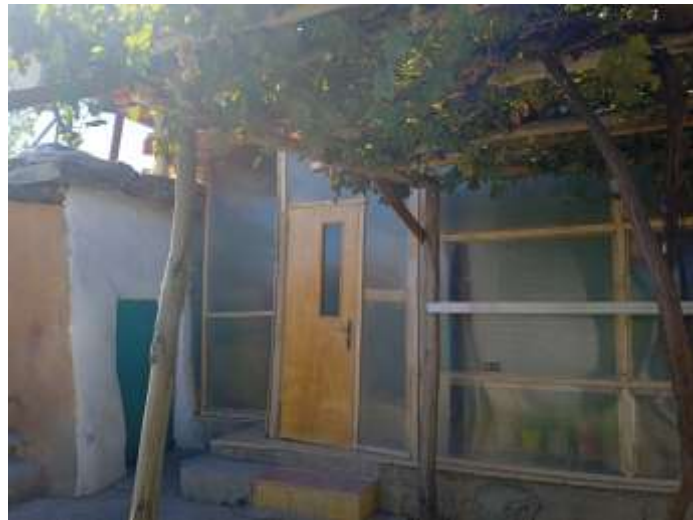
Fotoğraf 182: Şaban Kaya'nın Evi Giriş/Doğu Cephe
