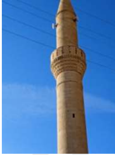
Fotoğraf 61: Karaömerler Köyü Cami Minare
