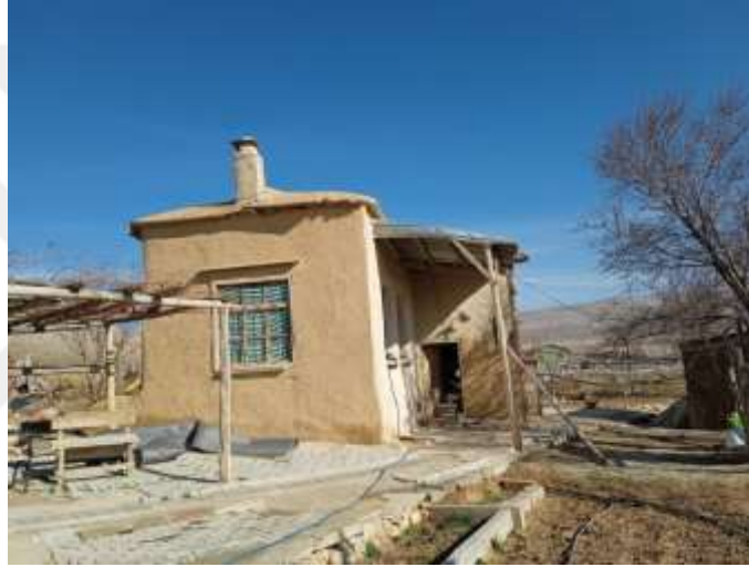
Fotoğraf 199: Ali Kalıntaş'ın Odası / Güneydoğu Cephe
