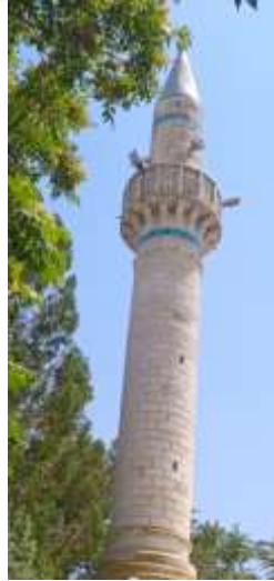
Fotoğraf 51: Güvenç Köyü Cami Minare
