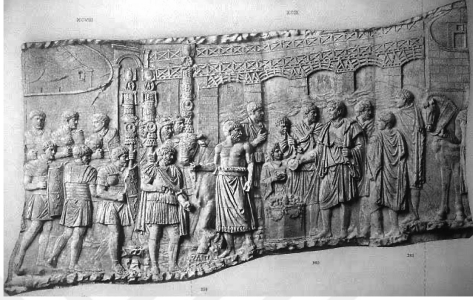
Şekil 2.15. Damascuslu Apollodoros tarafından inşa edilen Turnu Severin Köprüsü'nü gösteren kabartma, Traianus Sütunu (Floroni-Juravle 2019, Fig. 3)
