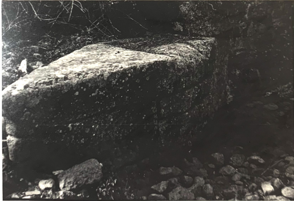
Şekil 1.21. Assos Köprüsü'nün eşkenar dörtgen planlı payandası (Bougia 1996, Pl. 97 b)
