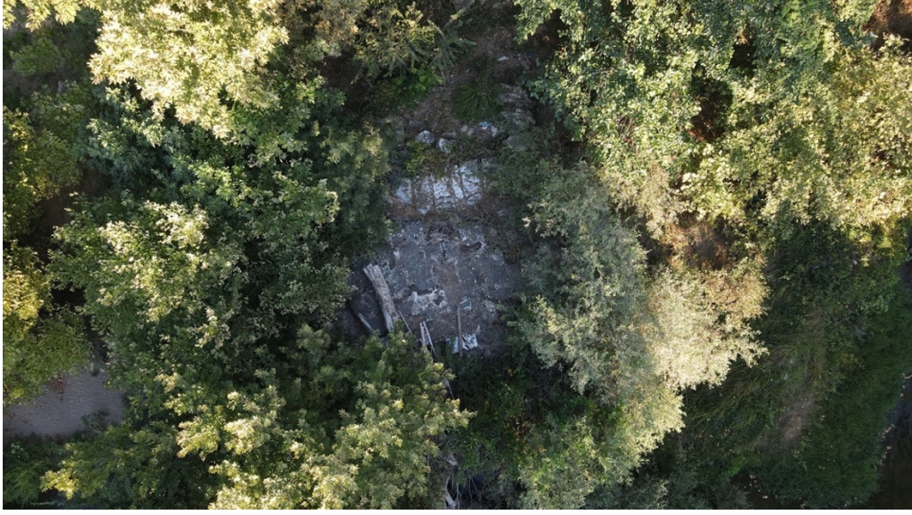
Şekil 6.38. Doğu kıyıdaki payandada mermer kaplamaya ait izler
