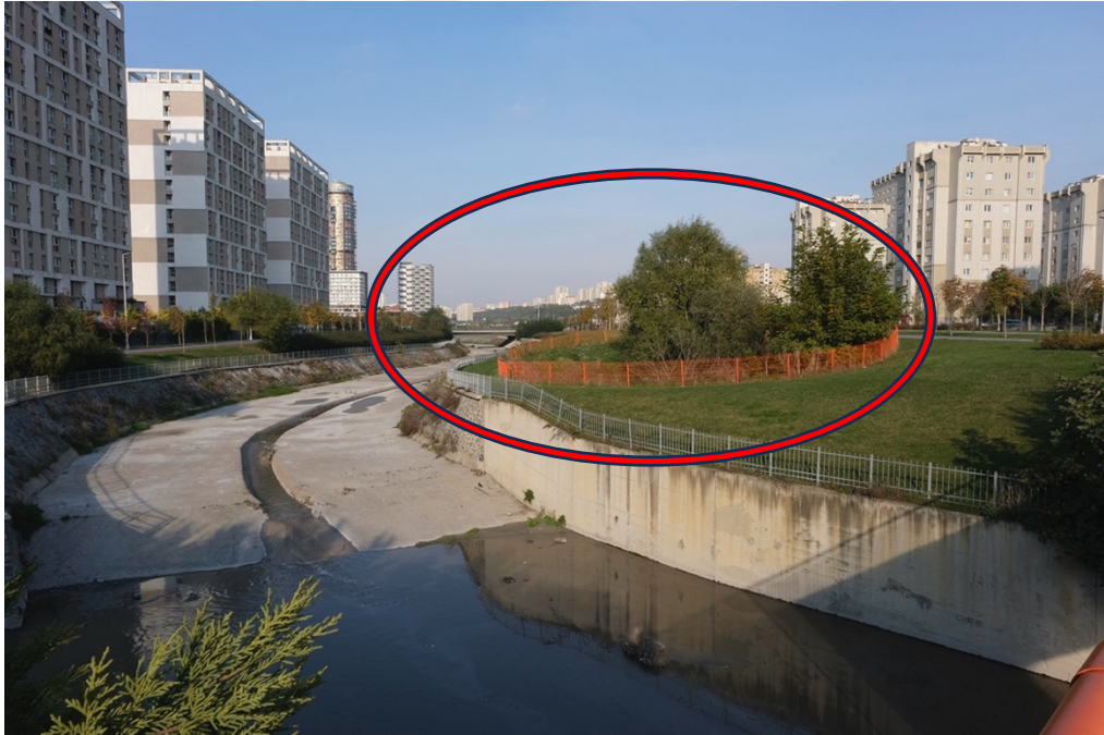
Şekil 6.16. Köprünün güncel durumu
