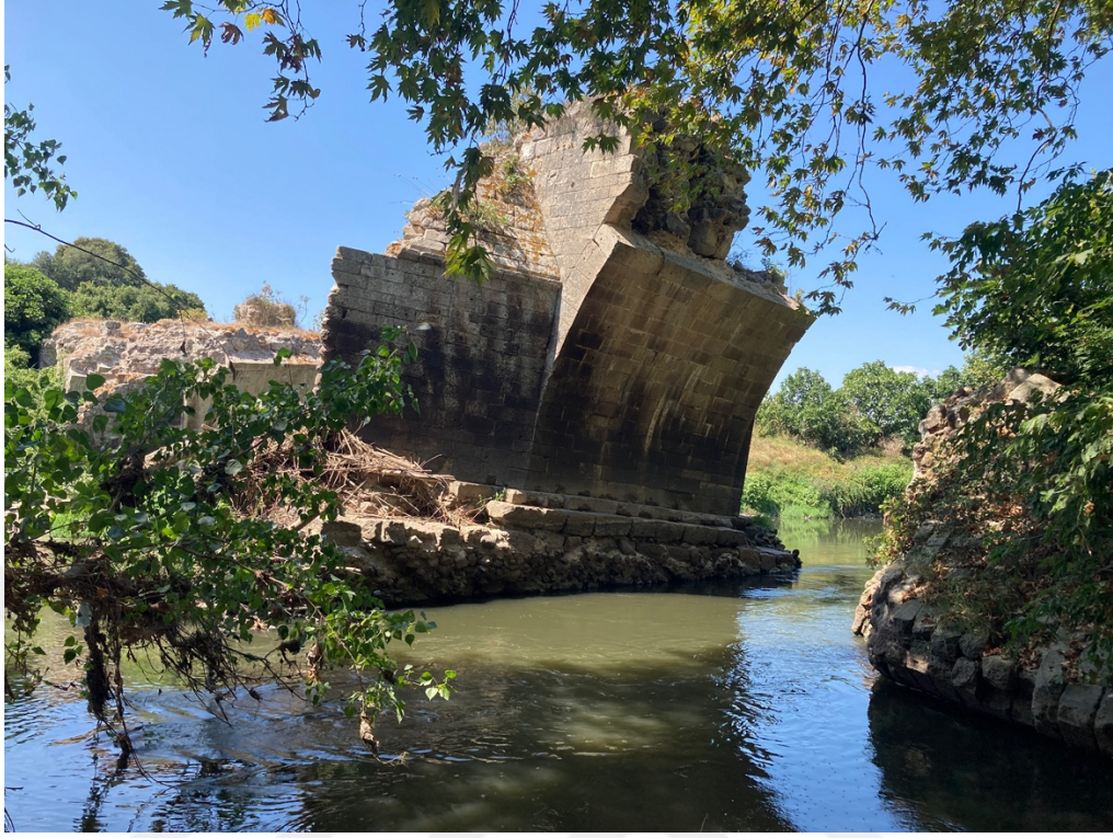
Şekil 1.18. Güvercin Köprüsü'nün ampatmanı
