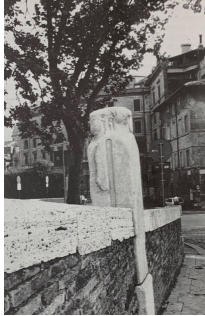
Şekil 1.27. Fabricius Köprüsü'nün parapet sütununa açılmış oluk (Galliazzo 1994 I, Fig. 172)
