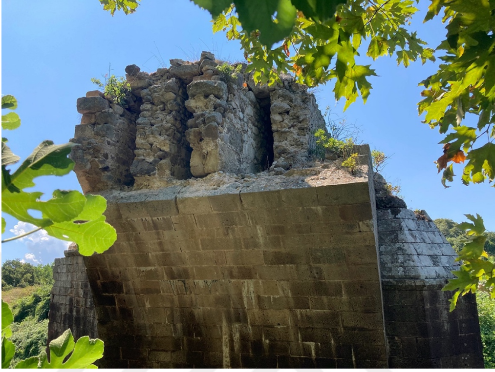
Şekil 6.42. Hafifletme olukları ve buradaki opus caementicium duvar örgüsü
