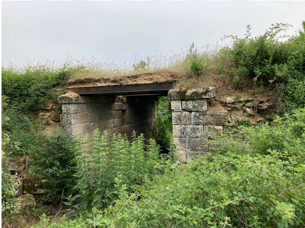
Şekil 6.28. Köprünün kuzeydoğu cephesi
