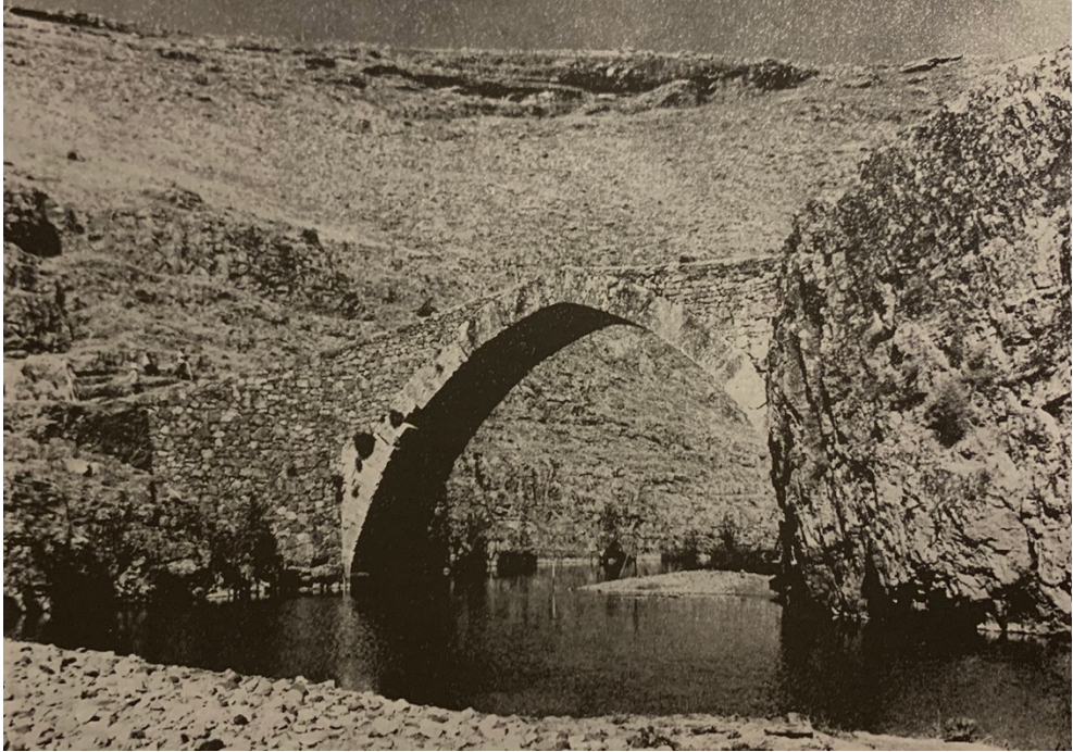
Şekil 2.5. Karamağara Köprüsü (Çulpan 2002, Lev. IV. Res. 6)
