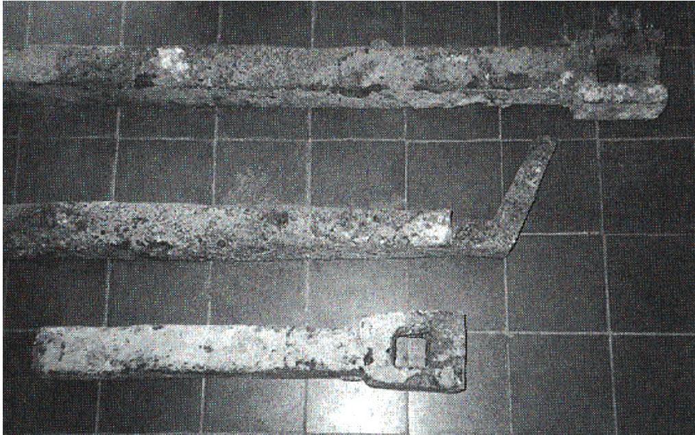
Şekil 1.35. Aspendos Köprüsü'nün demir kenetleri (Kessener-Piras 1998, Fig. 12)
