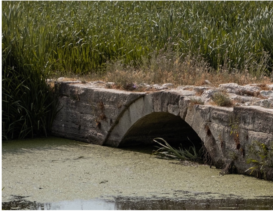
Şekil 6.15. İçerlek kemer kasağı ve murç izleri bulunan bosajlı tempan blokları
