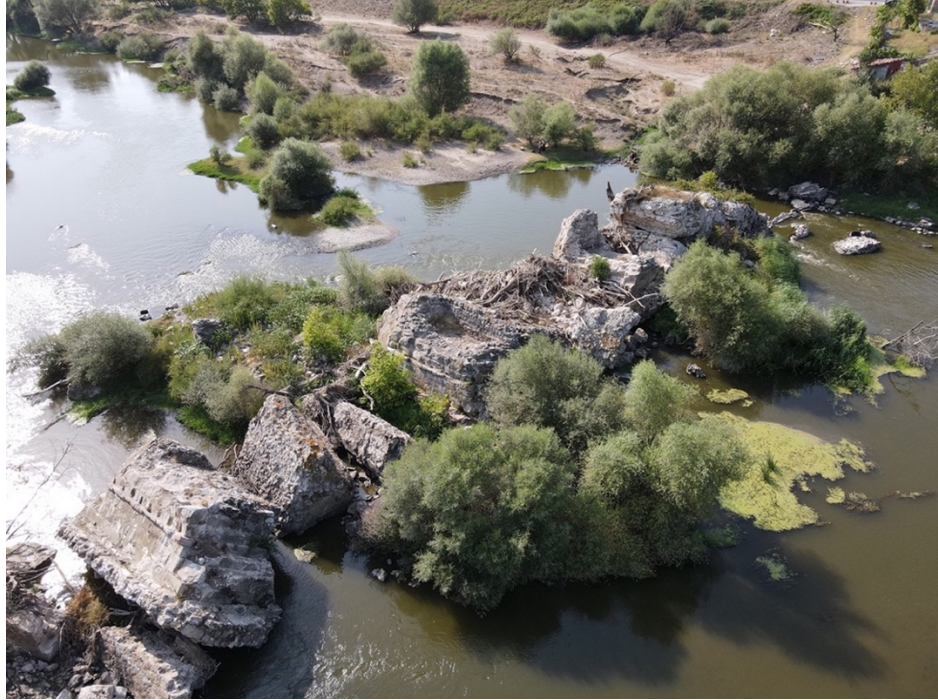
Şekil 6.50. Köprünün batı cephesi
