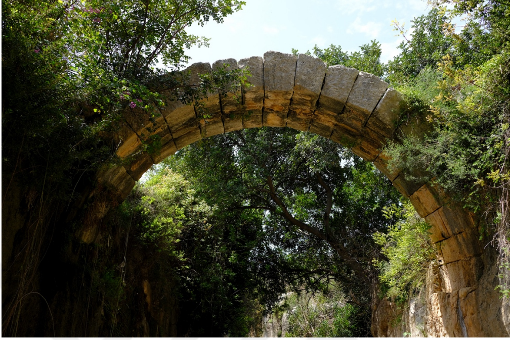
Şekil 2.8. Titus Tüneli Köprüsü
