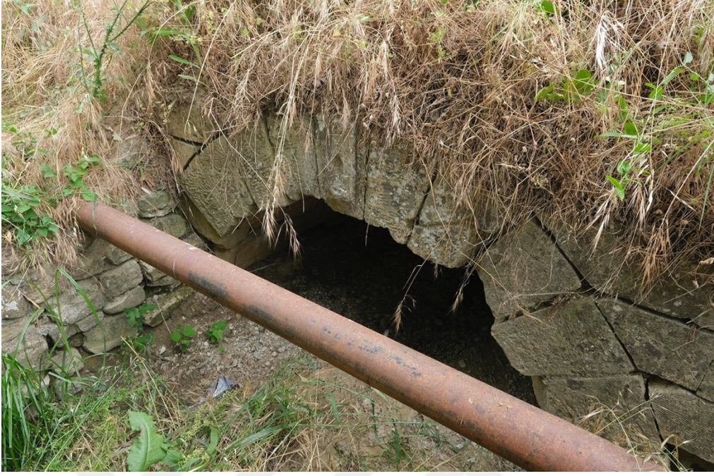
Şekil 6.5. Köprünün doğu cephesi
