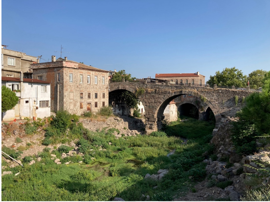
Şekil 1.22. Bergama Tabak Köprüsü'nün payandasına bitişik inşa edilen konutlar
