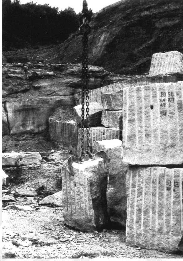
Şekil 1.41. Blokların yerlerine yerleştirilmesini gösteren fotoğraf (O'Connor 1993, Fig. 13)
