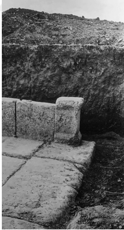
Şekil 1.31. Tuzla Gülpınar Köprüsü'nün konsol şeklinde düzenlenen baba taşı (Özgünel 2001, Lev. 26b)
