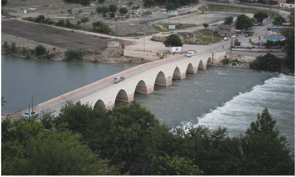
Şekil 3.20. Misis/Mopsouhestia Köprüsü (Durukan-Göçmen 2022, Fig. 1)
