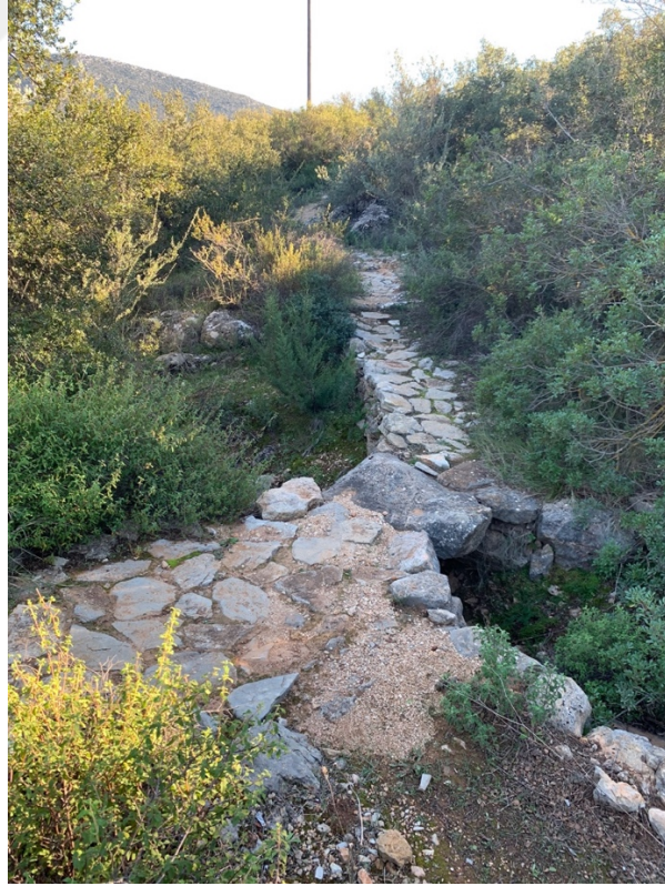
Şekil 1.5. Metokhi Köyü yakınlarındaki kiriş köprü
