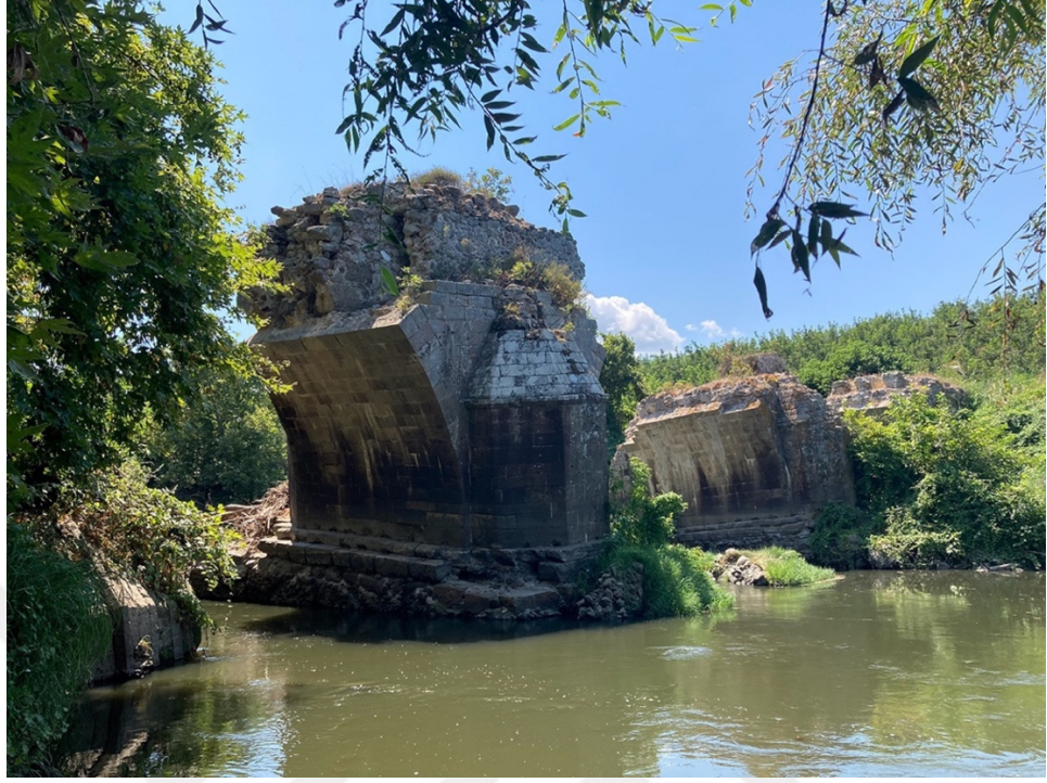
Şekil 6.40. Akıştaki payandaların mansaptan görünüşü ve temel dolgusu
