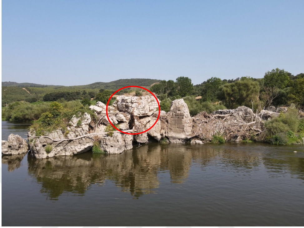
Şekil 6.51. Köprünün doğu cephesi ve korunagelen hafifletme odacıklarından biri
