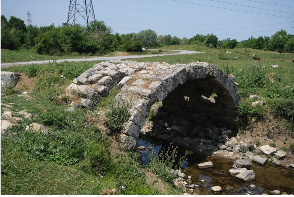
Şekil 6.31. Köprünün güneydoğu cephesi
