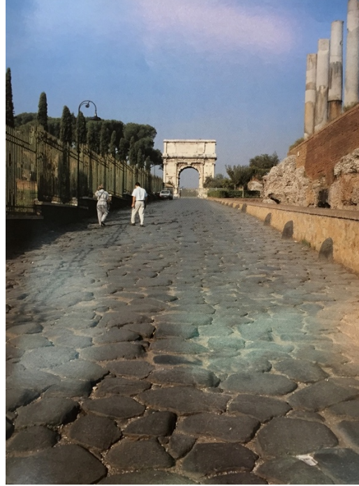
Şekil 3.4. Büyük, çokgen taşlarla yapılan yol döşemesi, Via Sacra (Heinz 1989, Fig. 63)
