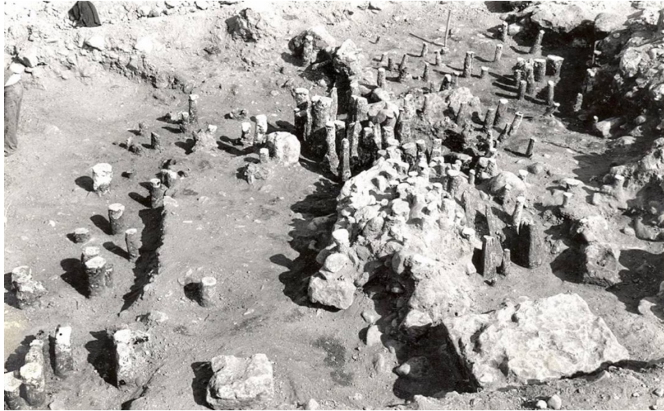
Şekil 2.13. Amphipolis Köprüsü'nün kazıklı temelleri (Maniatis vd. 2010, Fig. 6)
