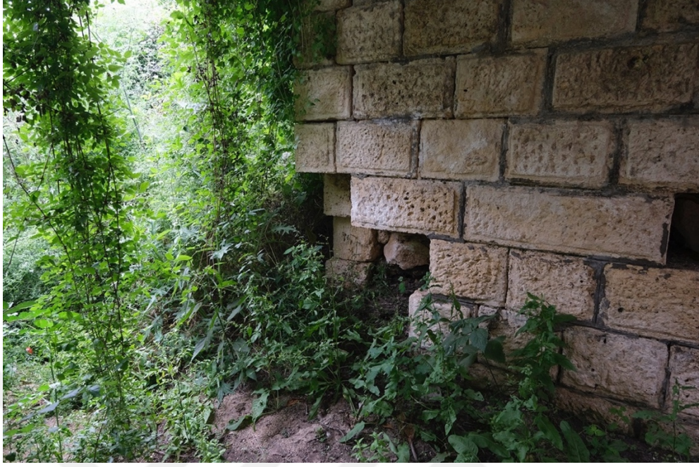
Şekil 6.29. Bosajlı, konturlu ve murç izleri bulunan payanda blokları
