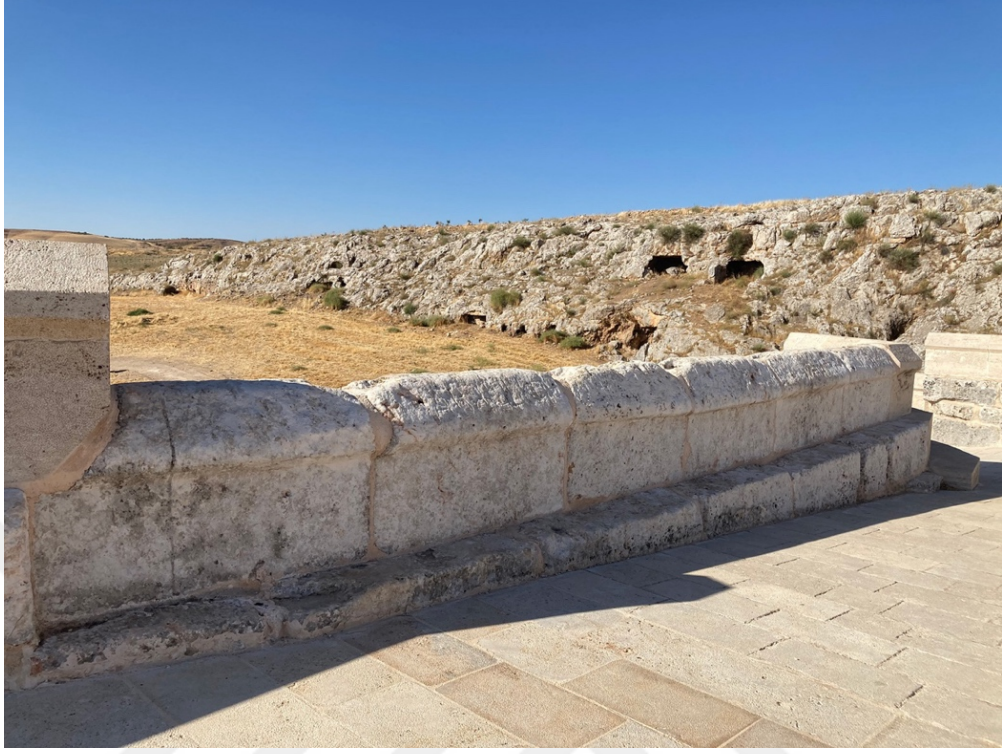
Şekil 1.28. Singas/Kızilin Köprüsü'nün parapetleri
