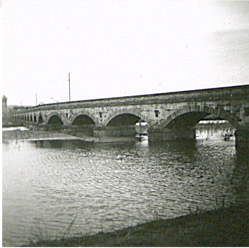
Şekil E13. Gazi Mihal Köprüsü (Salt Arşivi-Ülgen Ailesi Koleksiyonu)
