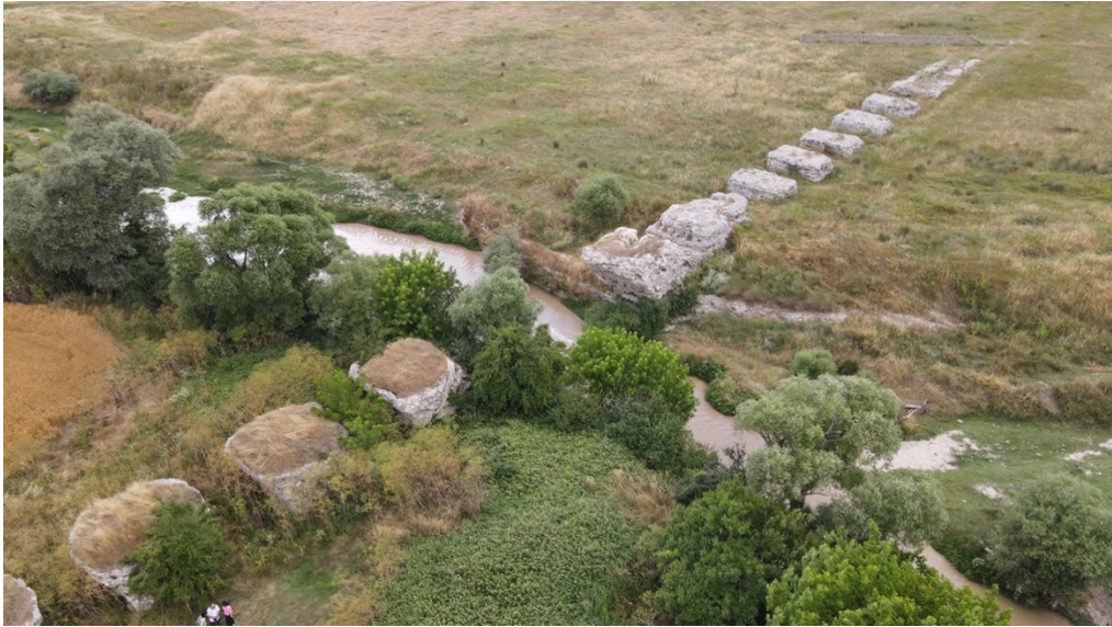
Şekil 6.21. Kemer yastık seviyesine kadar korunan payandalar
