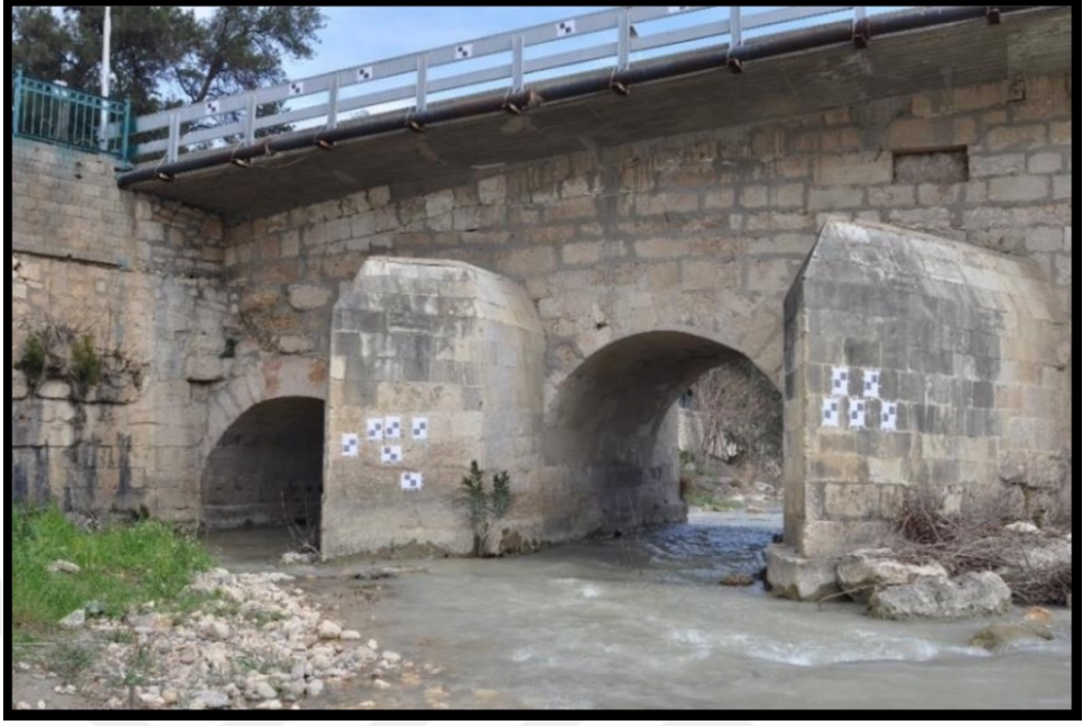
Şekil 2.32. Kalykadnos üzerindeki Taşköprü'nün, daha sonra boşaltma gözleri olarak işlevlendirilen kemerleri (Yeşilbaş 2016, Foto. 5)
