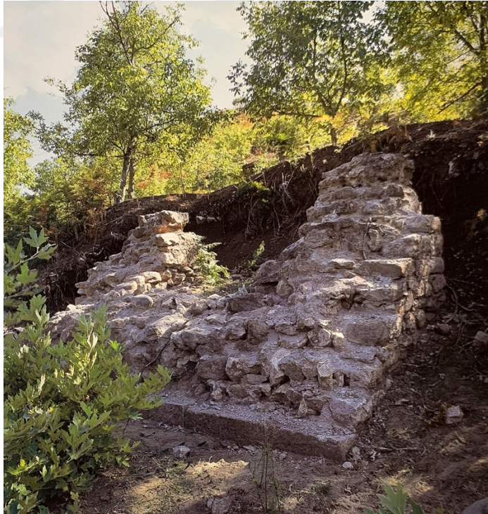
Şekil 3.10. Qukes-Skenderbej yakınlarındaki bir diğer köprüye ait payanda temeli (Lolos 2008, Fig. 33)
