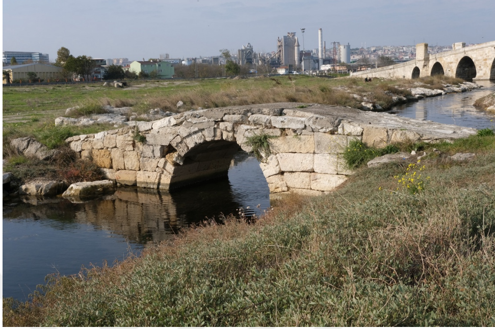
Şekil E10. Büyükçekmece Köprüsü'nün güneyindeki tek açıklıklı köprü
