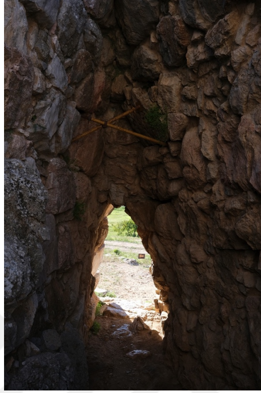
Şekil 1.11. Tiryns'te bindirme tonozlu giriş
