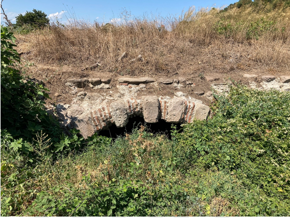
Şekil 6.44. Doğu girişteki segmental kemer
