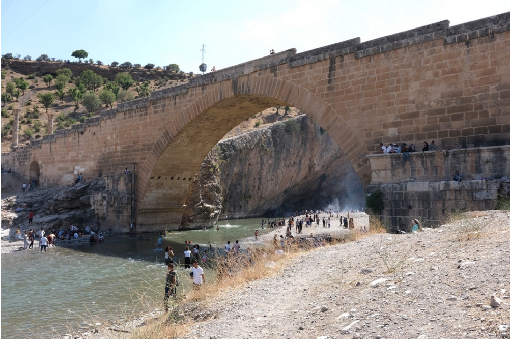
Şekil 1.29. Cendere Köprüsü'nün parapetleri
