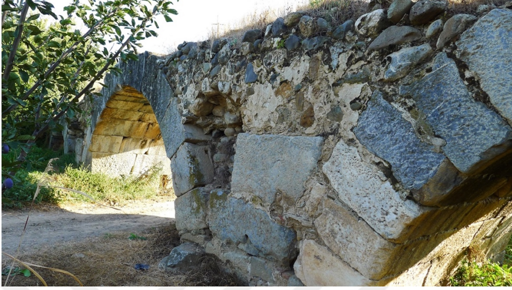
Şekil 6.58. Alt yarıya ait iri boyutlu bloklar ve kuzeydoğu cephedeki sıva izleri
