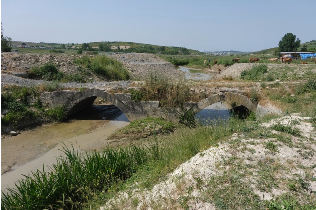
Şekil 6.33. Köprünün güney cephesi
