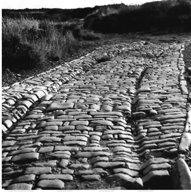
Şekil 3.3. Gard yakınlarında, döşemeli yola ait tekerlek izleri, M.S. 1. yy. (Adam 2005, Fig. 647)
