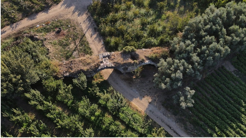
Şekil 6.57. Köprünün üst yapı elemanları (Uğur Derinoğullu arşivi)
