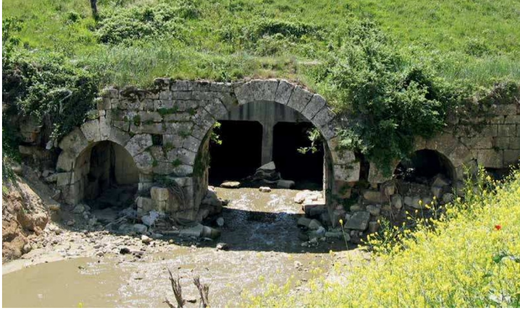
Şekil 6.9. Köprünün restorasyondan öndeki durumu (Aydıngün-Bilgili 2015, Fig. 4)
