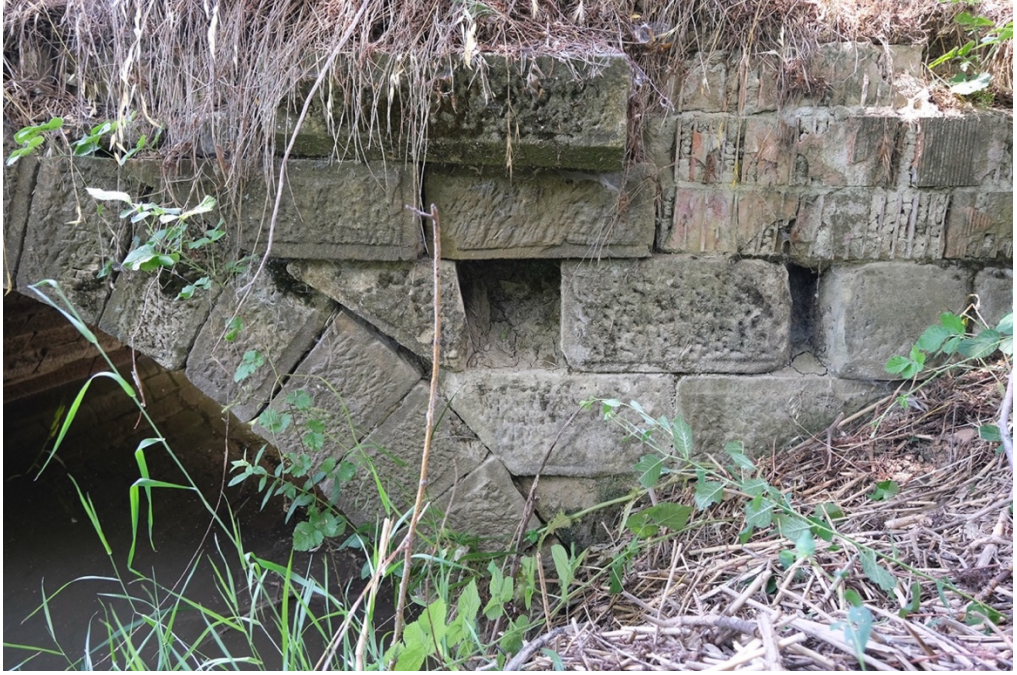
Şekil 6.4. Kemer ve tempan duvarı oluşturan bosajlı, konturlu, murç izli bloklar
