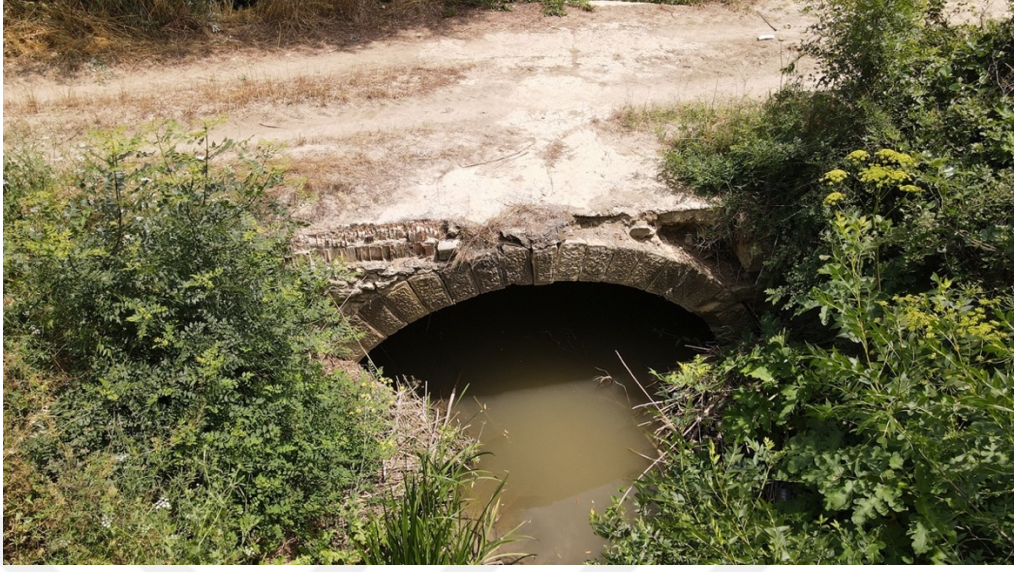
Şekil 6.3. Köprünün doğuya bakan cephesi
