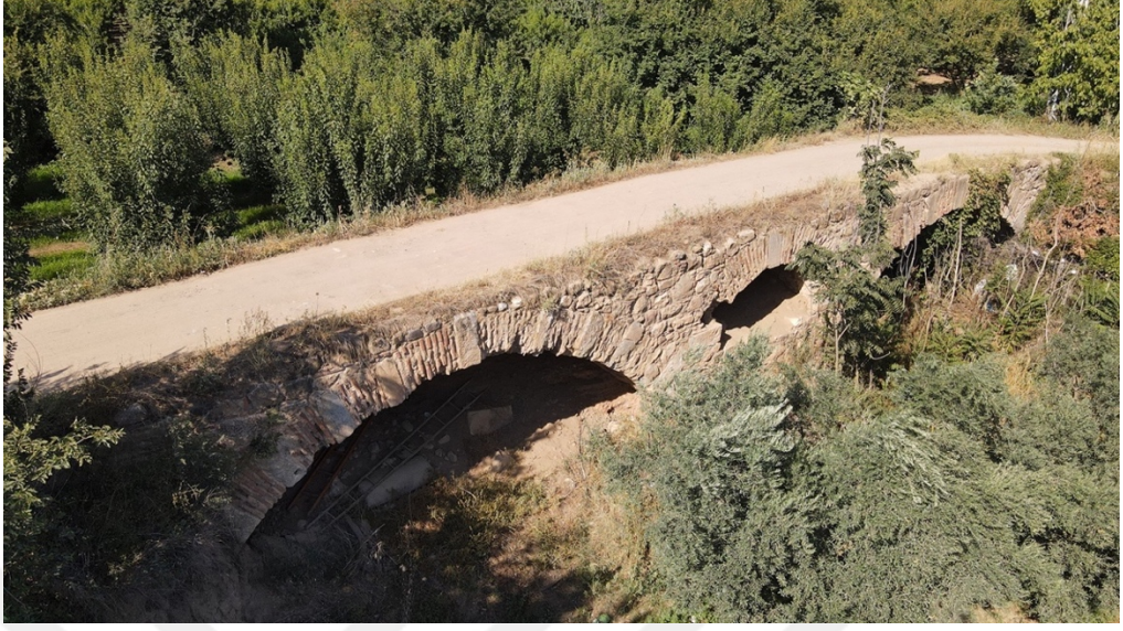
Şekil 6.53. Köprünün güney cephesi
