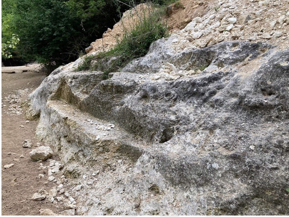
Şekil 6.26. Batı payanda için basamaklı biçimde düzenlenen ana kaya
