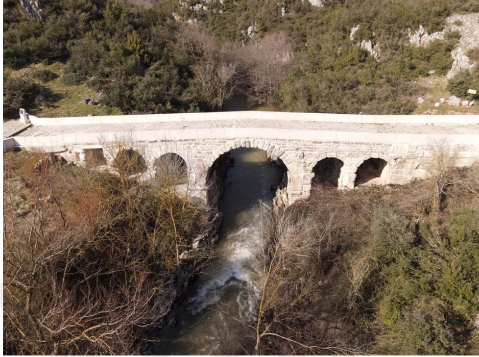
Şekil 6.61. Köprünün güney cephesi
