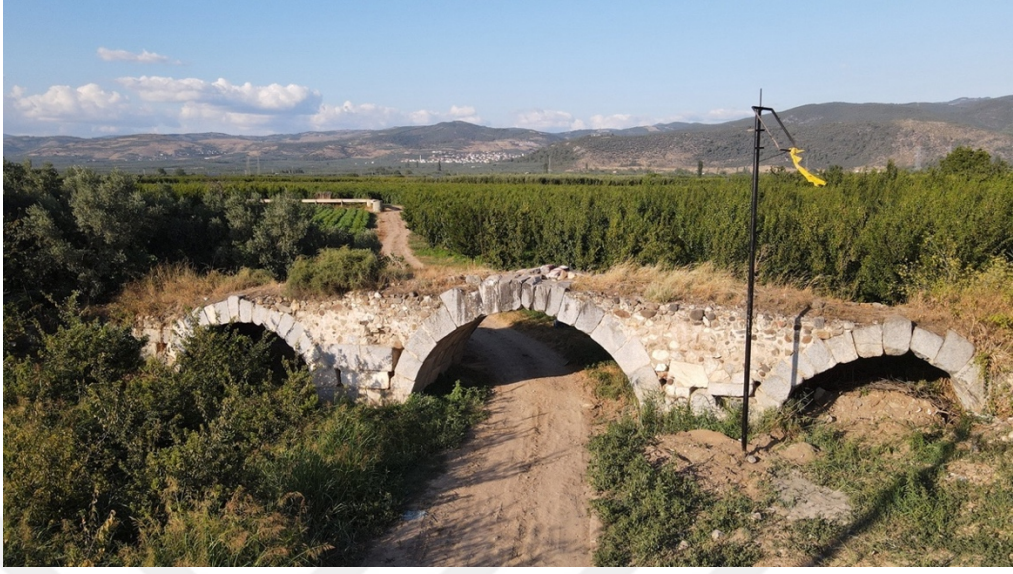
Şekil 6.56. Köprünün güneybatı cephesi
