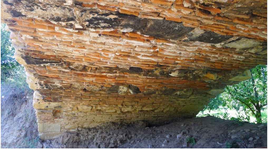
Şekil 6.54. Kemer kasnağındaki almalı örgü
