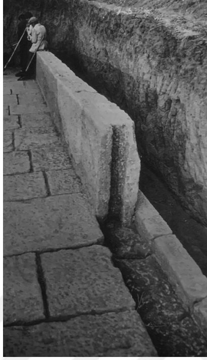
Şekil 1.26. Tuzla Gölpinar Köprüsü'nün balustradlı parapetleri (Özgünel 2001, Lev. 26a)
