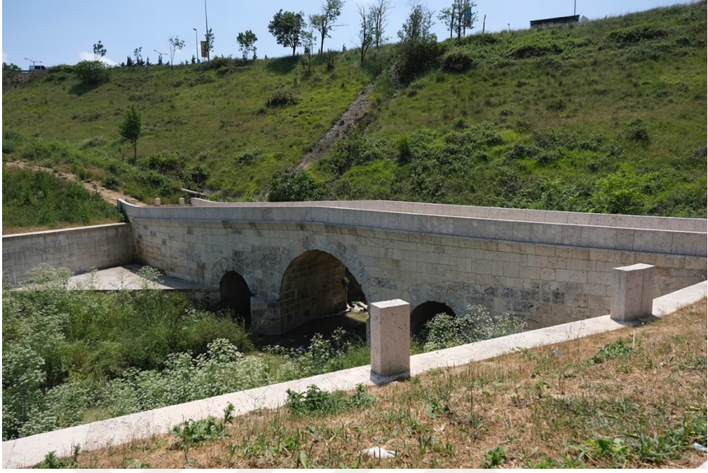
Şekil 6.10. Köprünün kuzey (membra) cephesi
