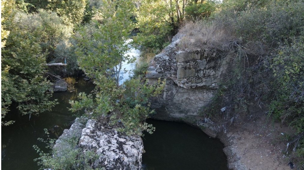
Şekil 6.36. Batı payandanın kuzey cepheden görünüşü
