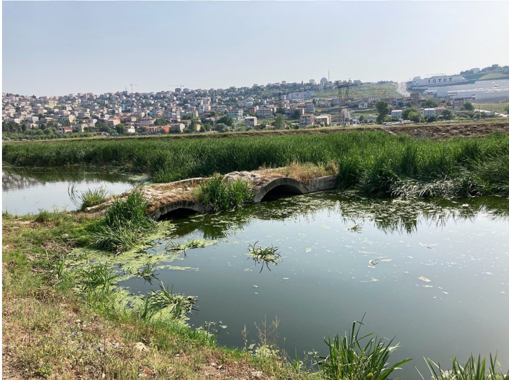
Şekil 6.13. Köprünün kuzey cephesi
