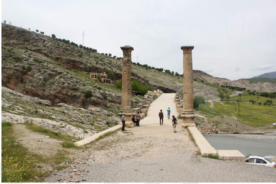
Şekil 1.33. Cendere Köprüsü'nün girişlerinde bulunan sütunlar
