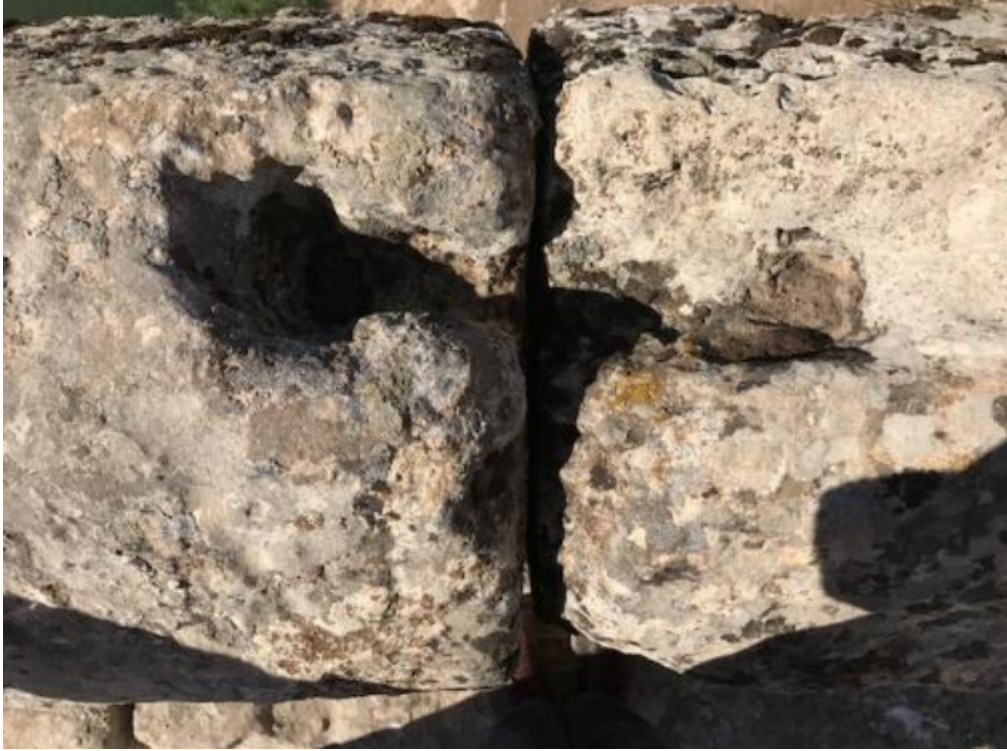
Şekil 1.36. Kızılın Köprüsü'ndeki "Pi" ( \pi ) formlu kenete ait iz (Avşin 2020, Çizelge 4.36)
