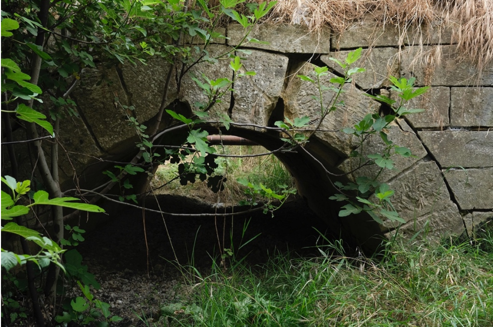
Şekil 6.6. Köprünün batı cephesi
