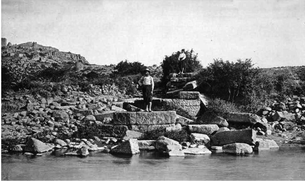
Şekil 2.14. Assos'taki almasıık köprüye ait payanda (Clarke vd. 1902-1921, Fig. 1, 133)
