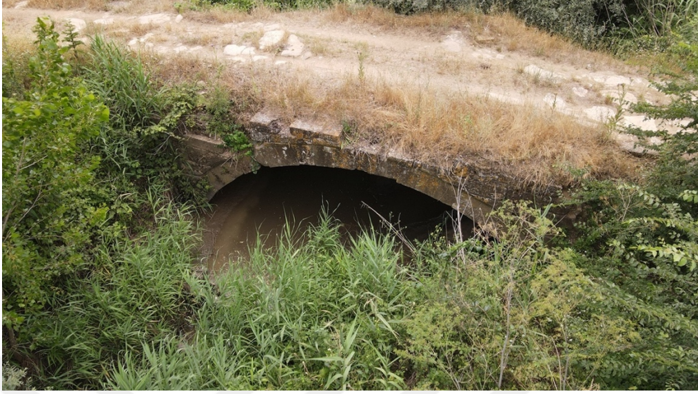
Şekil 6.1. Köprünün batı cephesi
