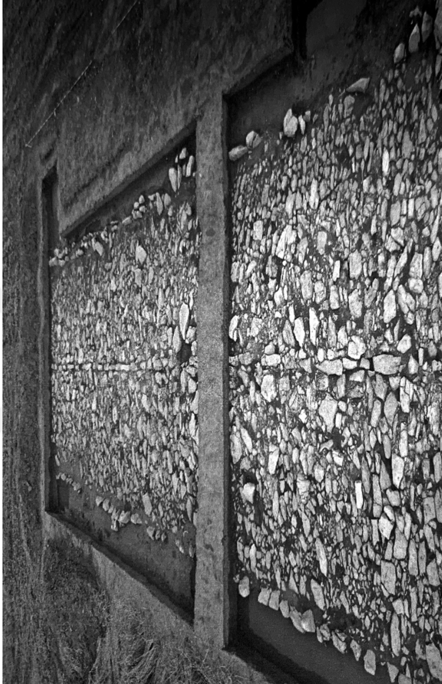
Şekil 3.15. Gojin Dol Kalesi yakınlarında, Via Traiana/Militaris/Diagonalis 'e ait döşemeli yol kalıntısı (Petrovic 2019, Fig. 4)
