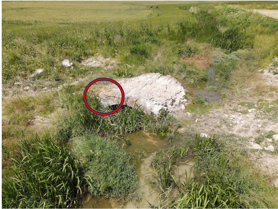
Şekil 6.20. Kemer üst dolgusunun korunagelen bir bölümü
