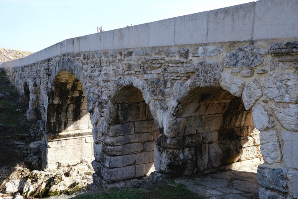
Şekil 6.64. Kuzey cephe ve sağdaki ilk kemerdeki çıkıntılı kilit taşı
