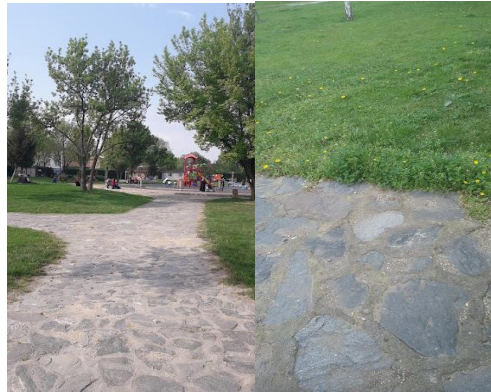
Şekil 4.23 Kayrak taşı döşeme yürüyüş yolları
