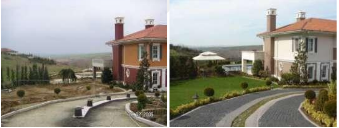
Şekil 2.49 Bir villa bahçesinde granit parke taşı uygulama öncesi ve sonrası (URL-37, 2023)
