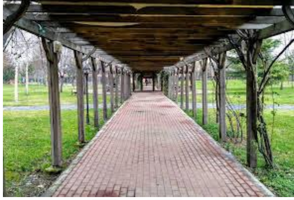
Şekil 4.24 Andezit taşı uygulaması
