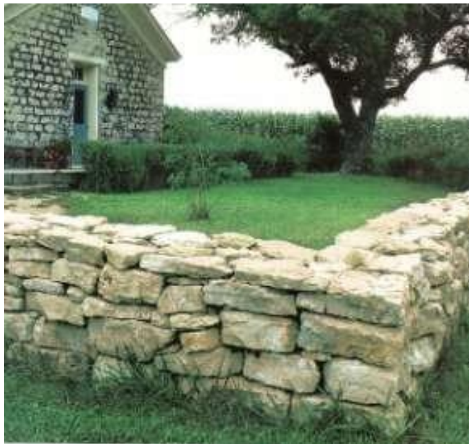
Şekil 2.28 Kuru taş duvar örneği (Sagui, 2009)
