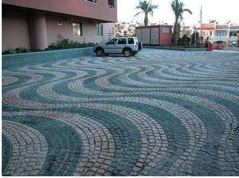
Şekil 2.50 Farklı döşeme desenlerinde parke taşı uygulama örneği (URL-38, 2012)
