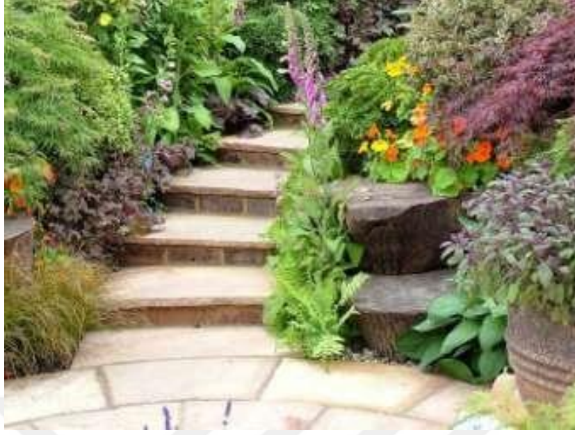
Şekil 2.52 Harçlı olarak yapılmış merdiven uygulamaları (Sagui, 2009)
