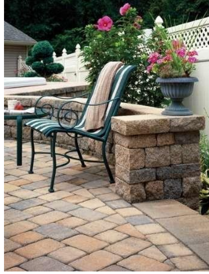
Şekil 2.10 Kumtaşı yer döşemesi ve duvar kaplaması uygulama örneği (URL-11, 2023)
