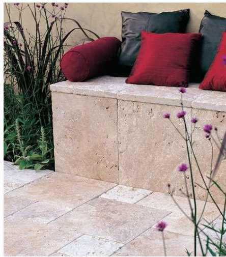
Şekil 2.11 Traverten taşın uygulama örneği (URL-12, 2023)
