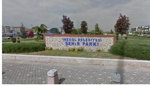
Şekil 4.11 Traverten taşı duvar kaplama
