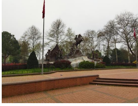
Şekil 4.26 Andezit taşı merdiven ve zemin döşemesi
