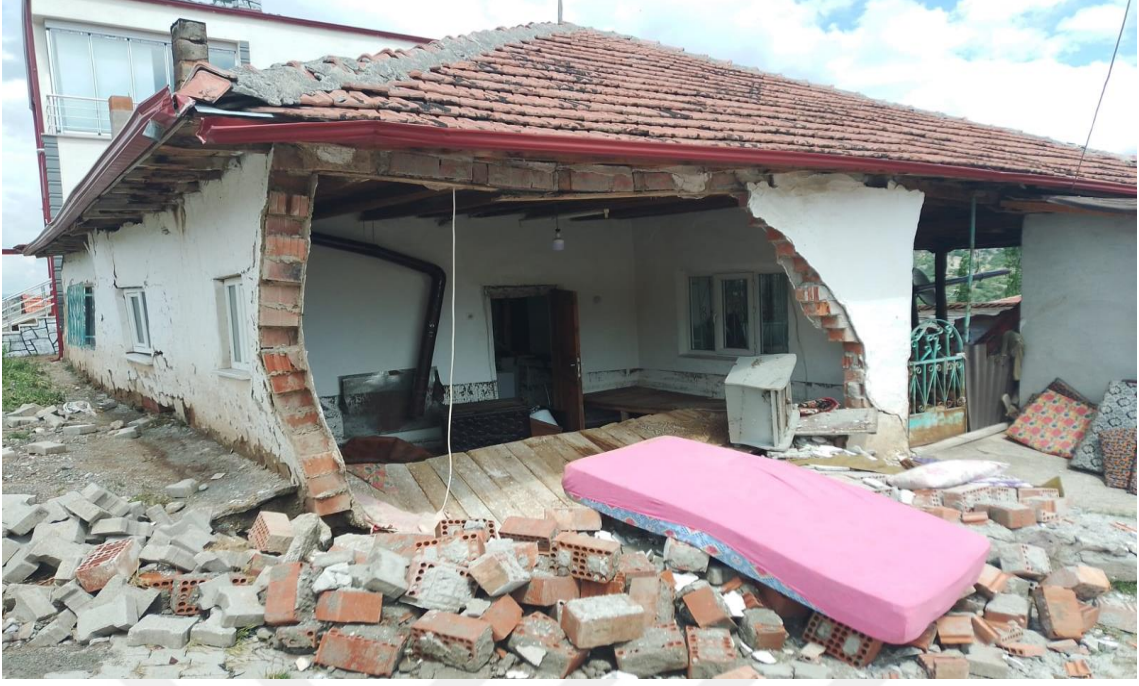
Resim 4.16. Sarıkaya İlçesinde 2022’de meydana gelen sel/su baskını hasar görseli
