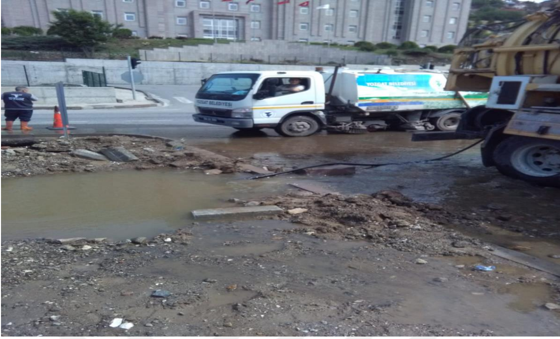
Resim 4.18. Yozgat merkez ilçesinde 2023'de meydana gelen sel/su baskını hasar görseli
