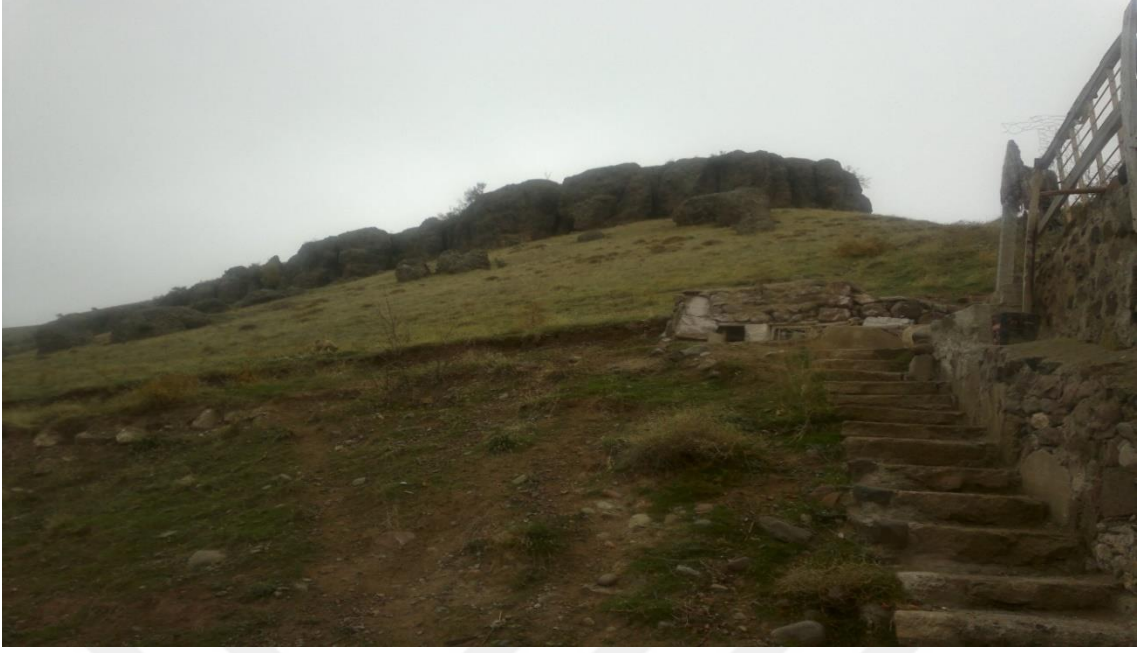
Resim 4.41. Kaya düşme riski taşıyan alan görseli, 2015, Beyvelioğlu Köyü, Yozgat
