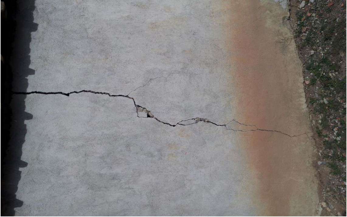
Resim 4.54. Heyelan afeti yapısal hasar alan yapıların görseli, 2013, Tarhana, Akdağmadeni
