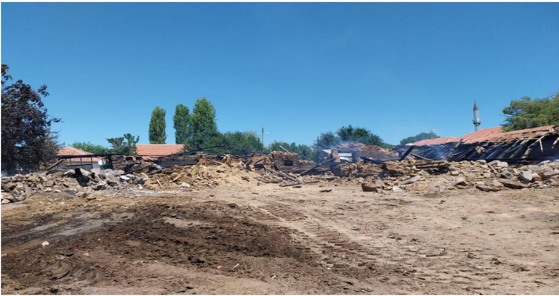
Resim 4.23. Yangın Afeti hasar görseli, 2023, Akdağmadeni, Yozgat
