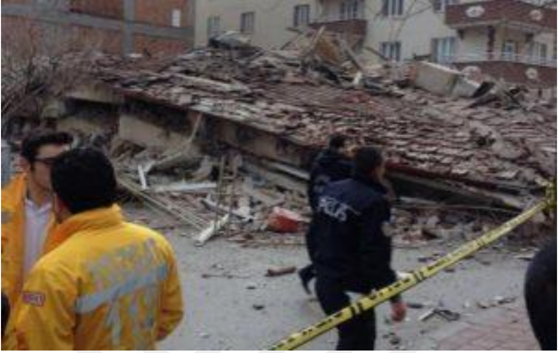
Resim 4.66. Deprem afeti yapısal hasar alan yapıların görseli, 2016, Yerköy, Yozgat
