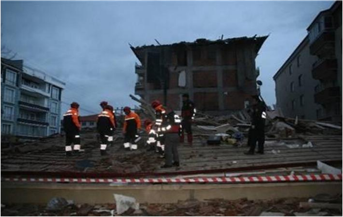
Resim 4.67. Deprem afeti yapısal hasar alan yapıların görseli, 2016, Yerköy, Yozgat
