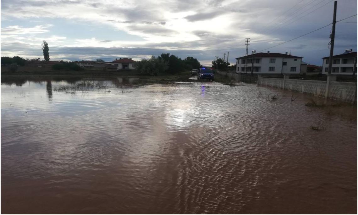
Resim 4.17. Sırçalı Beldesinde Köyünde 2022’de meydana gelen sel/su baskını hasar görseli
