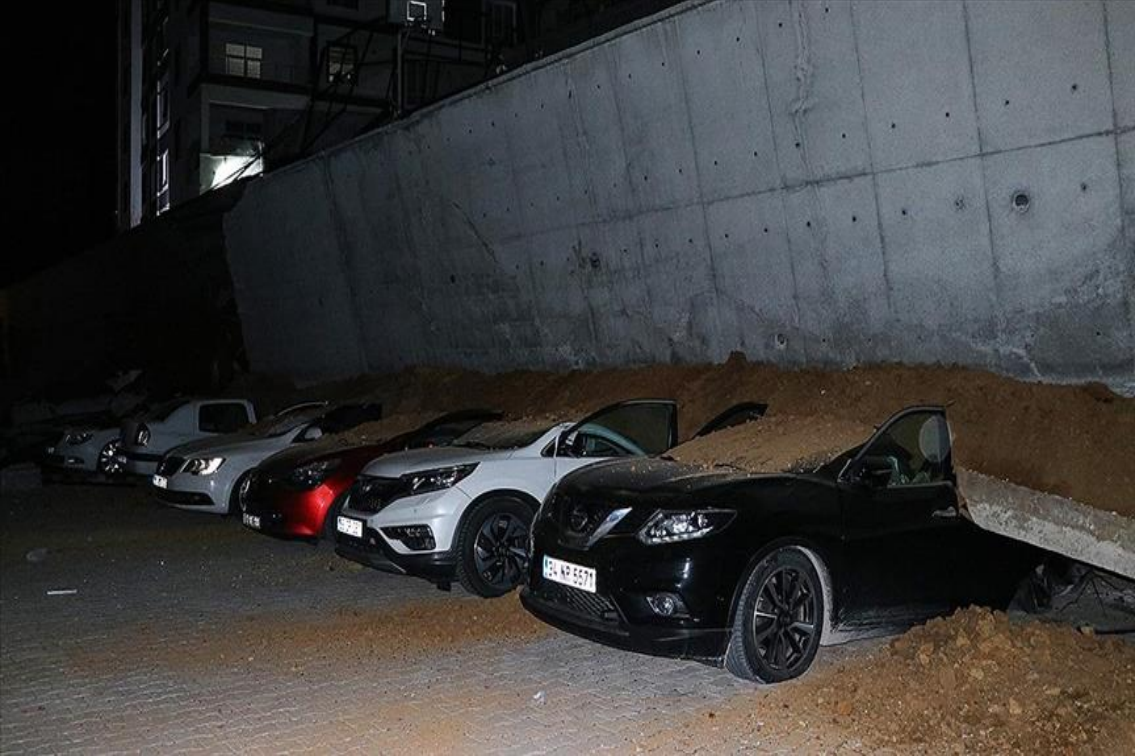
Resim 4.60. Heyelan afeti yapısal hasar alan yapıların görseli, Merkez, Yozgat
