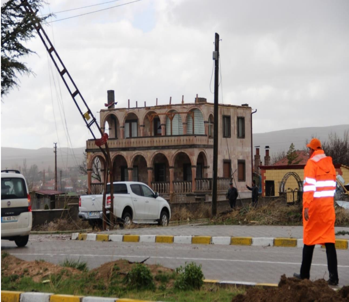
Resim 4.26. Fırtına Afeti hasar görseli, 2018, Çandır, Yozgat
