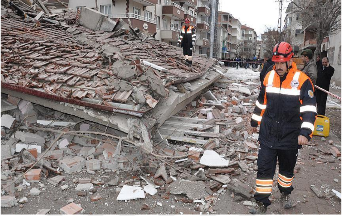
Resim 4.64. Deprem afeti yapısal hasar alan yapıların görseli, 2016, Yerköy, Yozgat
