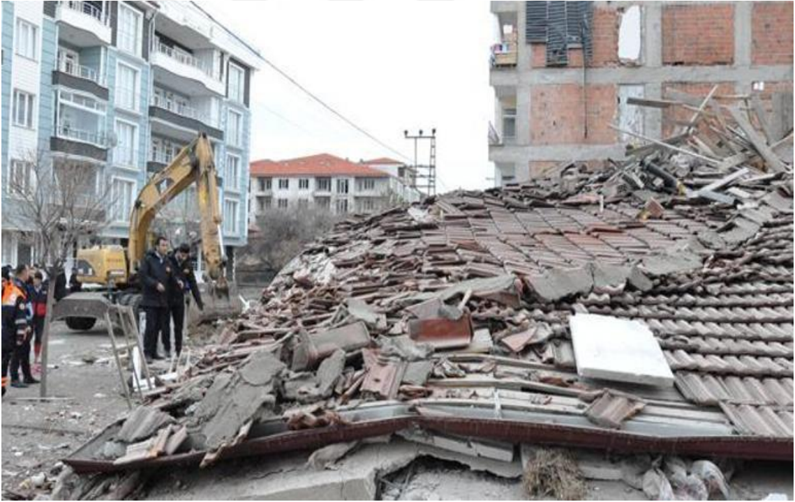
Resim 4.65. Deprem afeti yapısal hasar alan yapıların görseli, 2016, Yerköy, Yozgat
