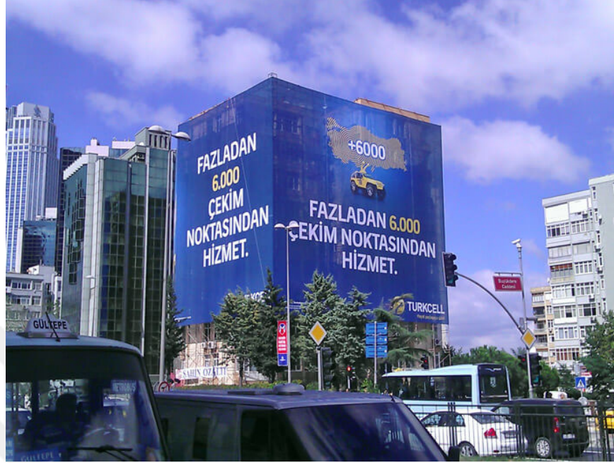
Şekil 2.8. Dış cephe giydirme örneği
