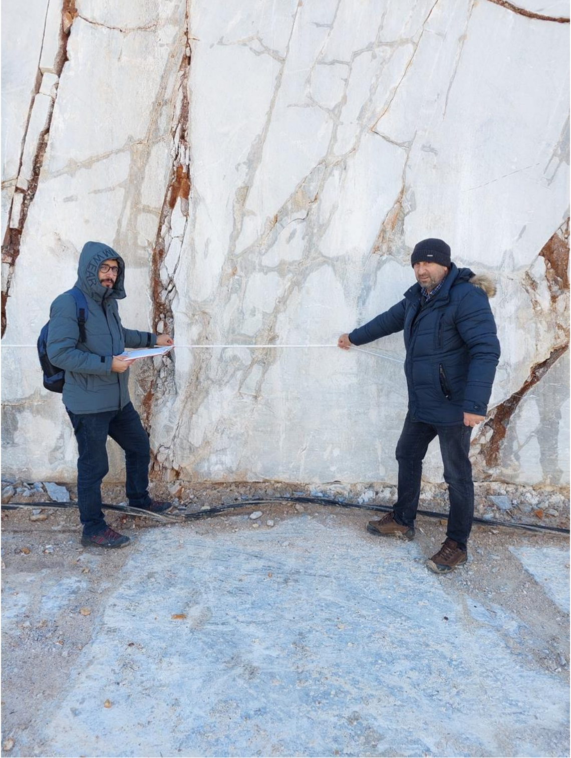
Resim 4.4 Arazi çalışmaları kapsamında ocak alanında bulunan aynadan kırık çatlak tespiti kapsamında yapılan çalışmalar.
