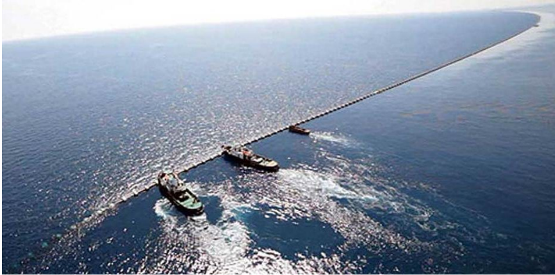
Şekil 2.23 : Türkiye Cumhuriyeti'nden KKTC'ye çekilen içme suyu boru hattının batırılma ve sabitleme işlemi (Url-23).
