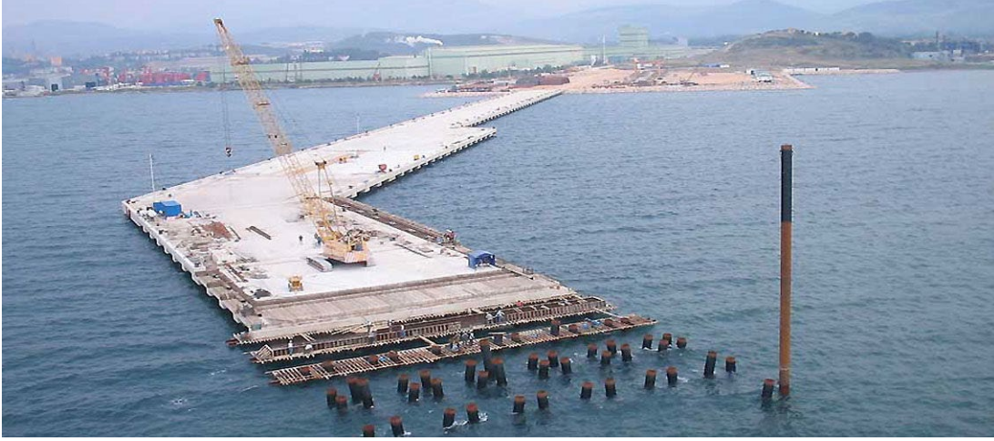
Şekil 2.16 : Tipik bir kazıklı iskele uygulaması (Url-16).
