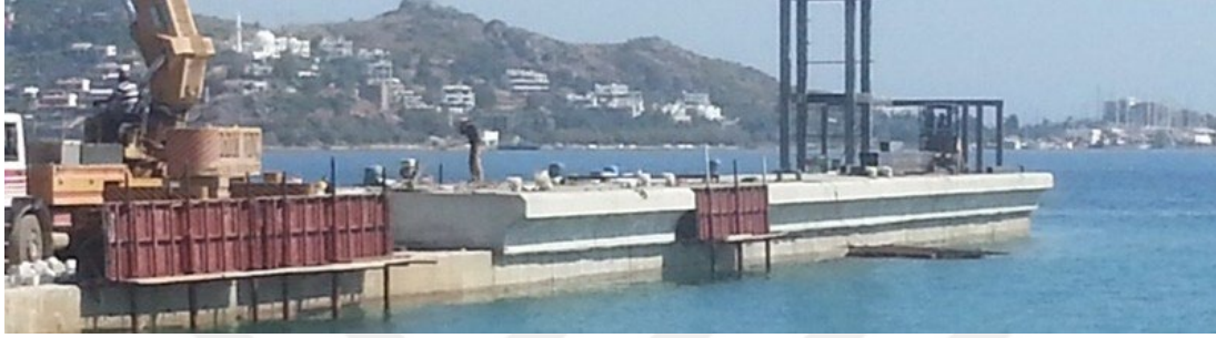
Şekil 2.13 : Yalıkavak yat limanında tipik bir betonarme yerinde döküm su içi beton ve kronmandan oluşan rıhtım duvarı inşaatı (Url-13).
