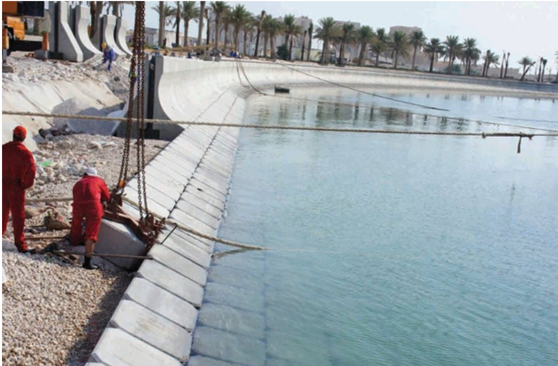
Şekil 2.20 : BAE’de hazır betonarme elemanlarla korunan kıyı örneği (Url-20).
