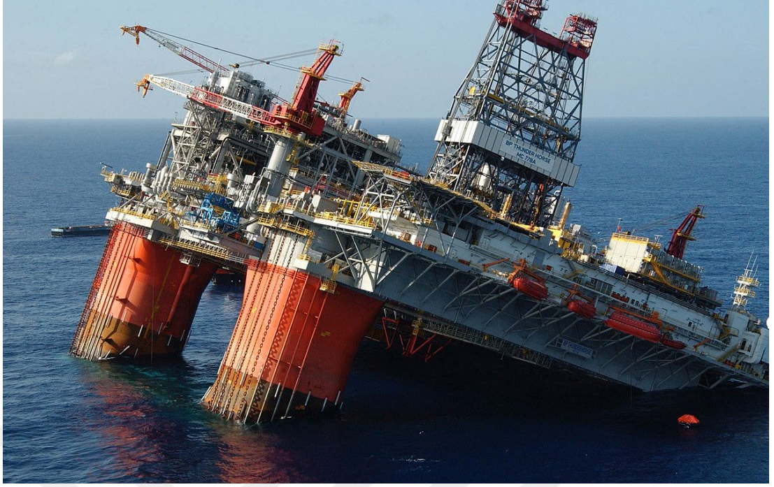
Şekil 3.20 : Deniz aşırı platform inşaatı sırasında devrilme sonrası ortaya çıkan patlama ile çıkan yangın ve denize kimyasal sızıntı (Url-42).
