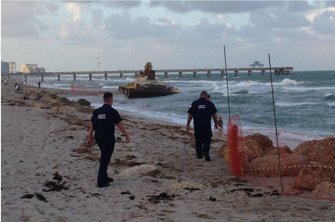
Şekil 3.26 : Halka açık bir plaja saçılmış tahkimat taşları ve iş dubasının çevreden izole edilmesi (Url-48).
