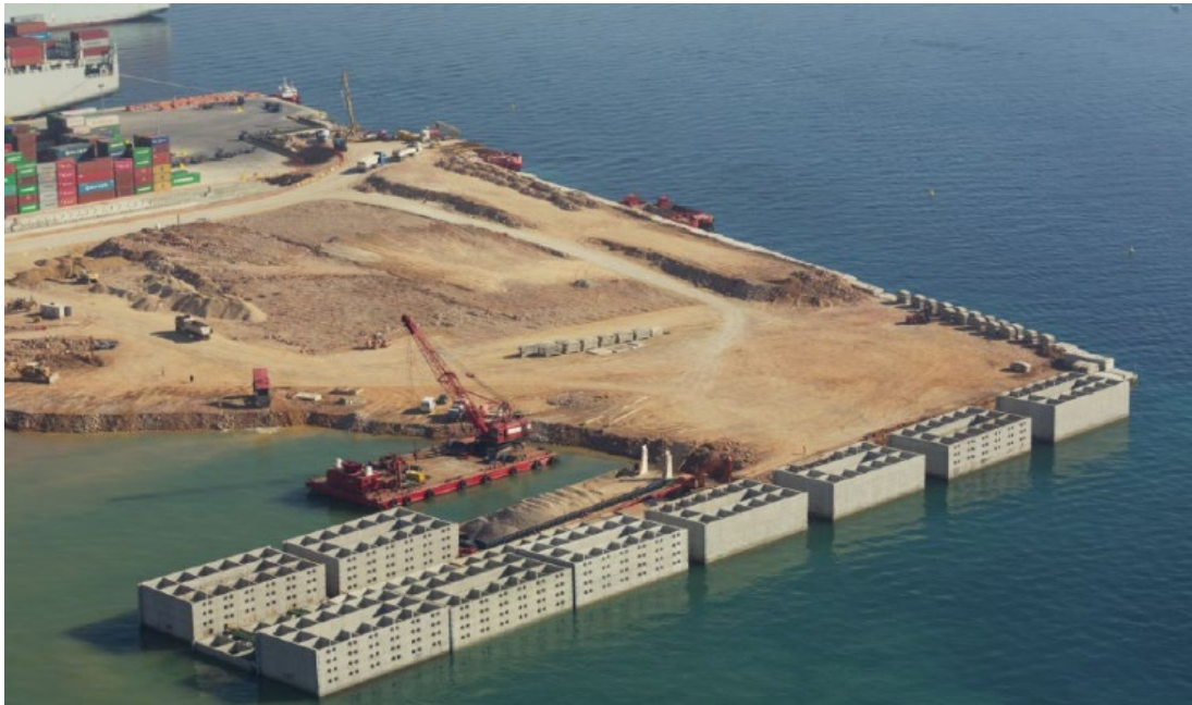
Şekil 2.14 : Pire limanında denize yerleştirilen keson rıhtım duvarları (Url-14).
