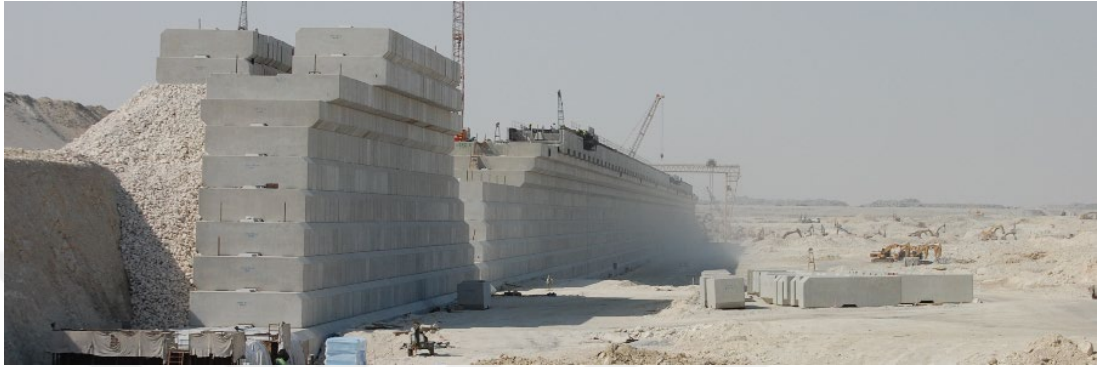
Şekil 2.15 : Katar limanında uygulanan ağırlık bloklı rıhtım duvarları (Url-15).
