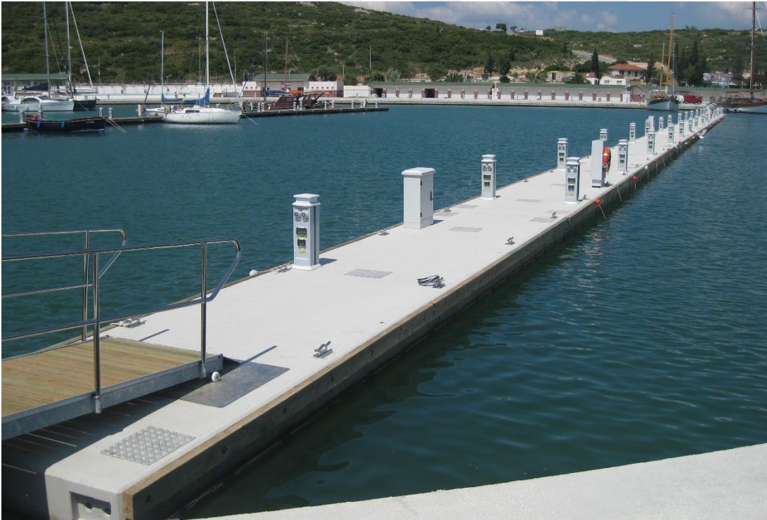
Şekil 2.17 : Teos Marina İşletme ve Ticaret A.Ş.'ye ait Sığacık'ta bulunan yat limanına yerleştirilen yüzen iskeleler (Url-17).
