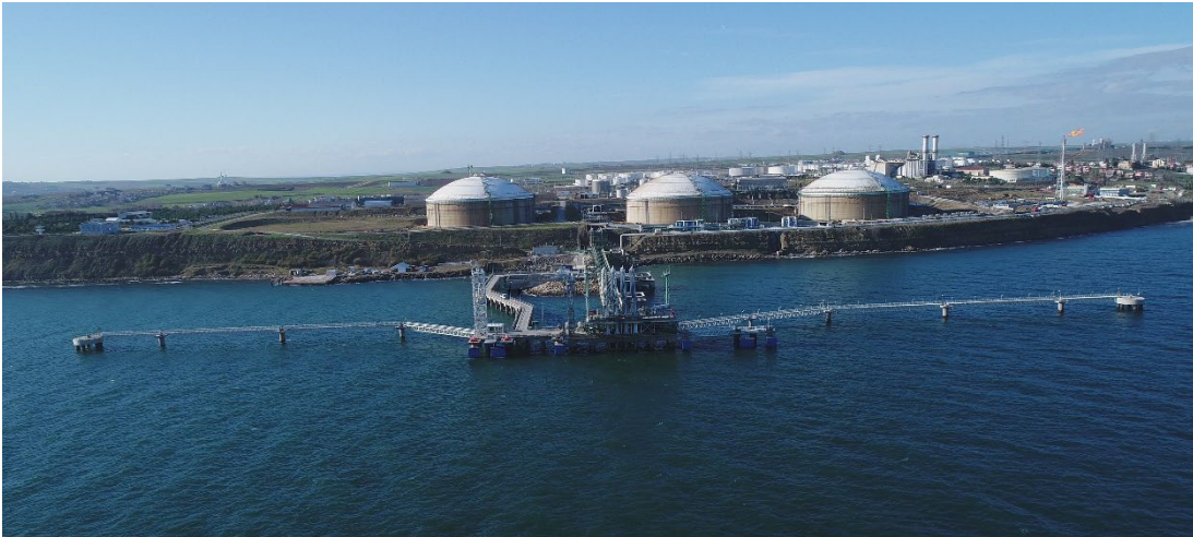
Şekil 2.5 : BOTAS Boru Hatları ile Petrol Taşıma A.Ş. Marmara Ereğlisi LNG terminali (Url-5).
