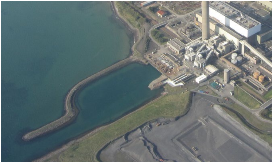
Şekil 2.26 : Kilroot Elektrik Santrali'ne ait olan taş dolgulu su alma ve su deşarj yapısı (Url-26).
