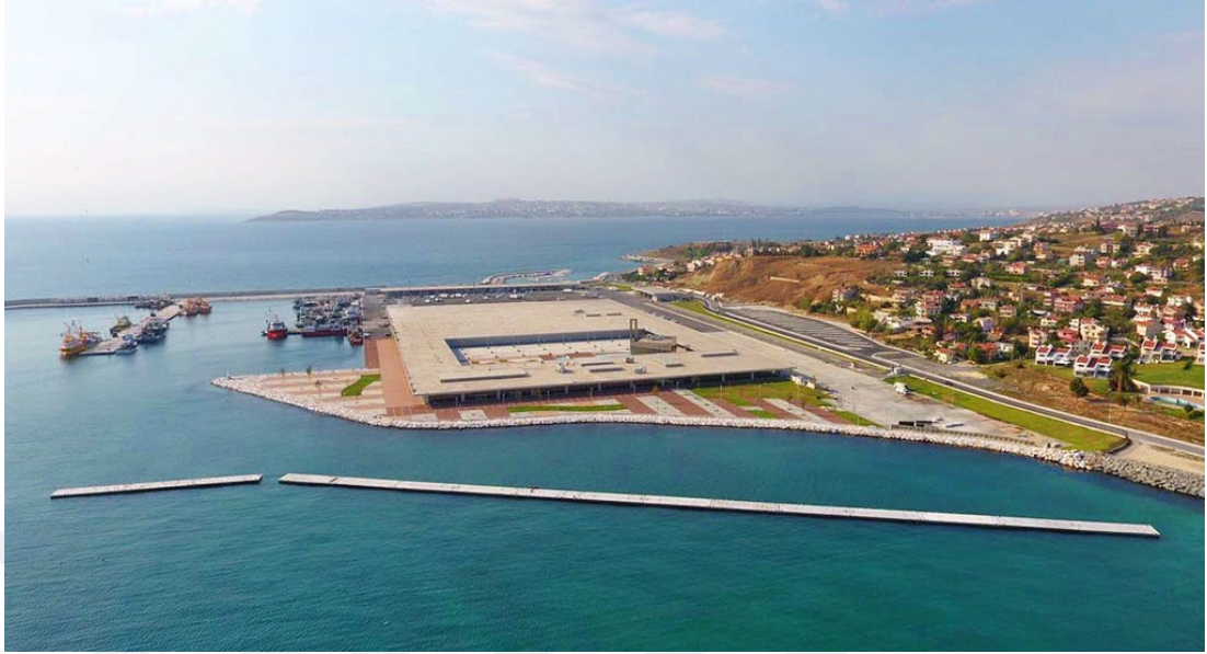
Şekil 2.12 : İBB su ürünleri halinin dikdörtgen kesitli yüzen dalgakıranı (Url-12).
