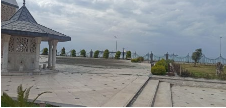
Şekil 3.6: İskenderun sahil şeridinde yapay dolguda bulunan Nihal Atakaş Cami avlusunda gelişen kum kaynaması (Üstün vd., 2023)
