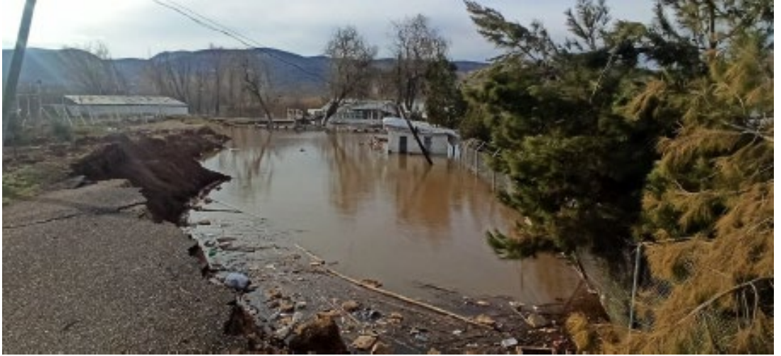
Şekil 3.10: Gölbaşı Gölü kenarındaki sosyal tesisin yanıl yayılma nedeniyle göl içine kayması sonucu oluşan hasar (Gölbaşı, Adıyaman) (Üstün vd., 2023)
