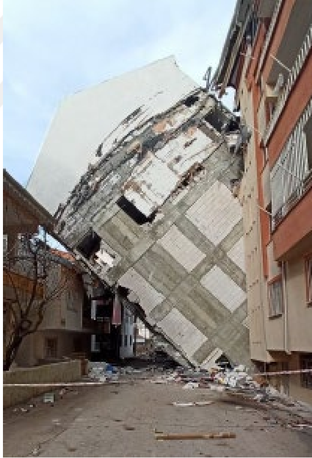
Şekil 3.8: Sıvılaşma sonucu binaların zemin içine gömülmesi (Gölbaşı, Adıyaman) (Üstün vd., 2023)
