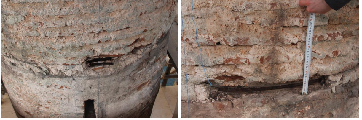
Şekil 3.8: Gövde üst kısmındaki demir çember
