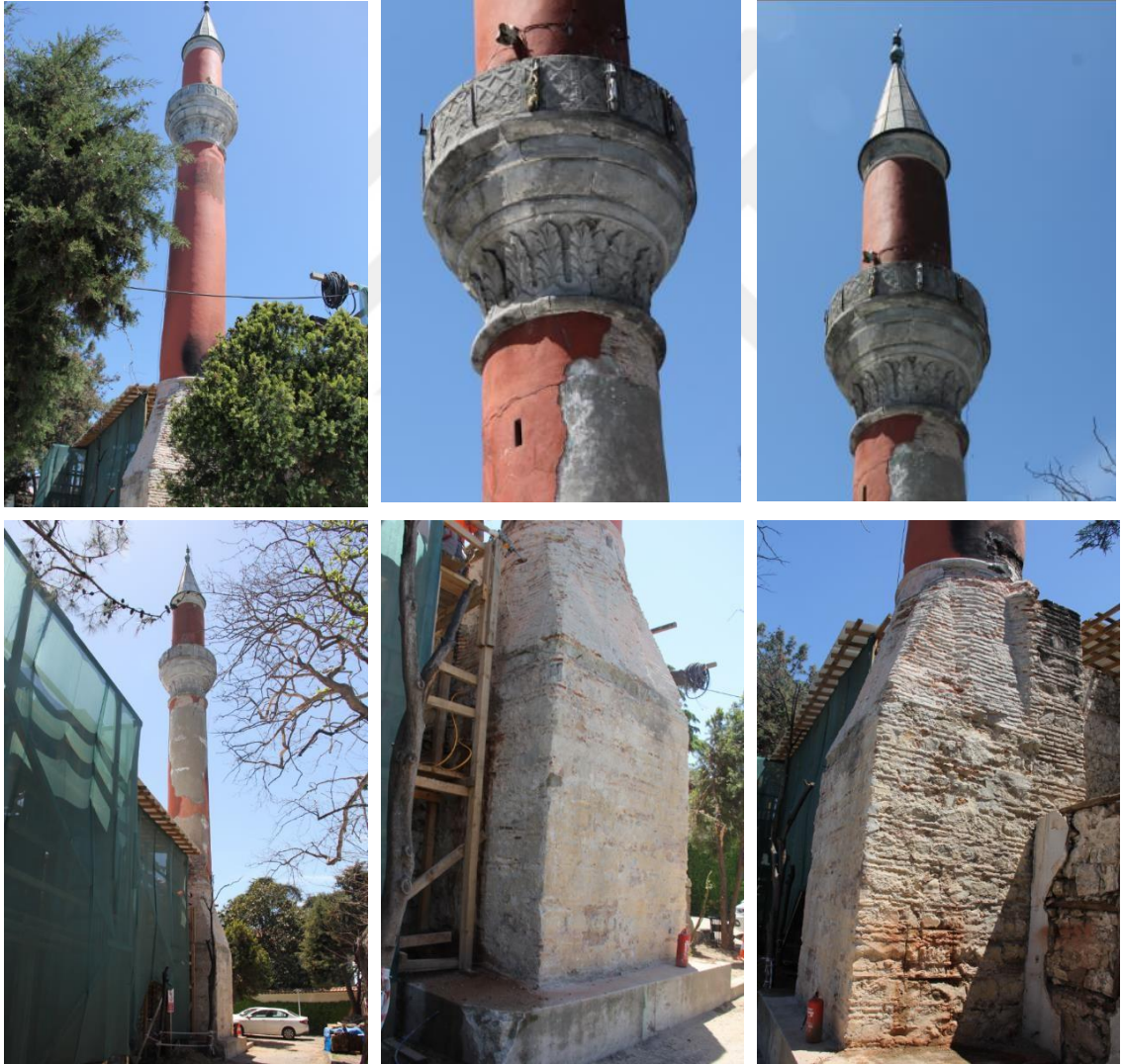
Şekil 3.1: Yapının dış cephe görünüşleri
