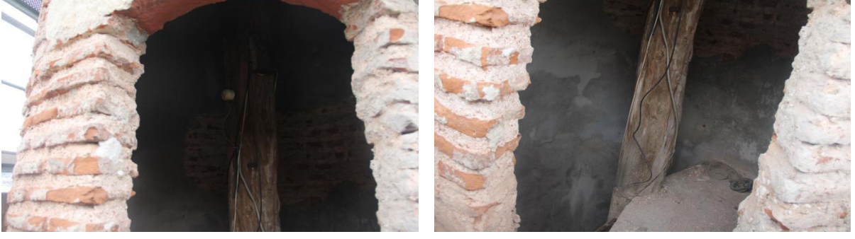
Şekil 3.11: Petek içindeki ahşap seren direği
