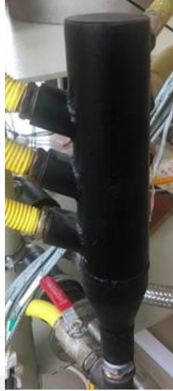
Şekil 3.12. Yakıt kollektörü
