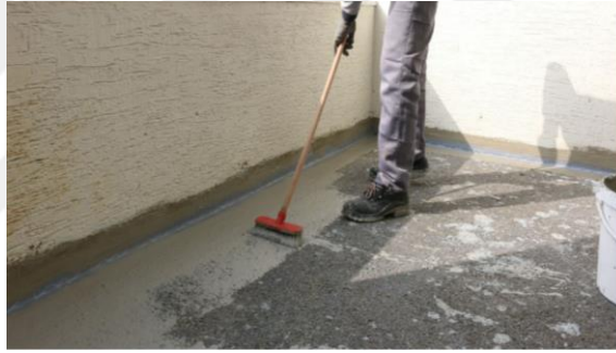
Şekil 2.17. Çimento esaslı su yalıtımı uygulaması ( http-4 )
