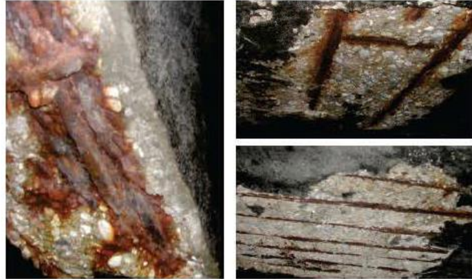
Şekil 2.12. Korozyon hasarı [3]
