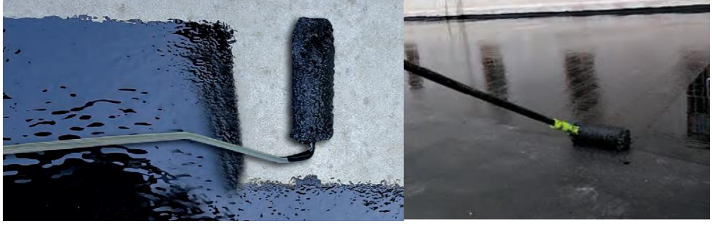
Şekil 2.19. PU esaslı malzeme uygulaması (http-6)
