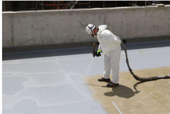
Şekil 2.20. Poliürea esaslı malzeme uygulaması (http-7)
