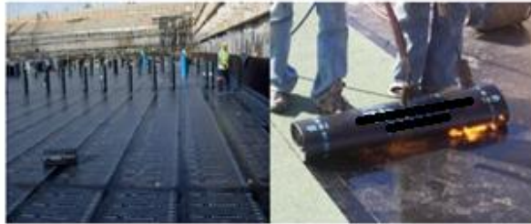
Şekil 2.21. Polimer bitümlü örtü uygulaması [20]
