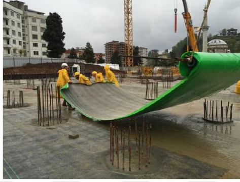
Şekil 2.23. Bentonit şilte [20]
