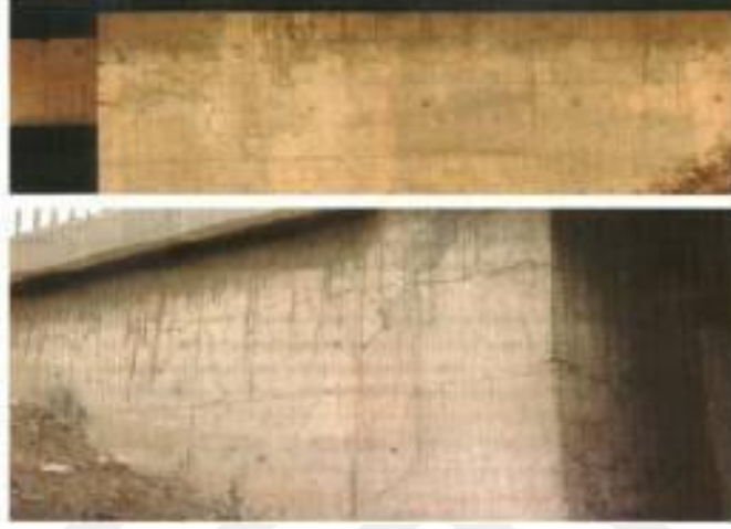
Şekil 2.14. ASR hasarına uğramış beton [23]
