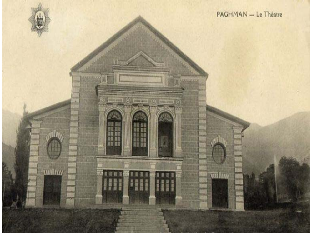
Resim Ek-7.14 : Pagman Tiyatro Binası, 1925
