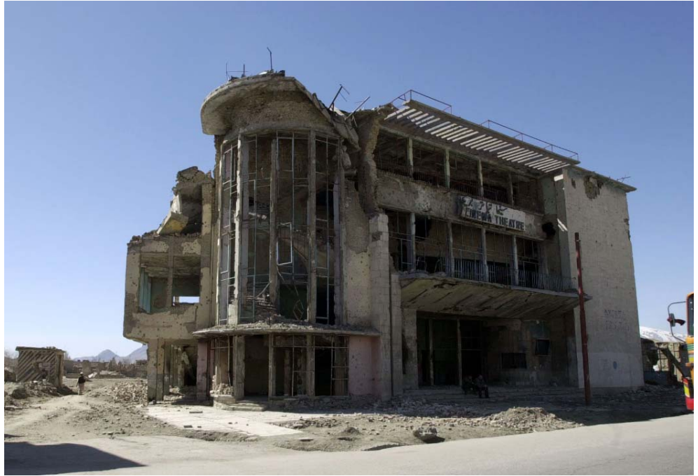
Resim Ek-7.15 : Kabil Tiyatro Binası, 21 Kasım 2001
