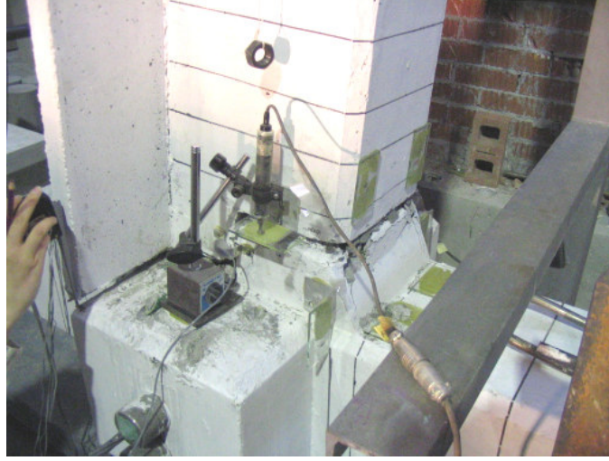
Şekil A. 4 Karma numune #1 kolon gusesi üzerindeki kalıcı deformasyonlar genel görünüş
