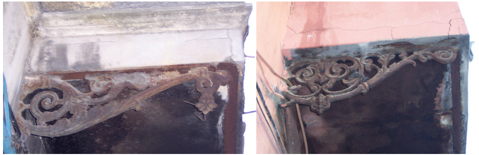
Şekil 4.50. Cumba Altı Dökme Demir Konsol Tiplerine İki Örnek
