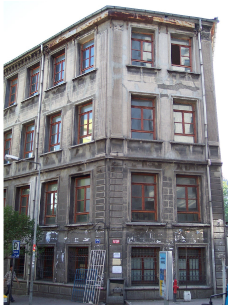
Şekil 4.32. Eski Bölge İdare Mahkemesi Kuzey Görünüşü
