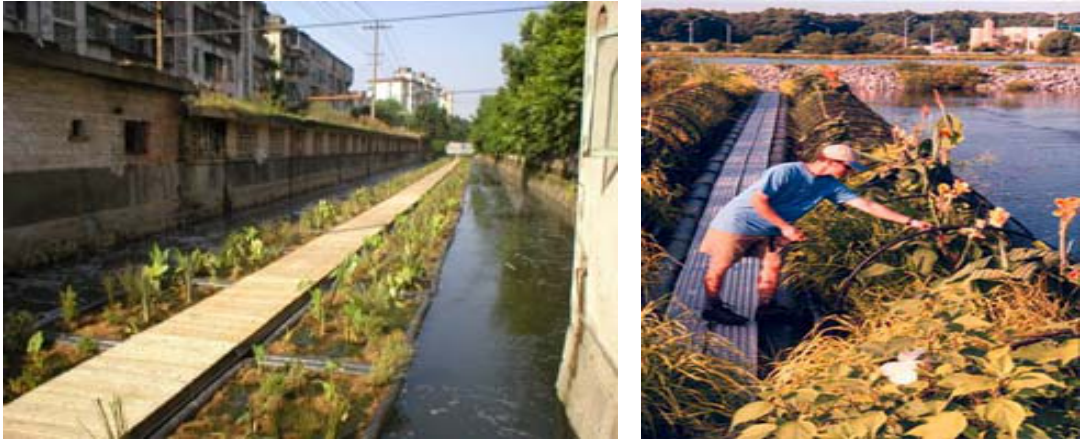
Şekil 4.8 ve Şekil 4.9: Suyu Temizlemek için tasarlanmış yüzen ekosistemler.
