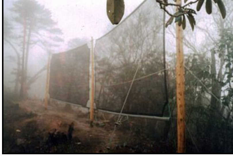
Şekil 4.11: Şili’de Sisten Su Elde Eden Dikey Kolektörler ( http://www.fogquest.org/Projects/nepal/index.shtml )
