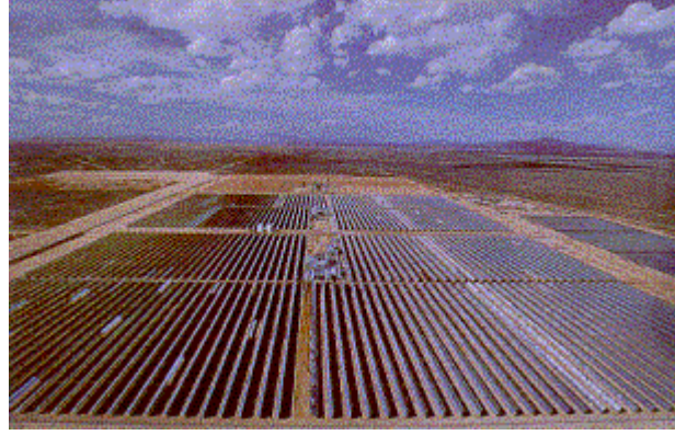
Şekil 3.3: 350 MW gücünde parabolik oluk güneş santrali-Kaliforniya ( www.eie.gov.tr )
