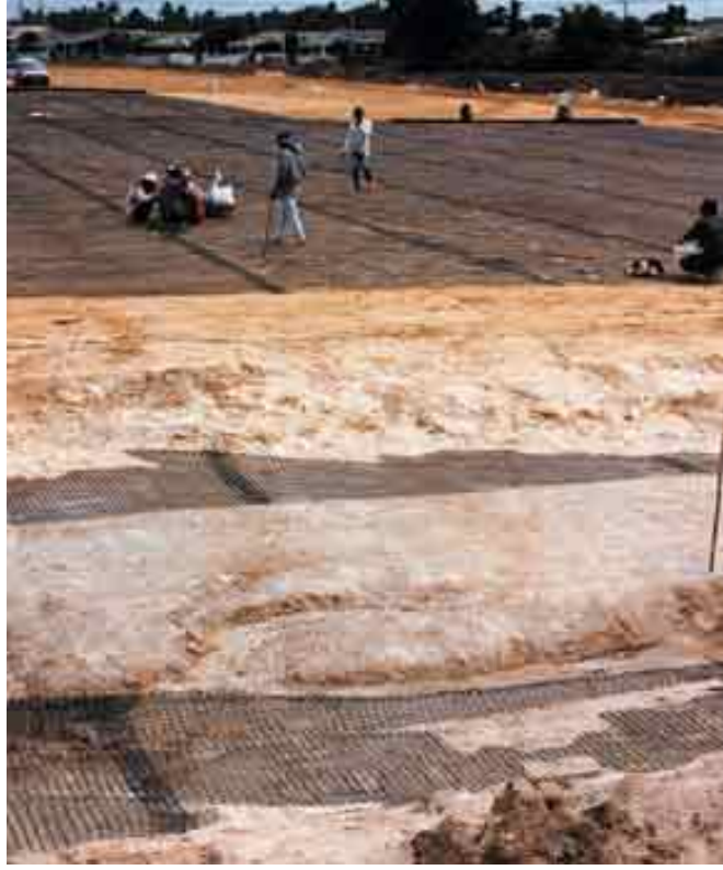
Şekil 3.17 : Geogrid ile zemin iyileştirmesi [12]
