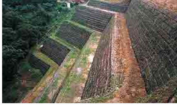
Şekil 3.10: 35m yüksekliğinde duvar uygulaması, Tayvan Chung-Hsin Kasabası [18]
