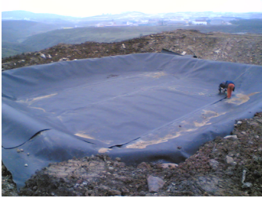
Şekil 2.3 : İzmit'te yapılan bir çöplük arıtma tesisin yalıtımı
