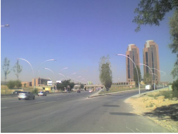
Şekil 6.8-a: İşaretlemeler yapılmadan önceki görünüş
