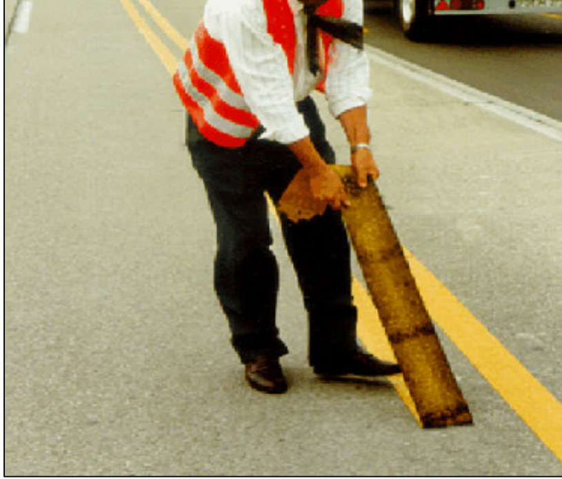
Şekil 5.11: Yol Bandının Sökülmesi
