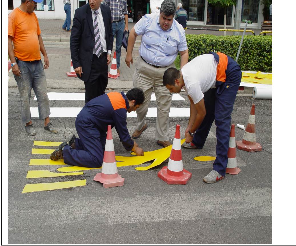
Şekil 5.12-a:Yol Bantlarının Uygulama Aşaması
