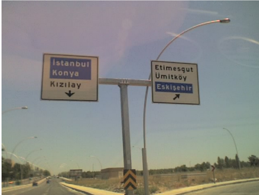
Şekil 6.11-b: Sistem Levhası Uygulaması
