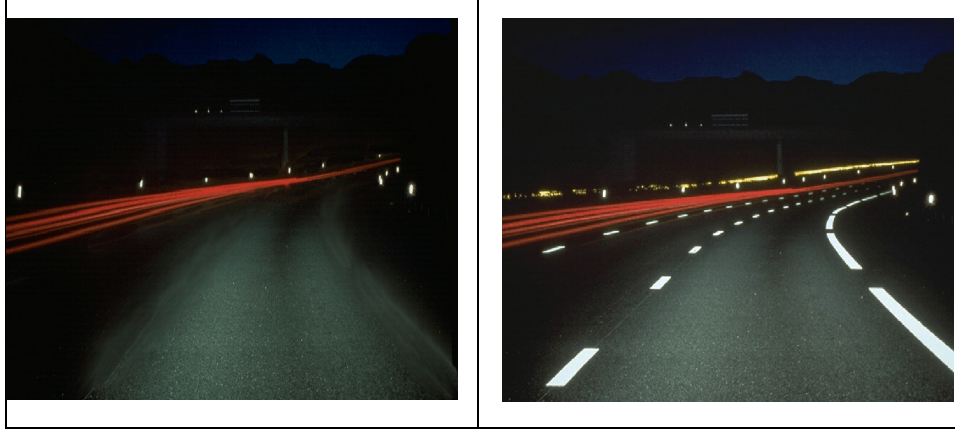
Şekil 4.2: Yatay Eksende İşaretleme Yapılmadan Önce ve Yapıldıktan Sonra Yol Kesiminin Görünümü
