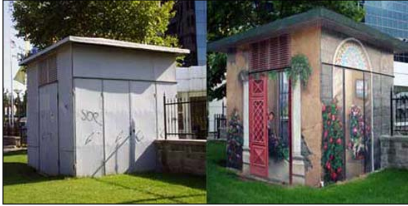
Şekil 4.94. Yenilenmiş Trafo Örneği
