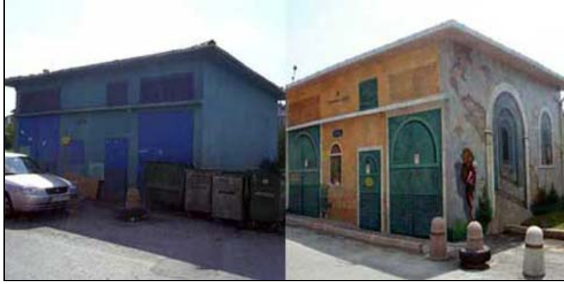
Şekil 4.93. Yenilenmiş Trafo Örneği
