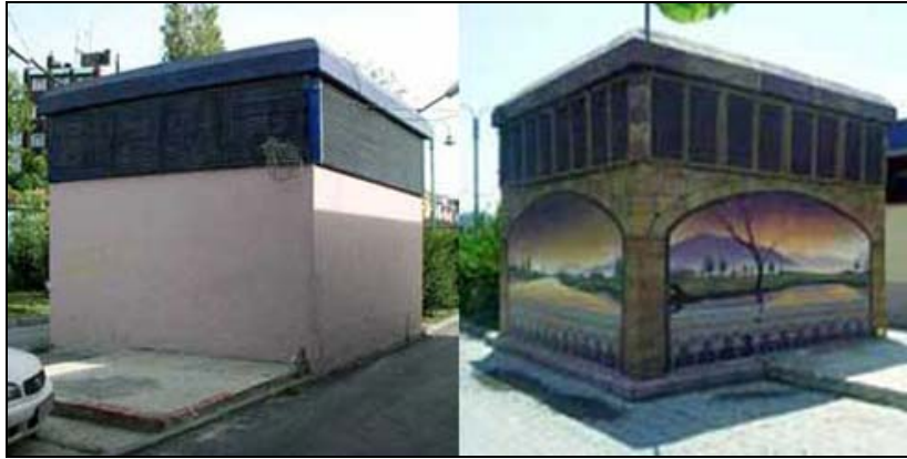
Şekil 4.95. Yenilenmiş Trafo Örneği
