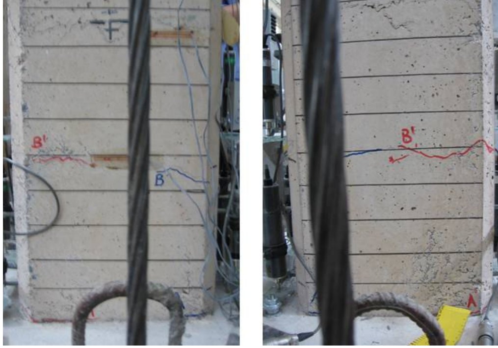
Şekil Ek A. 3 : Çatlak Bölgesi (Ö.O. : % 0.75)
