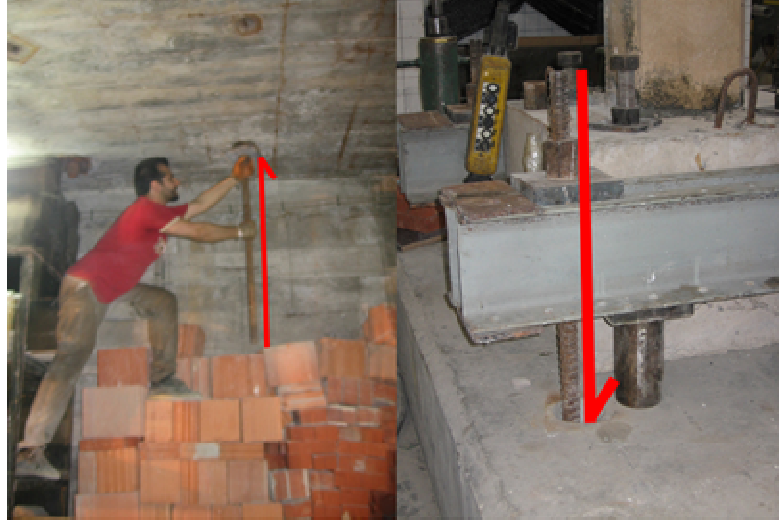
Şekil 3.38 : Yüksek Mukavemetli Bulonların Yerleştirilmesi
