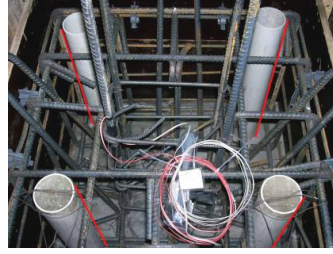
Şekil 3.13 : Plastik PVC Boru Yerleşimi
