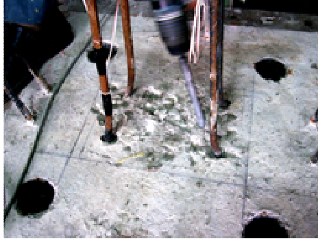
Şekil 3.18 : Pürüzleme İşlemi
