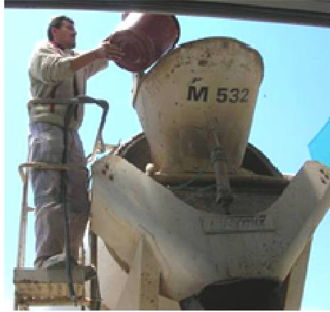
Şekil 3.21 : Betona \text{CaCl}_2 Çözeltisinin Eklenmesi
