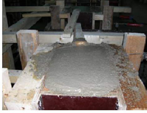
Şekil 3.22 : Kolon Numunelerinin Beton Dökümü
