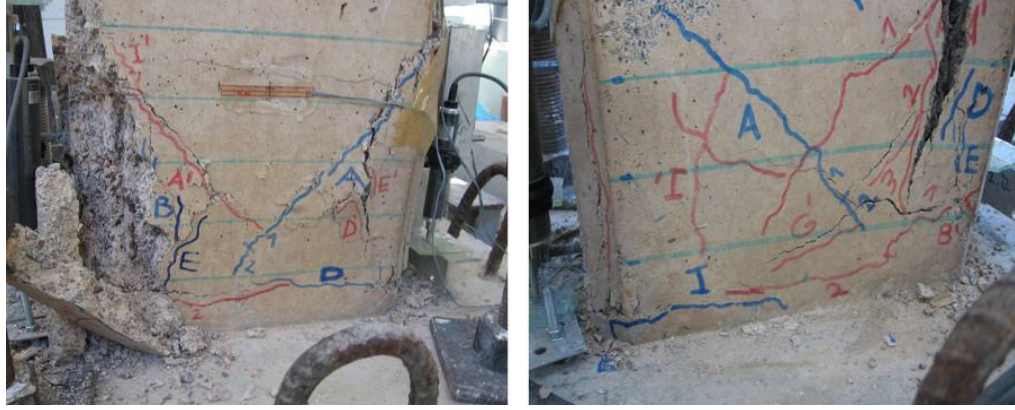
Şekil Ek A. 27 : Çatlak Bölgesi (Ö.O. : % 3.00)
