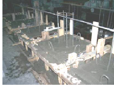
Şekil 3.14 : Temel Betonu Dökümü
