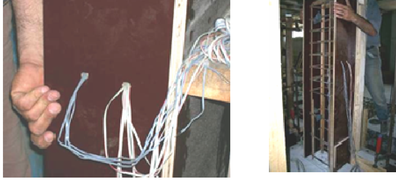
Şekil 3.20 : Kolon Kalıplarının Yerleştirilmesi
