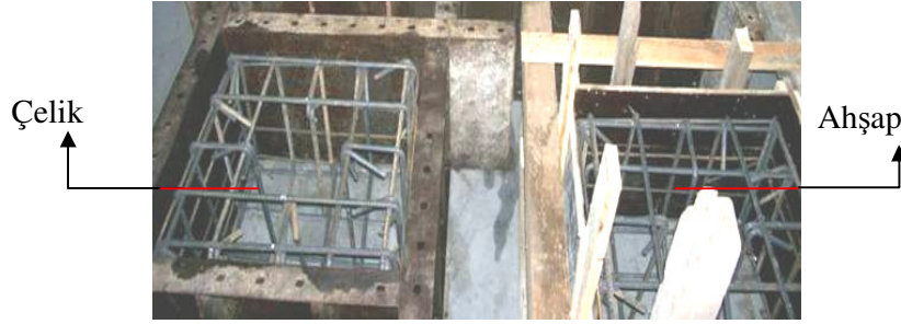
Şekil 3.10 : Çelik Ve Ahşap Kalıplar
