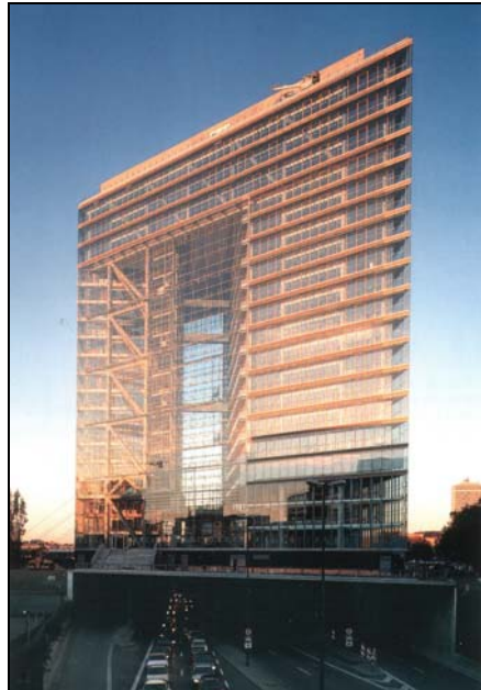
Şekil 2.31: Ara boşluğu kat yüksekliğinde sınırlandırılmış çift kabuklu cephesi olan Düsseldorfer Stadttor
