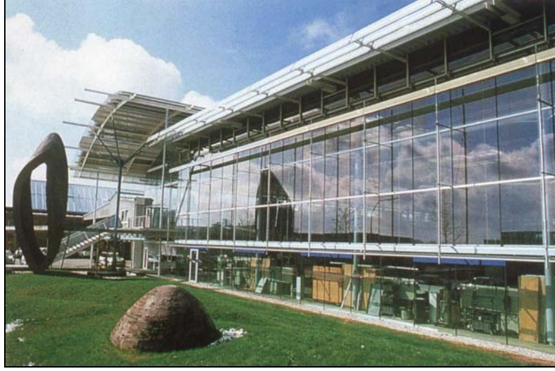
Şekil 2.9: Güneşin değişen açılara ve hava koşullarına göre ayarlanabilen lamellerin yer aldığı Seele binası
