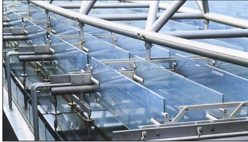
Şekil 2.12: Hologramlı cam lameller doğrudan gelen ışığı yansıtırken yayınlık ışık iç ortama geçebiliyor
