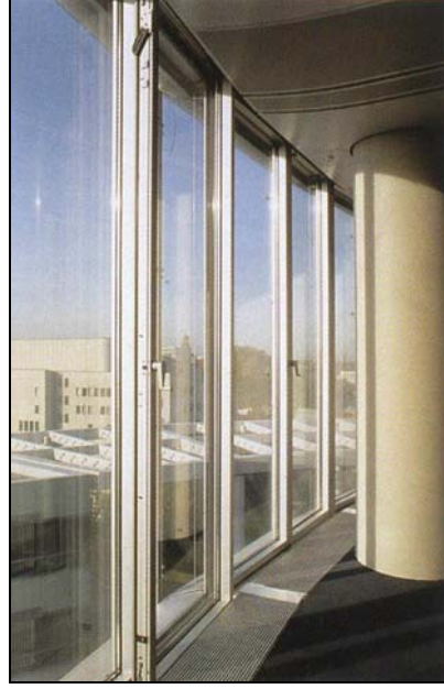
Şekil 2.30: İç tarafta yer alan kabuk üzerinde yer alan kat yüksekliğinde yatay sürme doğramalar (RWE Binası)
