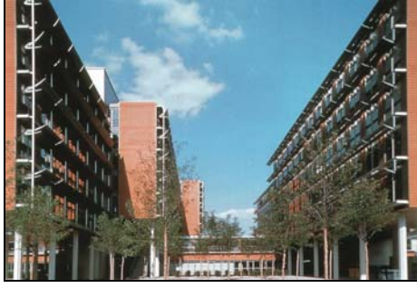
Şekil A.20: Yönetim Binası, Wiesbaden
