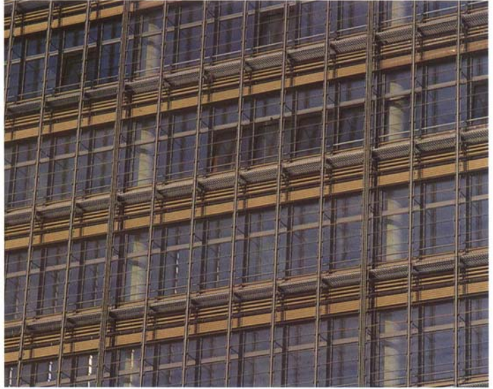
Şekil 2.35: Dış kabuğu oluşturan hareketli cam lamellerin ara boşluktan ve dıştan görünüşü (Debis Binası)
