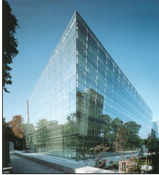
Şekil 2.38: Yapı yüksekliğinde bölüntüsüz ara boşluklu çift kabuklu cephe sisteminin uygulandığı Victoria Ensemble binası
