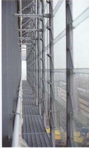
Şekil 2.35: Dış kabuğu oluşturan hareketli cam lamellerin ara boşluktan ve dıştan görünüşü (Debis Binası)
