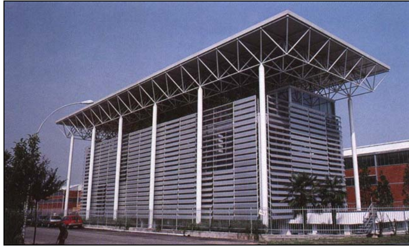
Şekil 2.10: Büyük boyutlu, eksenleri üzerinde dönebilen lameller etkin güneş kontrolü sağlamaktadır Almanya'nın Gundelfingen bölgesinde yapılmış olan Gartner & Co tasarım ofisinin cephesinde kullanılmış olan, eksenleri üzerinde dönebilen, özel yansıtıcı cam lameller dış ortama doğru olan görüşe kısıtlama getirmeyen özelliğe sahiptir (Şekil 2.11).
