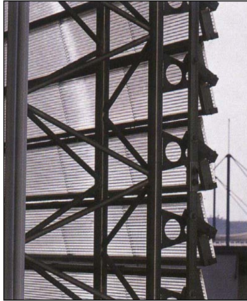
Şekil 2.17: Prizmatik akrilik panellerden oluşan hareketli güneş kontrol sistemi detayı (İspanya Expo '92 Siemens pavyonu)
