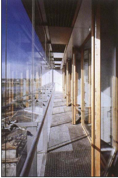
Şekil 2.34: Yürünebilen ara boşluğa açılan eksenli kapılardan oluşan iç kabuğun ve dış kabuk üzerinde yer alan korkuluğun görünüşü (Düsseldorfer Stadttor)
