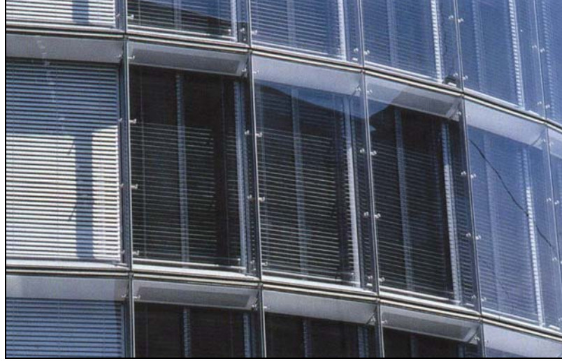
Şekil 2.28: Ara boşluğu kat yüksekliğinde sınırlandırılmış çift kabuklu cephe sisteminin uygulandığı bir örnek (RWE Binası)
