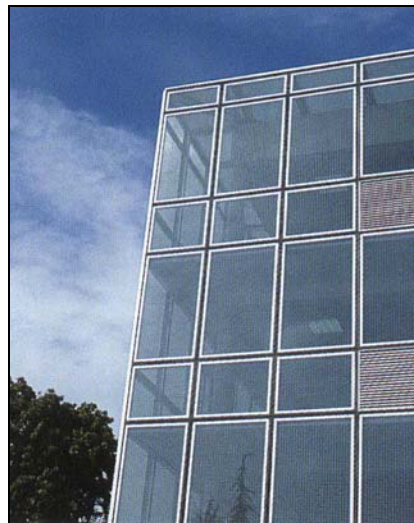
Şekil 2.19: Cam ünitenin ara boşluğunda yer alan delikli, sabit alüminyum lamelli entegre güneş kontrol elemanları
