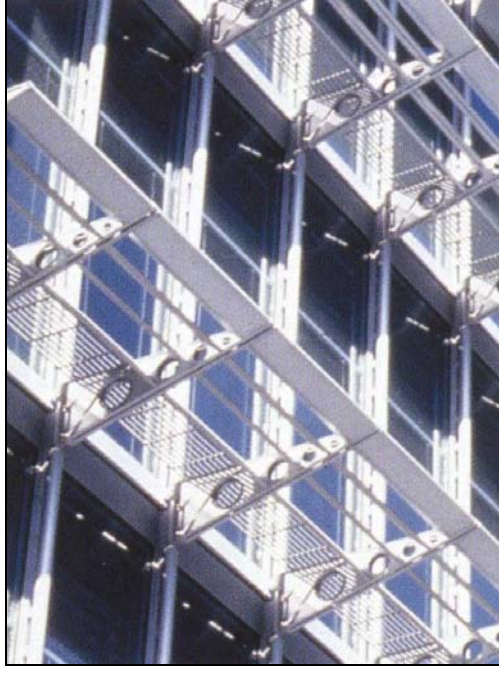
Şekil 2.7: Dış tarafta yer alan belirli açıda yerleştirilmiş sabit lameller etkin güneş kontrolü sağlarken aşağıya bakışı engellemiyor (Hongkong ve Shanghai Bankası cephe sistemi)
