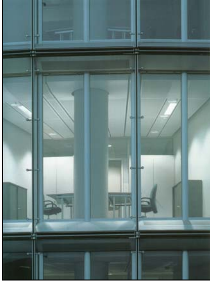
Şekil A.16: RWE Cephe Görünüşü, Essen
