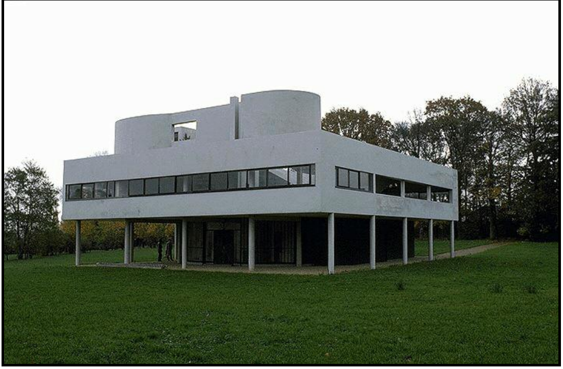
Şekil 2.1.1.1.: Le Corbusier'nin Villa Savoye Binası
