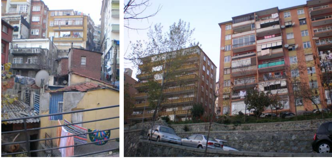
Şekil 3.14. Şekil 3.13.'teki sokağın sol tarafındaki gecekondu ve sağ tarafındaki apartmanlar
