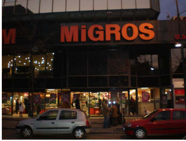
Şekil 3.28. Migros alışveriş merkezi- Şişli
