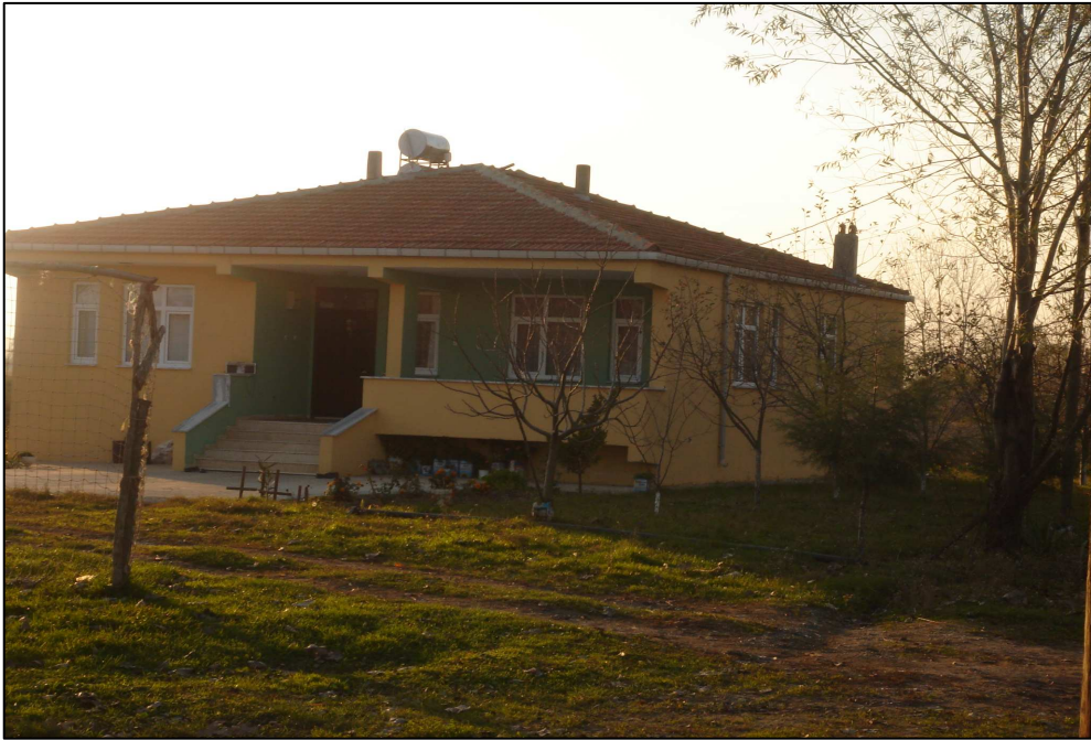
Foto 8.Türbe köyündeki modern konutlardan bir görünüm.
