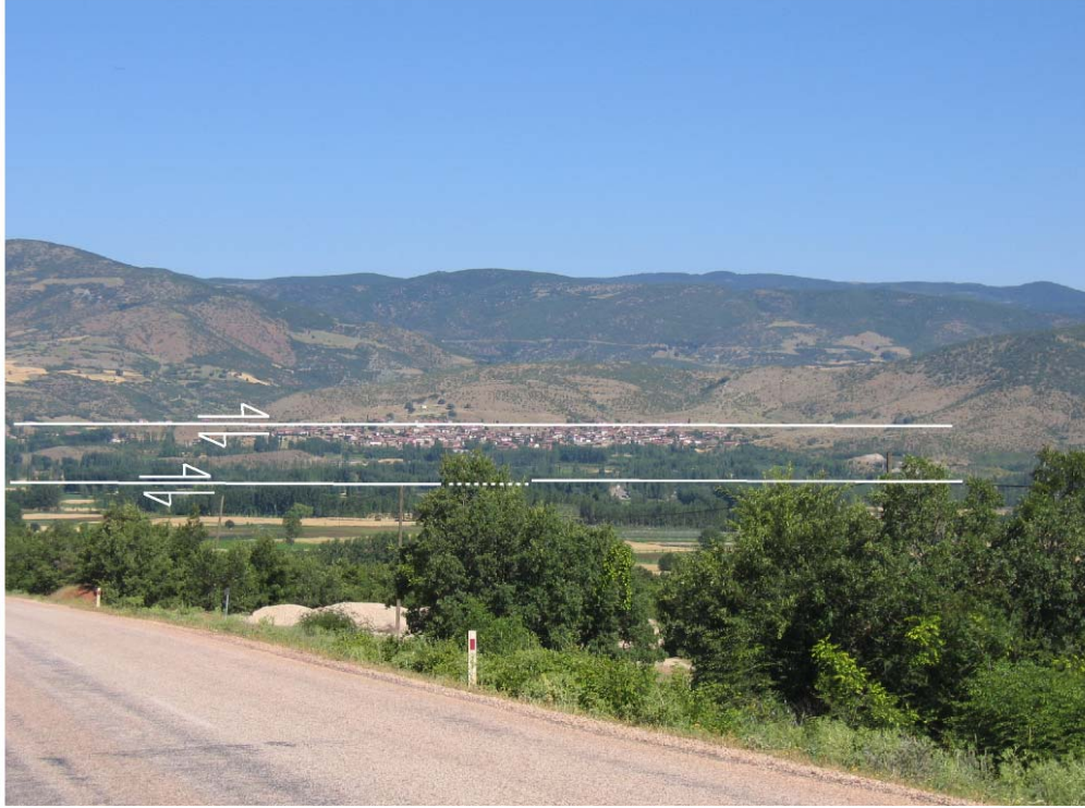
Şekil 3.1: Kızılköy Civarında Almus Fay Zonu'nu Kuzey Kolunu Oluşturan Doğrultu Atımlı Sağ Yönlü Aktif Mercimekdağ-Çamdere Fay Setinin Görünümü
