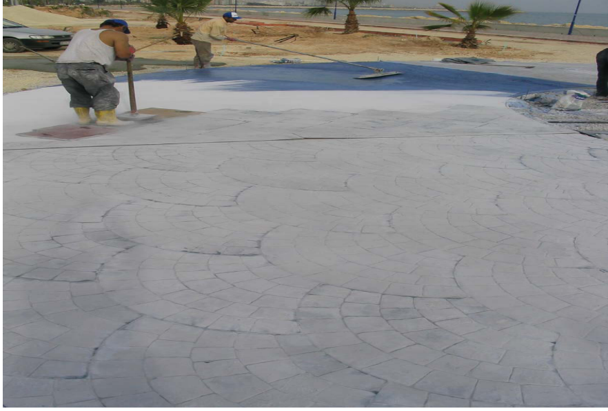
Şekil 2.9. Tamponla vurulması
