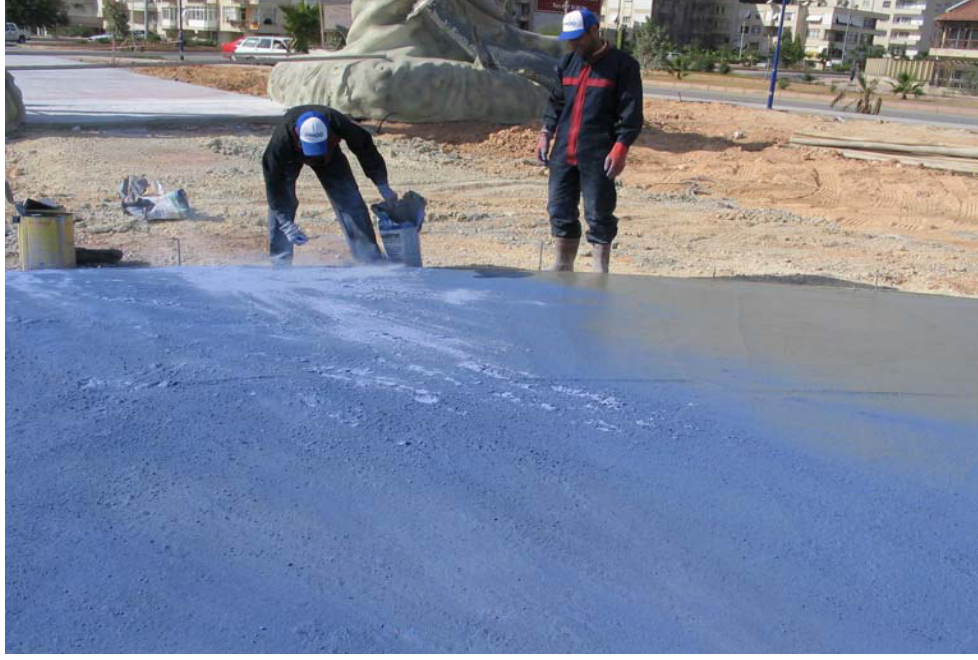
Şekil 2.8. Renklendirilmesi
