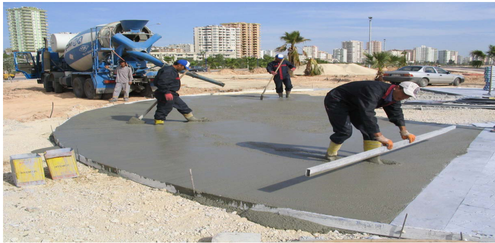
Şekil 2.7. Mastarlanması
