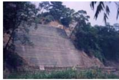
Donatılı Şev (38 m yükseklik)
