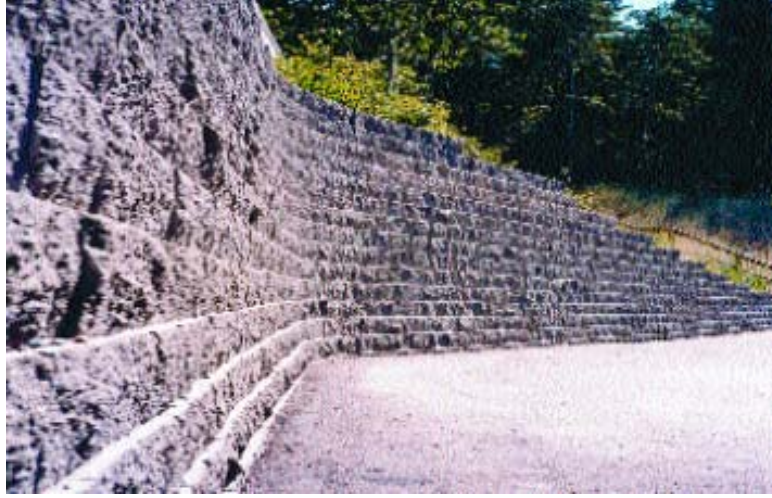
Şekil 3.8 : Geotekstil Donatılı İstinat Duvarı (Roven-Fransa, 1971)
