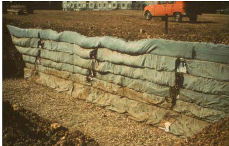
Şekil 3.7 : İlk Geotekstil Donatılı İstinat Duvarı (Roven-Fransa, 1971)
