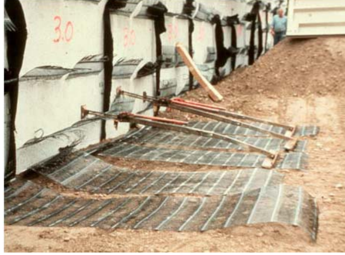
Şekil 3.10 : Geotekstil Donatılı İstinat Duvarı İmalatı (Roven-Fransa, 1971)
