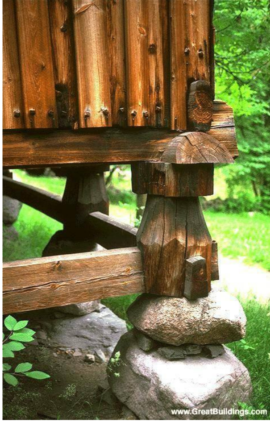
Şekil 2.6. Norveç'te bir çiftlik evinden birleşim detayı (www.greatbuildings.com)
