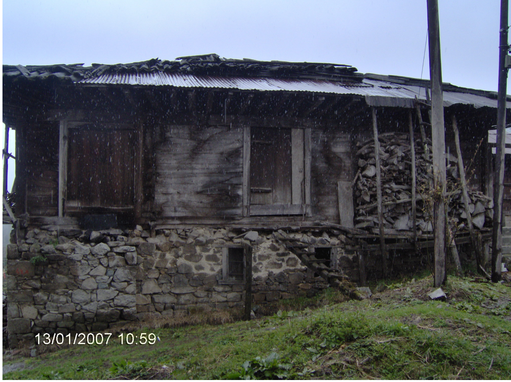
Şekil 3.16. Büyükdere Vadisi evleri arka cephesine örnek
