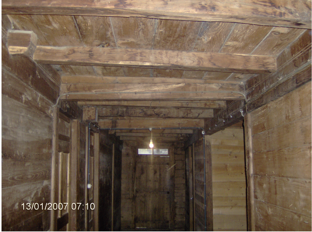
Şekil 3.14. Büyükdere Vadisi evleri taşıyıcı sistemi
