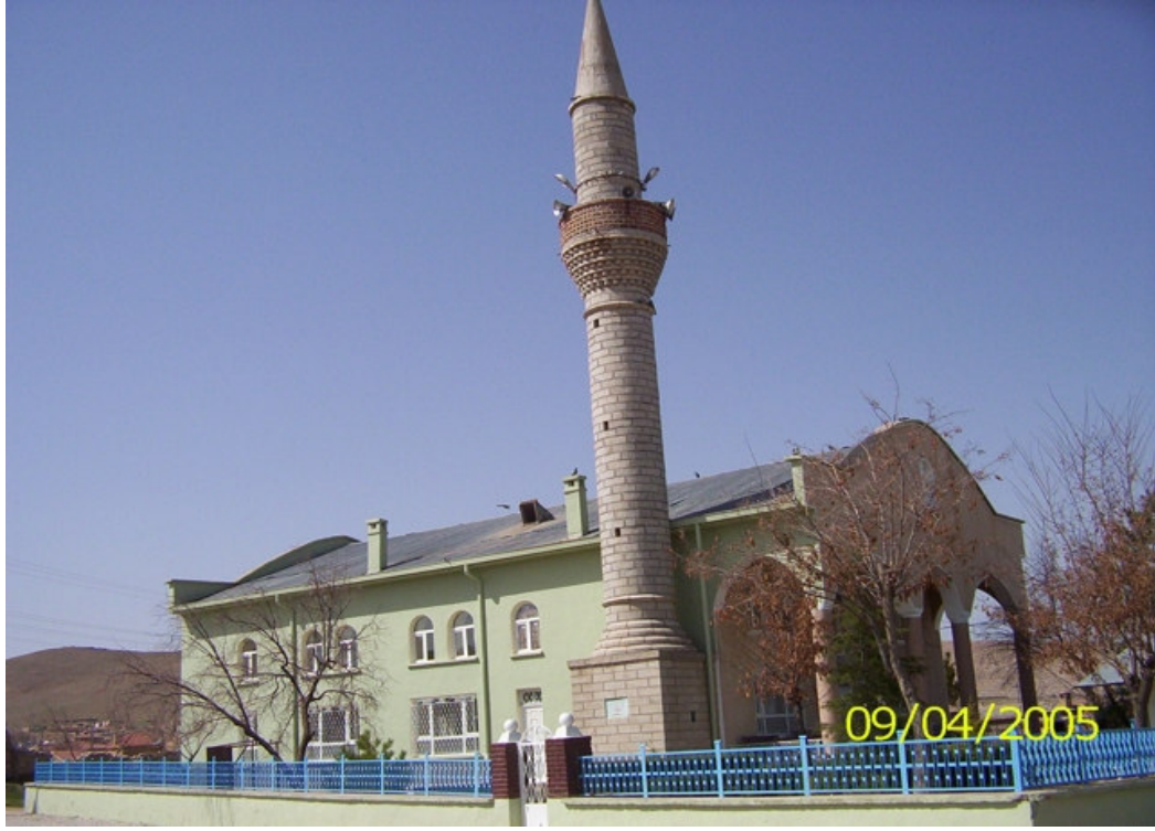
Resim 3. Yağlıbayat Köyü Camii
