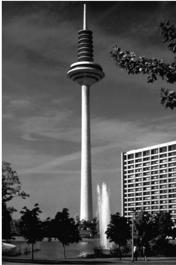
Şekil 1.8 Frankfurt/Main Telekomünikasyon Kulesi
