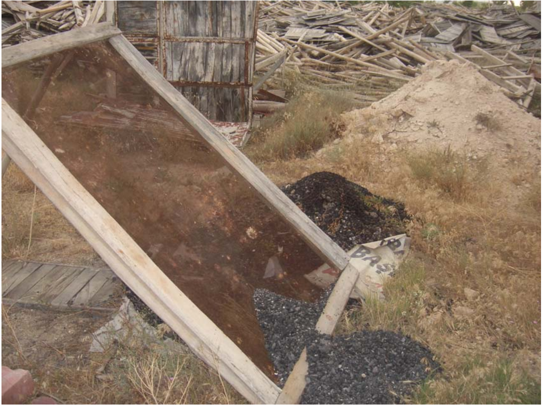
Resim III.3. Sistem kurulumunda kömür eleme
