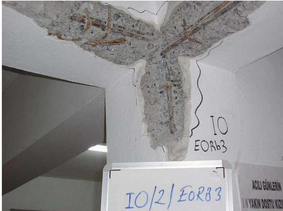
Şekil 5.5 Tahribatlı Kiriş Kırım Testleri
